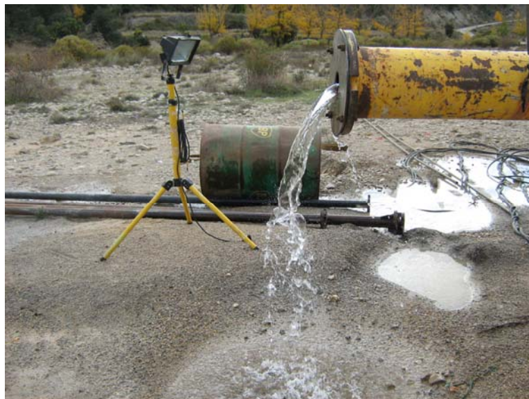
Momentos finales del ensayo, tercer escalón (0,3 l/s, agua clara)
