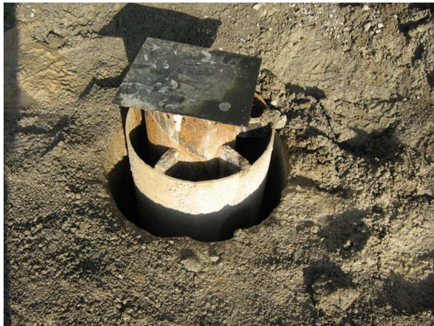
Sondeo tapado a la espera de la testificación geofísica y el engravillado
