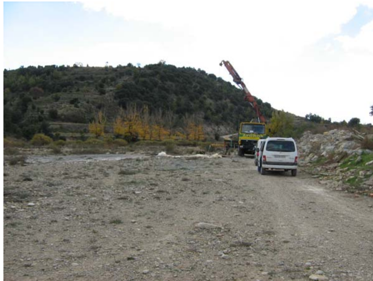
Vista del emplazamiento durante el ensayo
