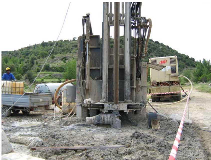
Perforando a 230 m de profundidad (sin barrido)
