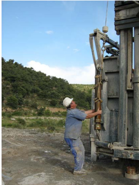
Extrayendo el martillo de 165 mm de diámetro
