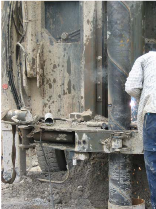
Soldando un tramo de tubería ciega al segundo tramo ranurado
