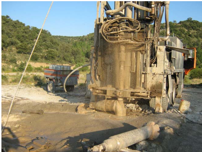
Perforando a 342 m de profundidad
