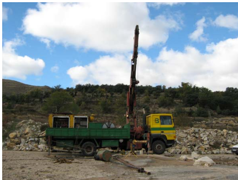
Emplazamiento y equipo de bombeo instalado
