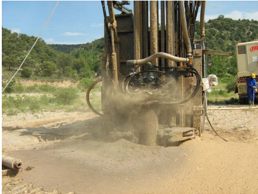
Momento en que se comienzan a perforar las arcillas grises (unos 4 m de profundidad)
