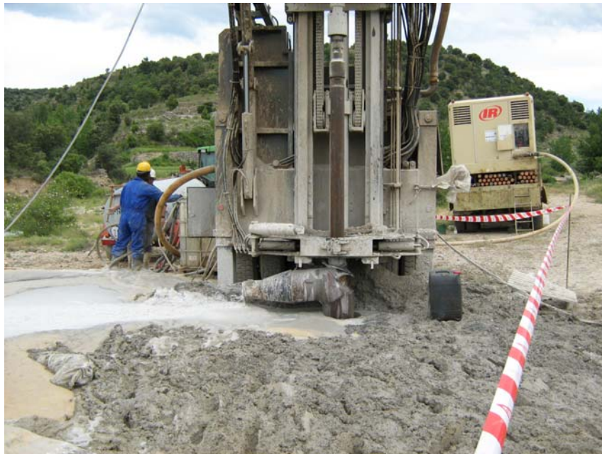
Perforando a 150 m de profundidad
