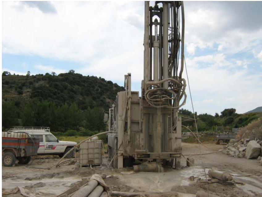
Perforando a 366 m de profundidad
