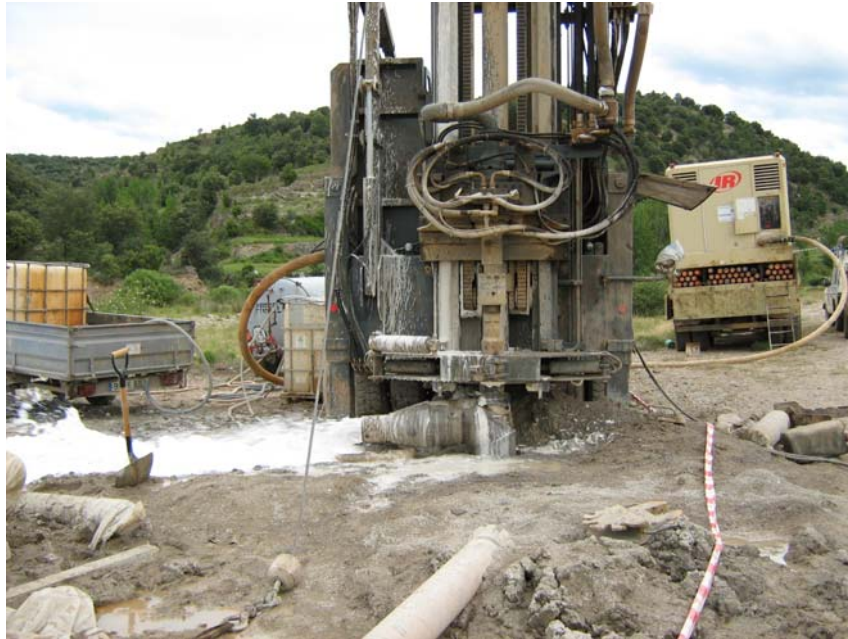
Perforando a 290 m de profundidad
