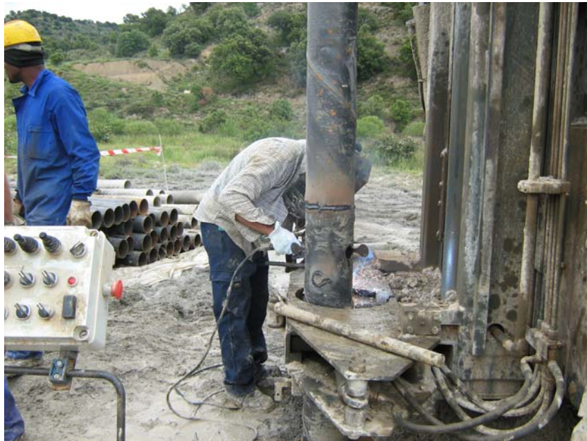
Soldando dos tramos de tubería ciega
