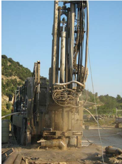
Momento en que se comienza a inyectar aire (abundante agua y ripio)
