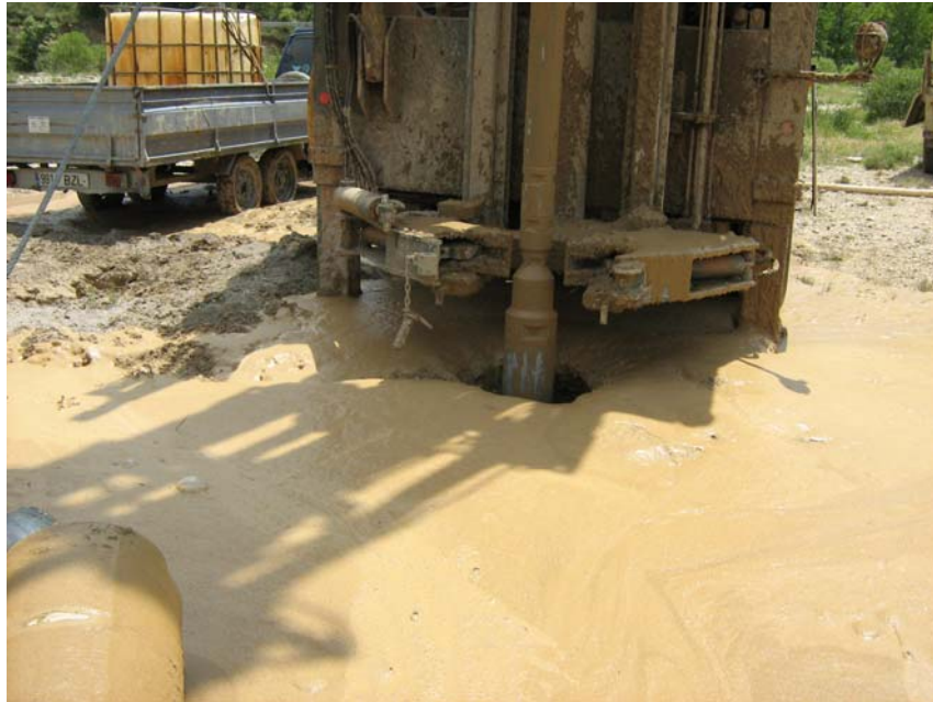
Perforando a 324 mm, inyectando agua y espumante
