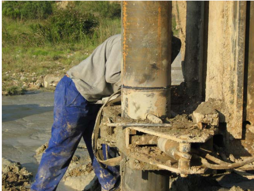
Soldando 2 tramos de tubería ciega de 300 mm de diámetro
