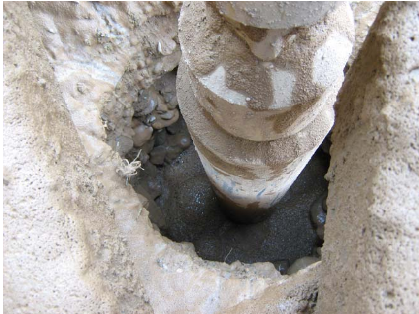
Vista del interior de la perforación (obsérvese las gravas del río)
