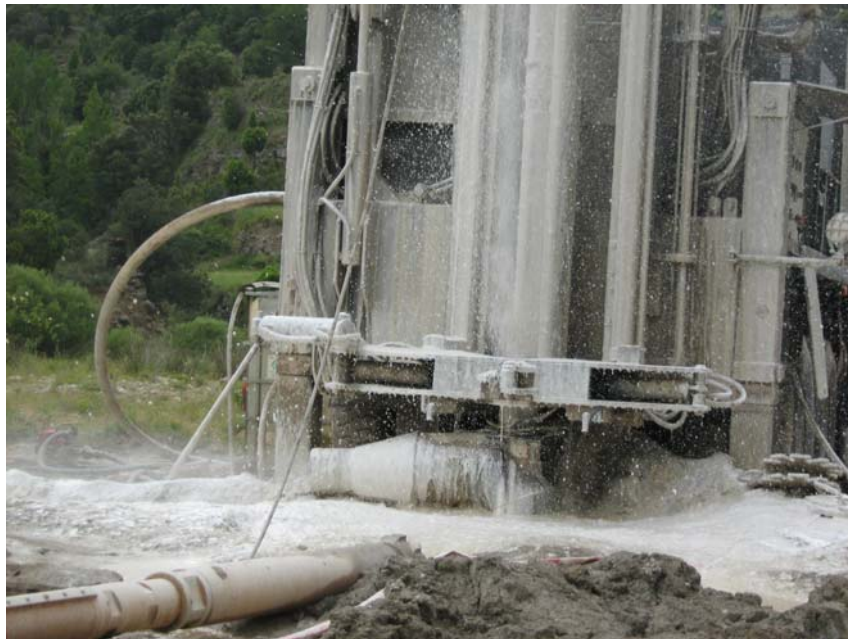
Perforando a 320 m de profundidad (el color blanco se debe al espumante)
