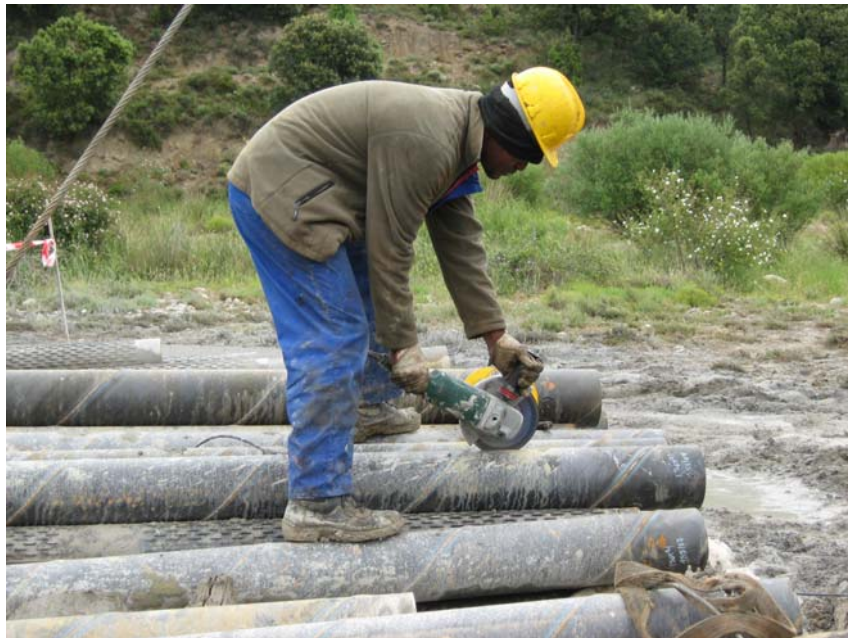
Ranurando un tramo de tubería ciega con la radial
