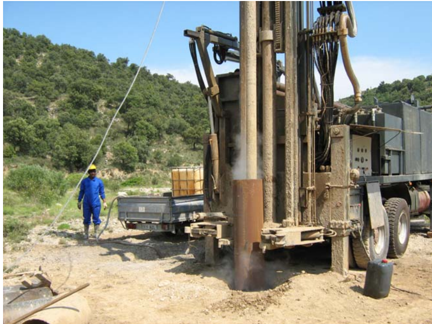
Comienzo de la perforación a 324 mm (perforando en las gravas cuaternarias)
