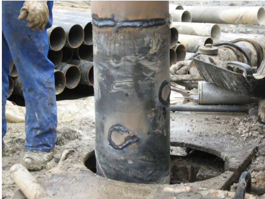
Detalle soldadura entre tuberías y cerrando orejetas
