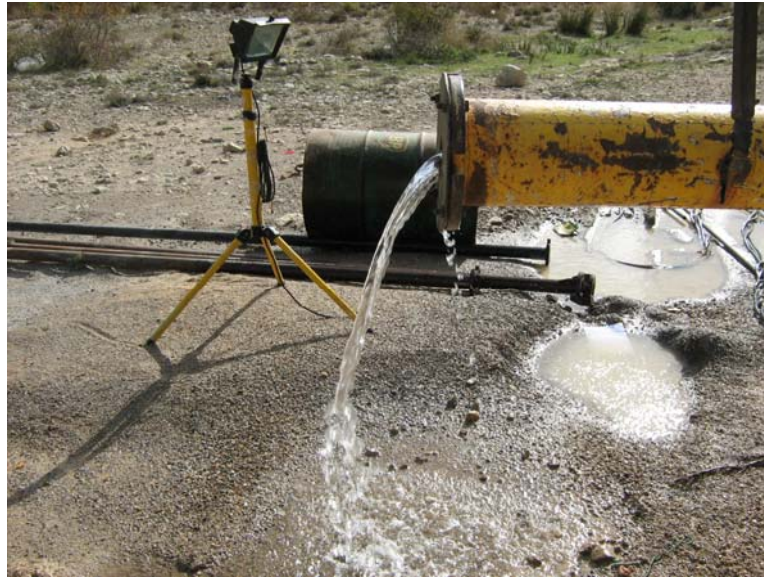
Tercer escalón (agua clara, 0,3 l/s)
