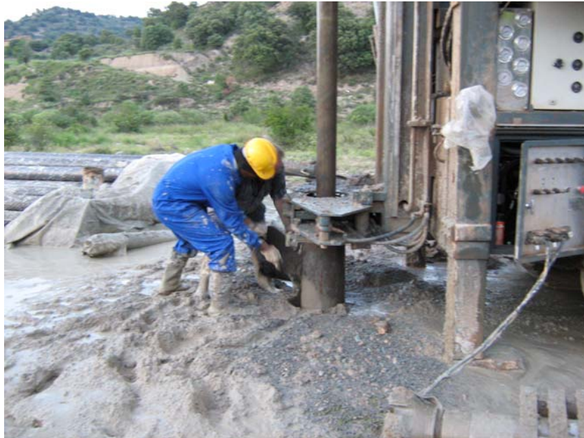
Cementando el espacio entre la pared y la tubería de 300 mm
