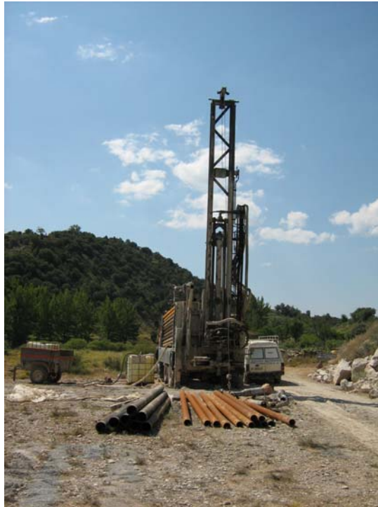
Maquinaria en el emplazamiento de nuevo
