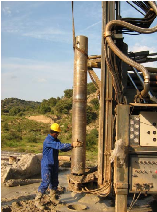
Introduciendo la tubería de 300 mm por el interior de la de 400 mm
