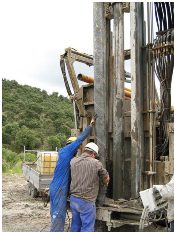
Colocando un tramo de tubería ciega para ser soldado
