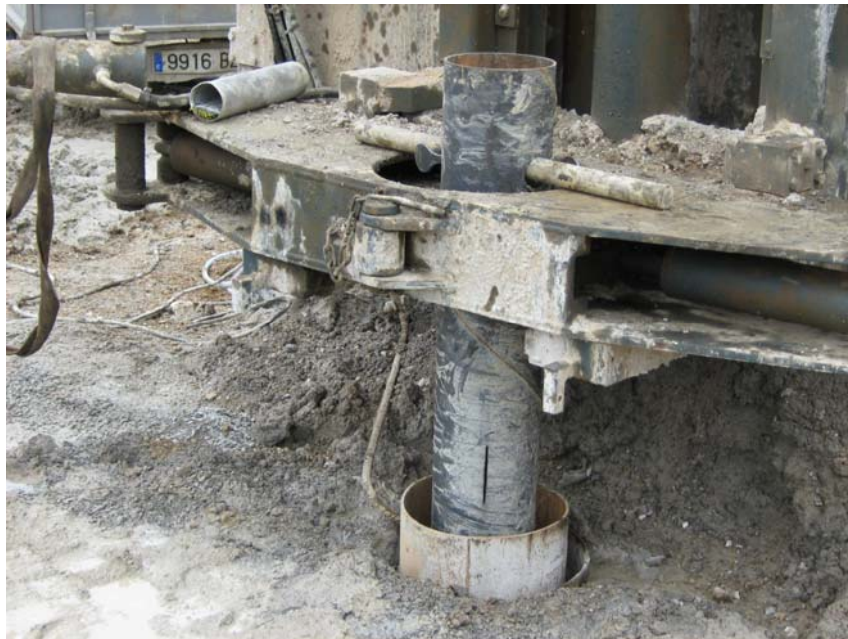
Primer tramo de tubería ciega ranurada introducido (obsérvese una de las ranuras)
