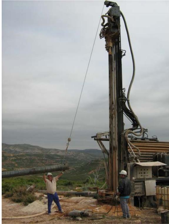
**Elevando un tramo de 6 m de tubería ciega de 250 mm de diámetro**
