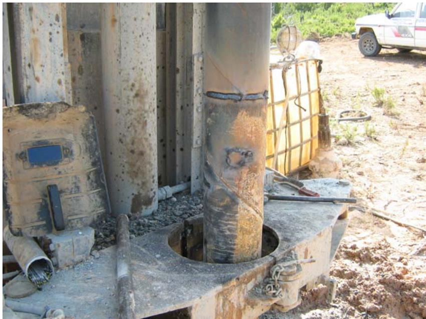
**Soldadura entre tuberías y cerrando orejetas**
