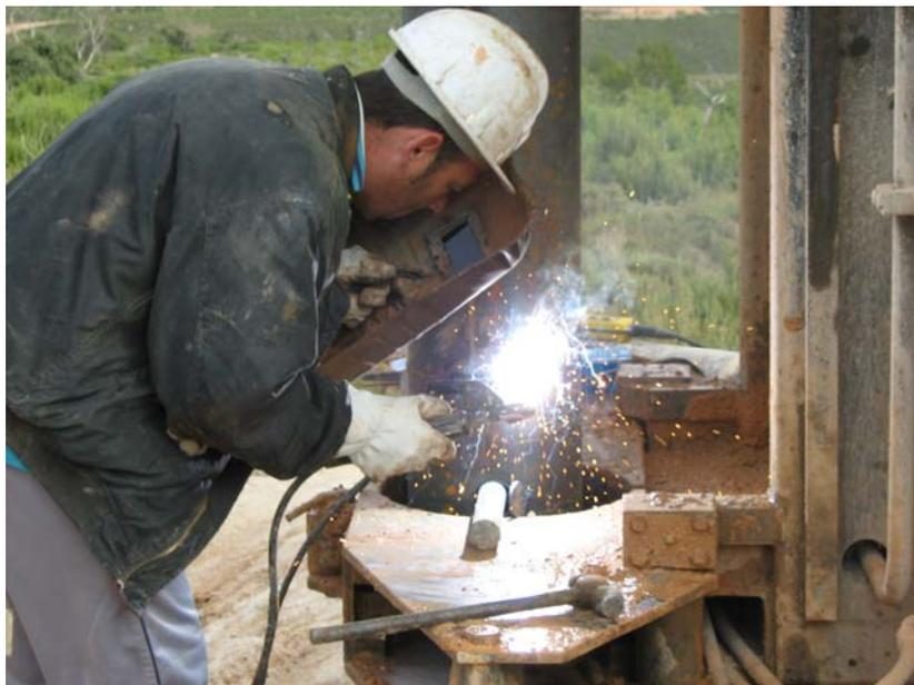
**Soldando 2 tramos de tubería ciega de 250 mm**
