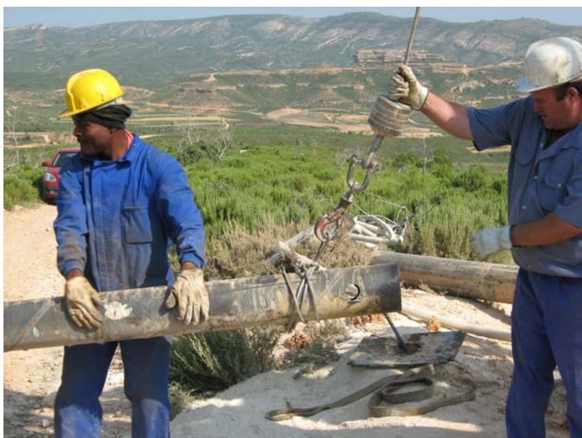
**Detalle: unión cablestante-tubería para ser elevada**
