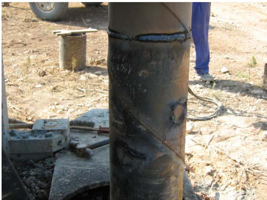
**Detalle soldadura entre tuberías de 180 mm y cerrando orejetas**
