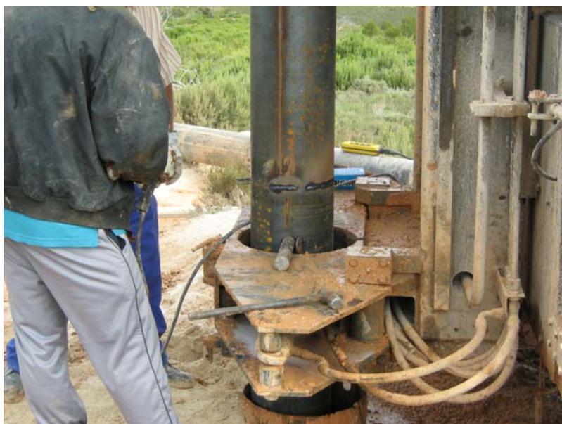
**Soldando dos tramos de tubería ciega de 250 mm de diámetro**
