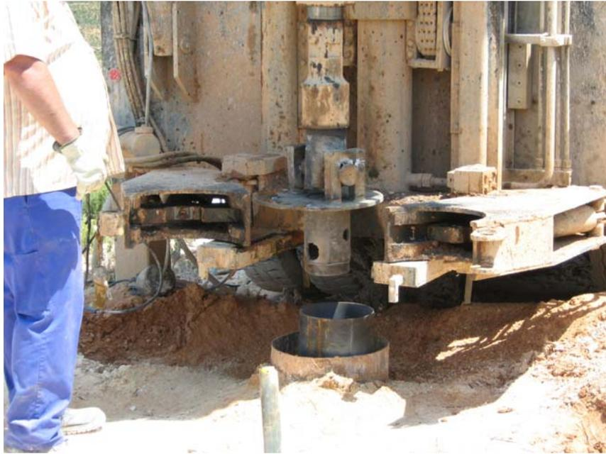
**Último tramo de tubería ciega de 250 mm apoyada a 102 m de profundidad**
