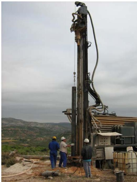
**Introduciendo un tramo de tubería ciega de 250 mm**
