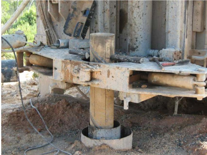
Sujeción de la tubería de 180 mm antes de ser soldada al siguiente tramo
