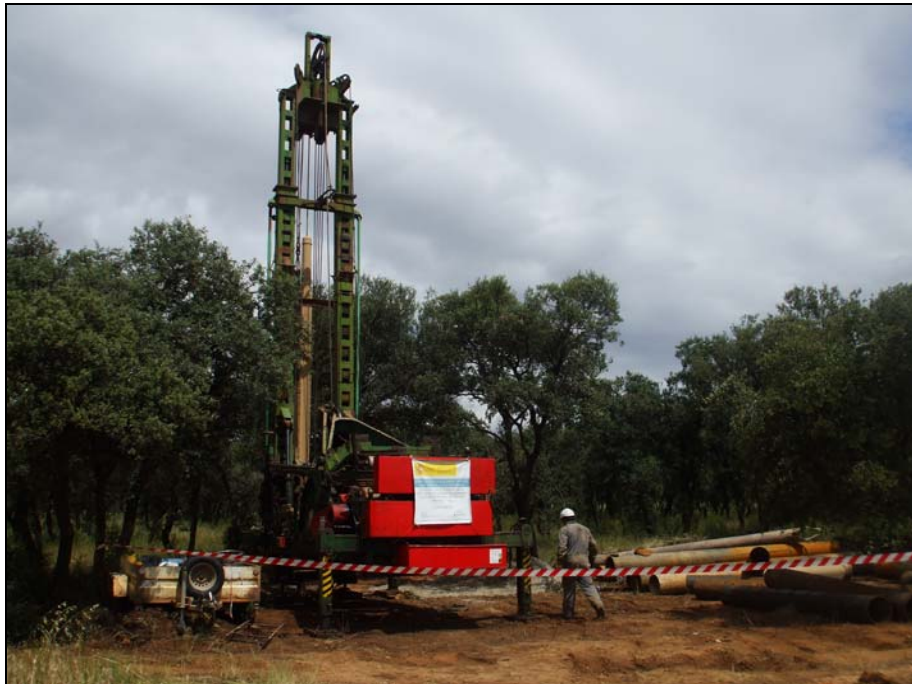
Imagen 2. Vista general del emplazamiento del sondeo de Huesca.
