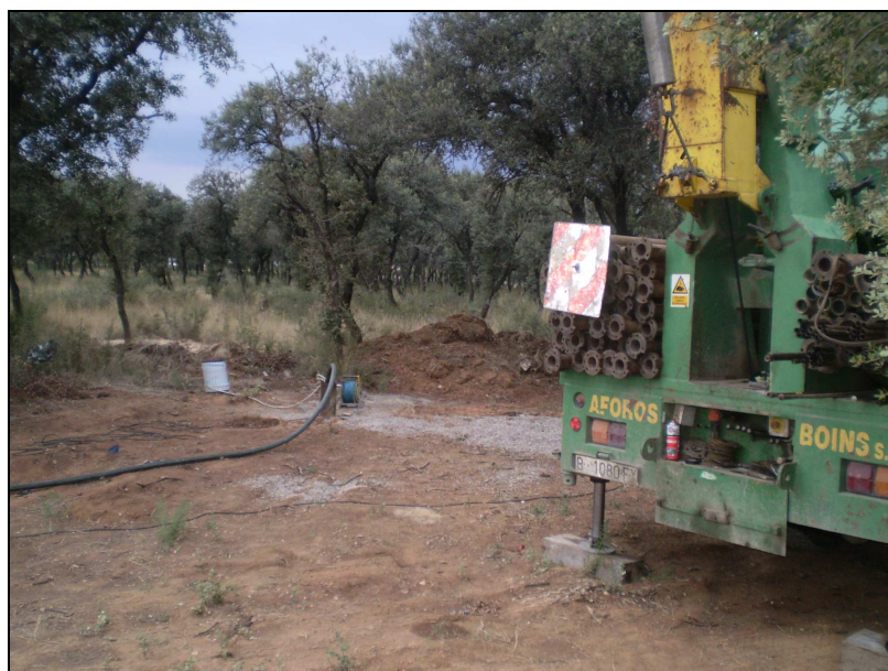
Imagen 2. Situación del piezómetro y bomba.
