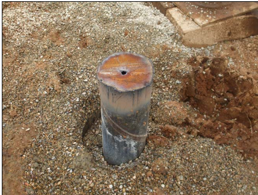
Imagen 9. Colocación de la tapa superior.
