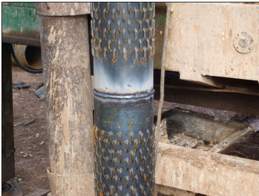
Imagen 4. Detalle de la soldadura realizada en el sondeo.
