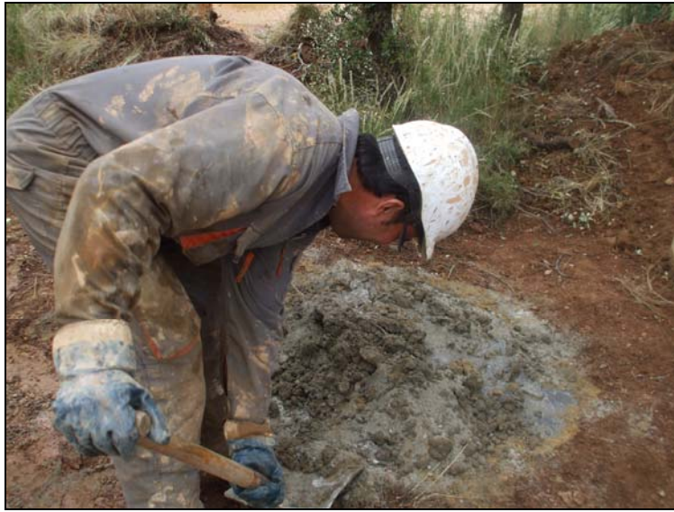
Imagen 8. Reparación de la masa para el cementado del sondeo.
