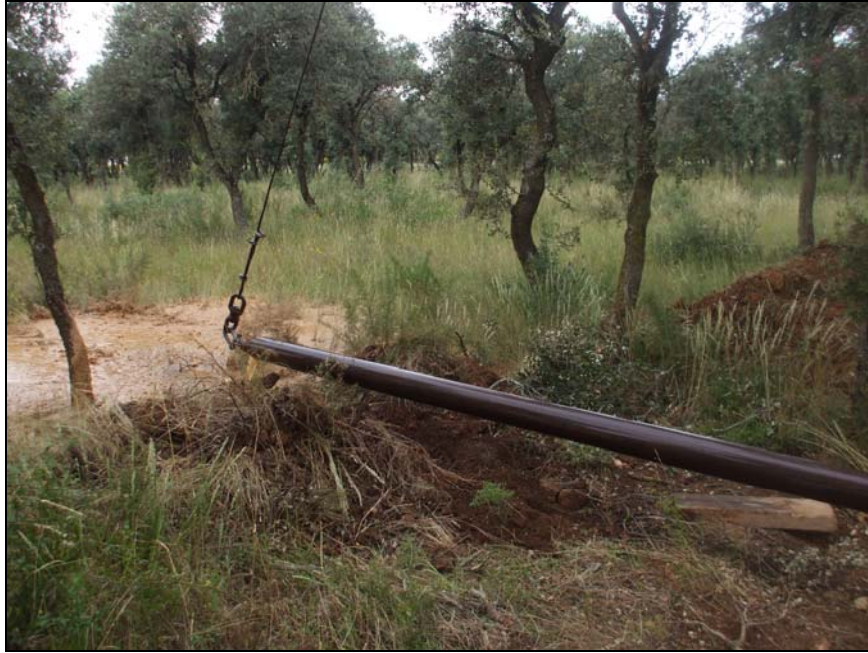
Imagen 6. Realización de limpieza mediante valvuleo.
