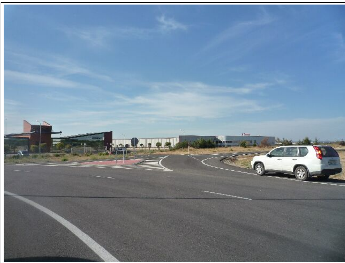
Desvio en la carretera (13/12/2010)
