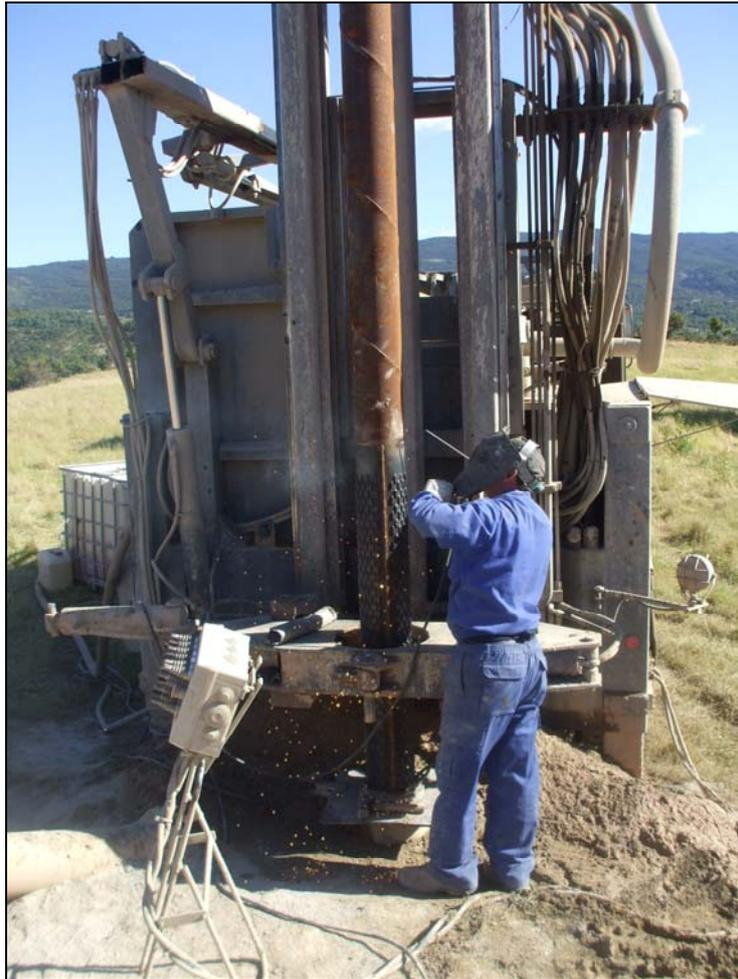
**Imagen 8.** Trabajos de soldadura durante la entubación.
