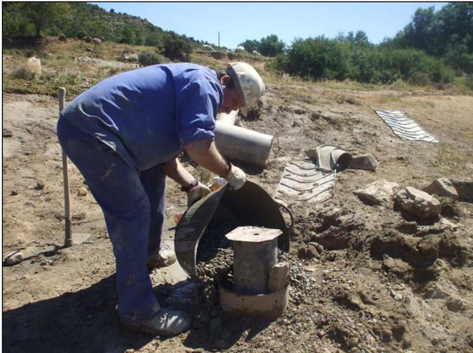
*Imagen 12. Cementación del emboquille del sondeo.*
