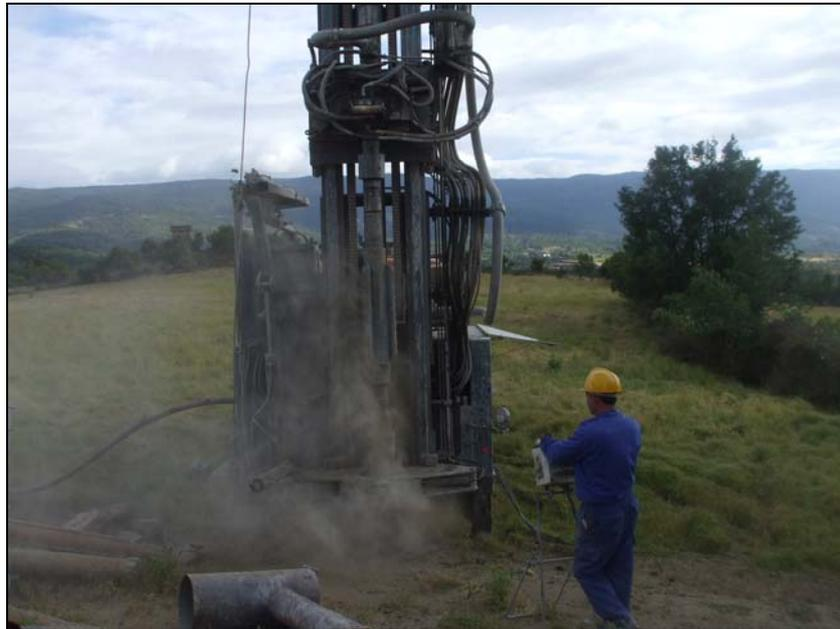
**Imagen 2.** Perforación del emboquille.
