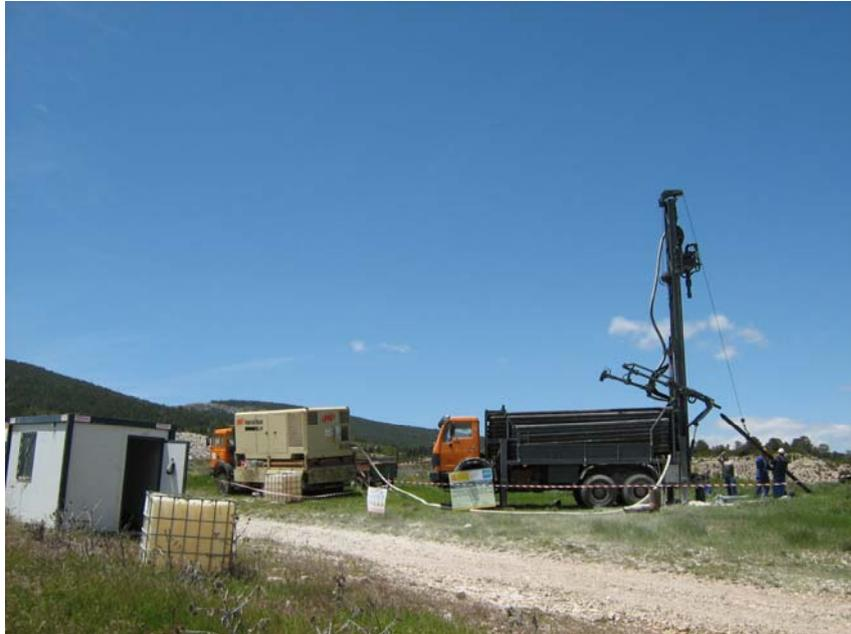
Vista del emplazamiento mientras se eleva el varillaje con el cablestante
