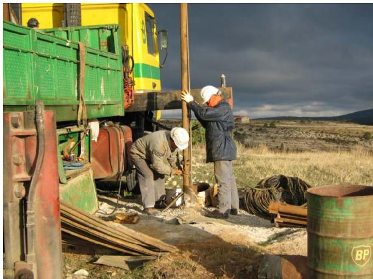
**Introduciendo la tubería de impulsión**
