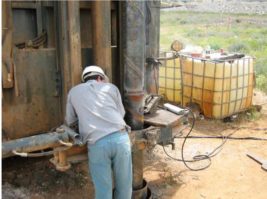
**Soldando dos tramos de tubería ciega**
