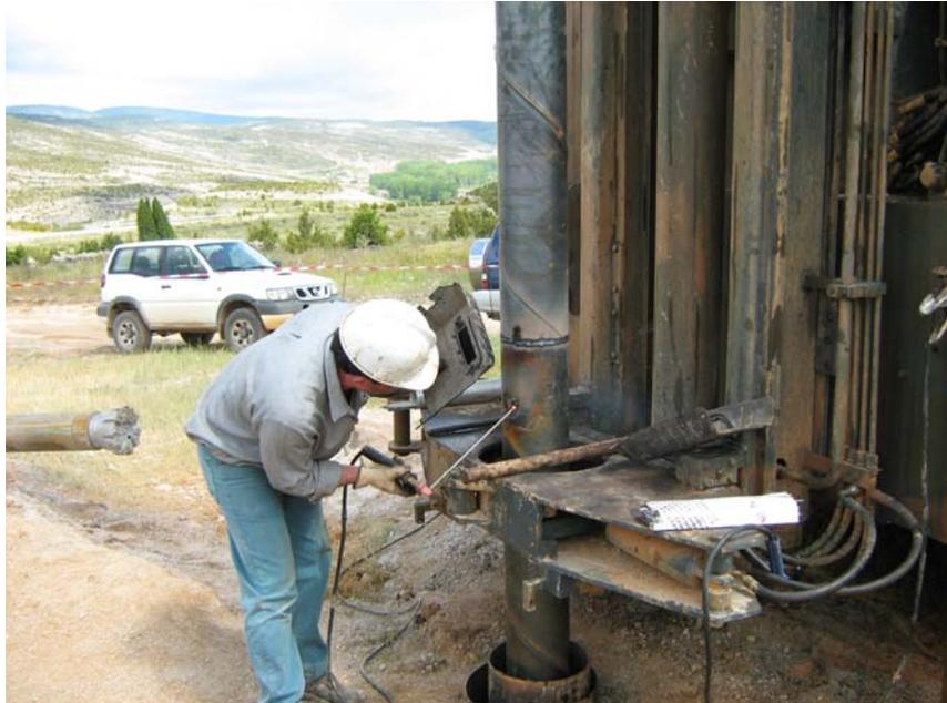
**Soldando dos tramos de tubería ciega**
