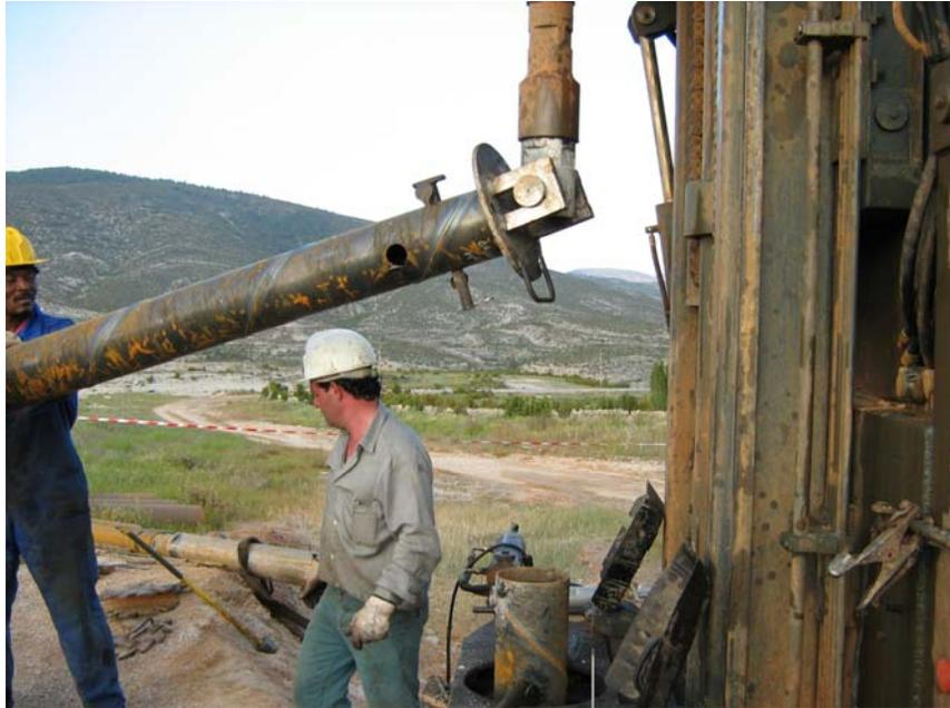
**Elevando un tramo de tubería ciega**
