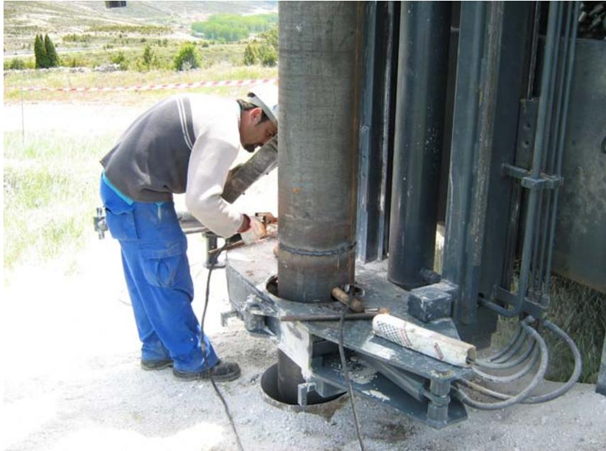
**Soldando la tubería de emboquille**
