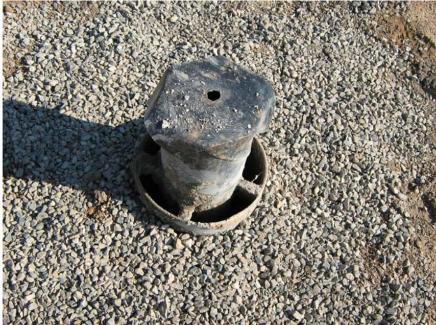
**Sondeo tapado provisionalmente con chapa metálica**
