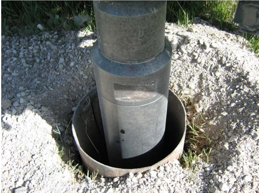
Martillo de 324 mm y tubería de emboquille
