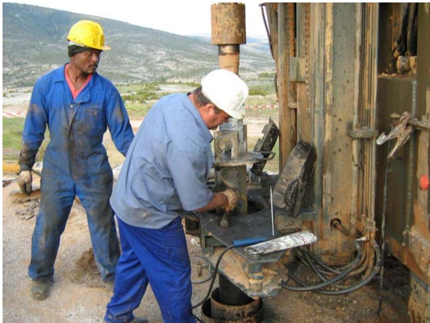
**Asegurando la tubería antes de ser soldada al siguiente tramo**
