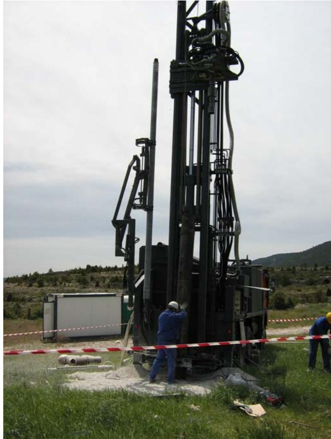
**Colocando la tubería de 300 mm para ser introducida**
