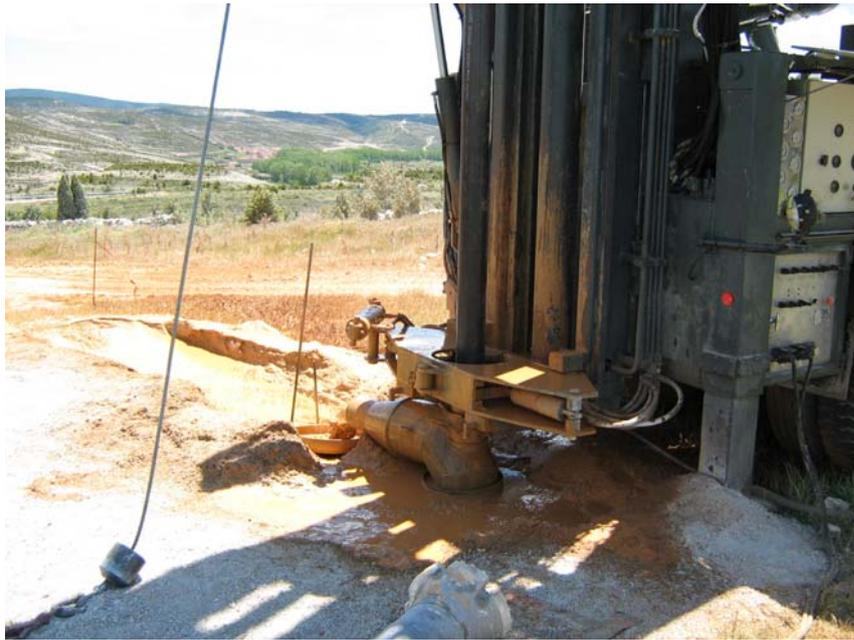
**Perforando en 220 mm de diámetro a 235 m de profundidad**
