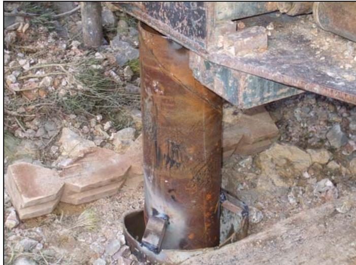
**Imagen 10. Detalle de la suspensión de la columna de entubación.**
