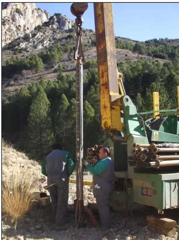
*Imagen 2. Instalación del equipo de bombeo.*
