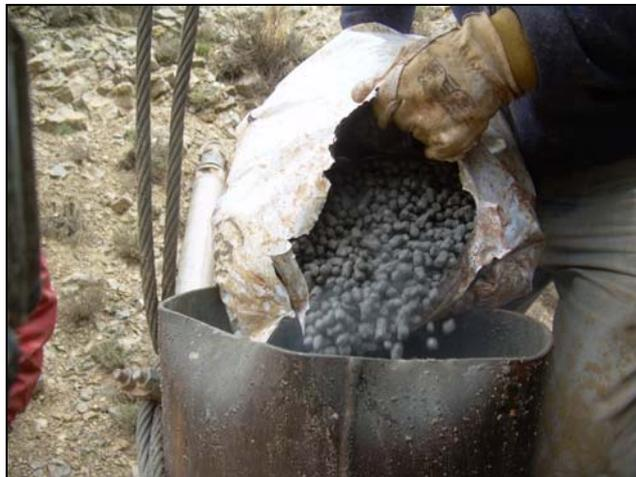
**Imagen 3. Introducción de mikolit en el interior del sondeo.**
