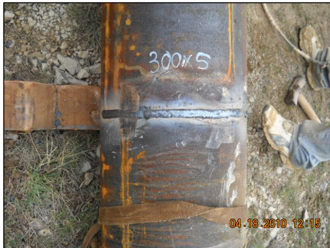
Fig.5. Detalle de la soldadura de los tubos del emboquille.
