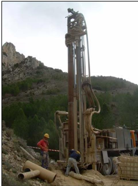
**Imagen 2. Colocación de la tubería de emboquille.**
