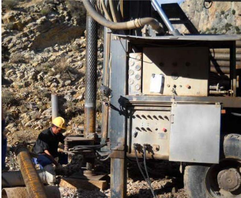
Fig.11. Bajada de la tubería de filtro puentecillo, soldada a un tramo ciego y centrada mediante cuñas.
