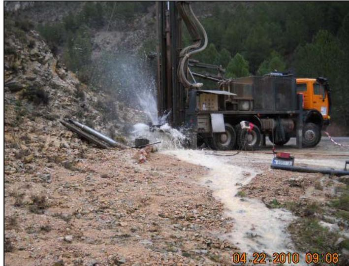
Fig.13. Trabajos de limpieza del sondeo de Aliaga.
