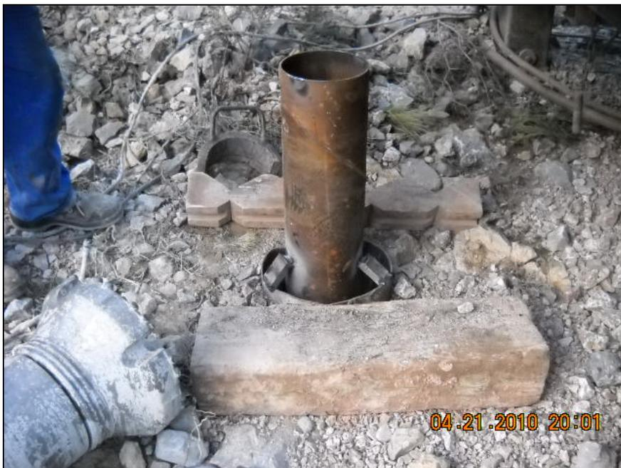
Fig.12. Dispositivo de centrado de la tubería.
