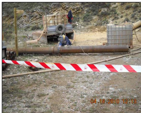
Fig.4. Realización de los trabajos de soldadura del emboquille.
