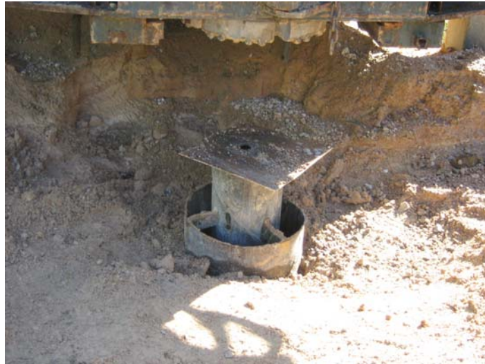
Sondeo con tapa de chapa metálica y agujero para posibles medidas antes de instalar el dado y la arqueta.
