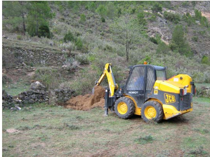
Retroexcavadora haciendo la balsa
