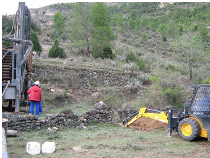
Retro excavando la balsa y preparando para comenzar a perforar el emboquille
