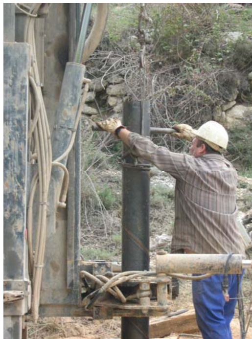
Introduciendo un tramo de tubería ciega
