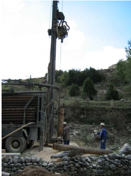
Entubando el emboquille
