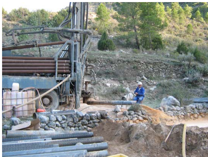
Perforando a 120 m de profundidad
