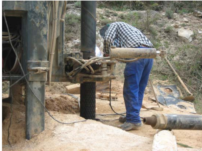
Soldando dos tramos de tubería
