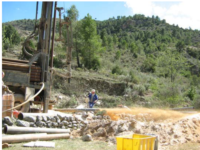
Perforando a 85 m de profundidad
