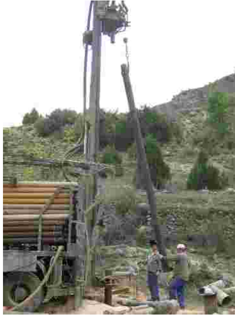
Elevando un tramo de tubería de filtro
