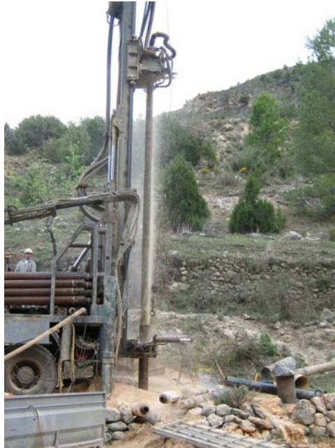
Limpiando la obstrucción de los 66 m
