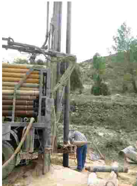
Soldando dos tramos de tubería
