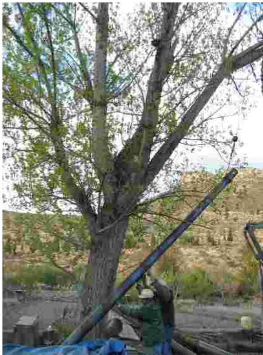
Elevando un tramo de tubería ciega de 6 m
