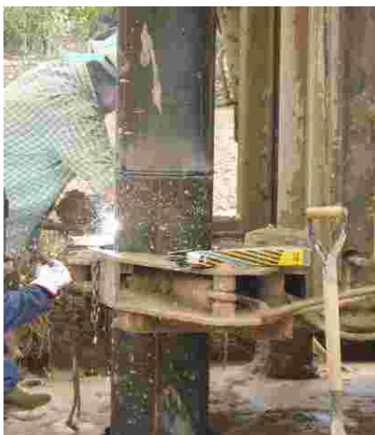
Soldando las tuberías de 300 mm de diámetro
