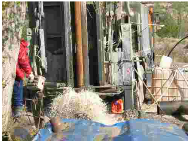
Perforando a 170 m de profundidad
