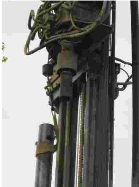
Detalle tubería elevada con cablestante
