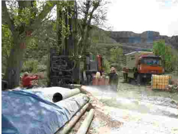
Perforando a 85 m de profundidad
