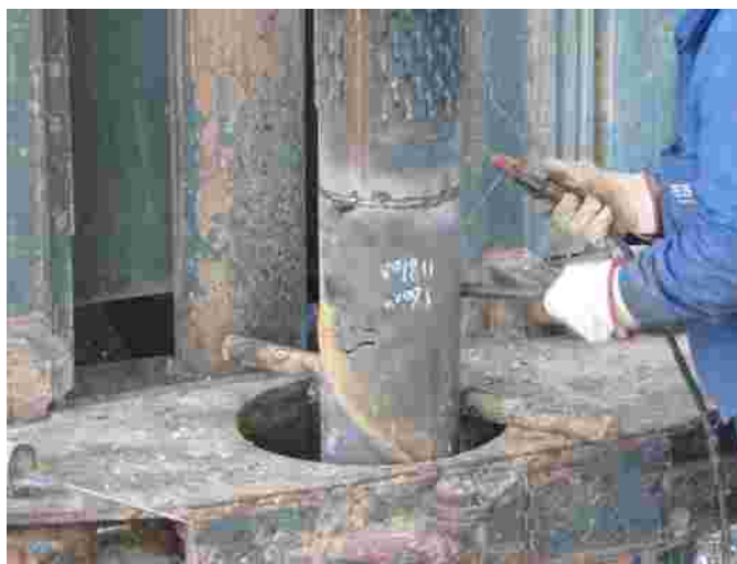
Soldando dos tramos de tubería
