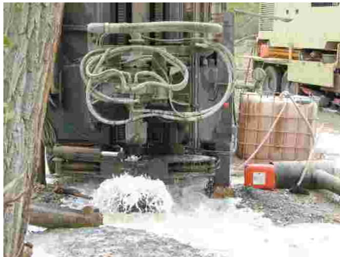
Perforando a 230 m de profundidad
