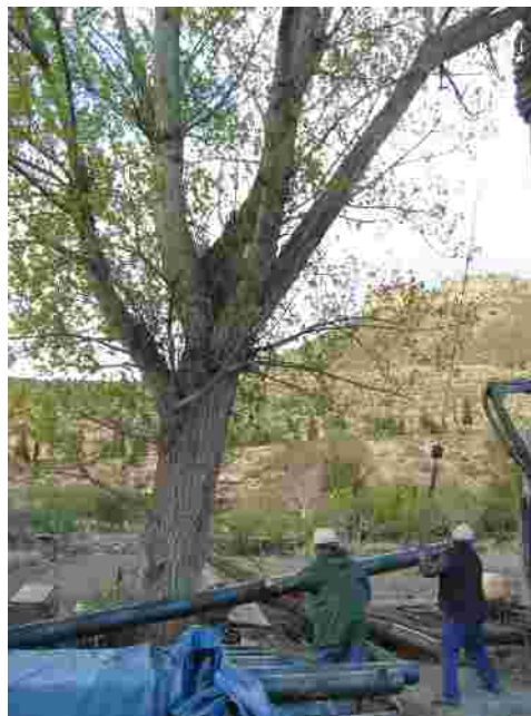
Elevando un tramo de tubería ciega
