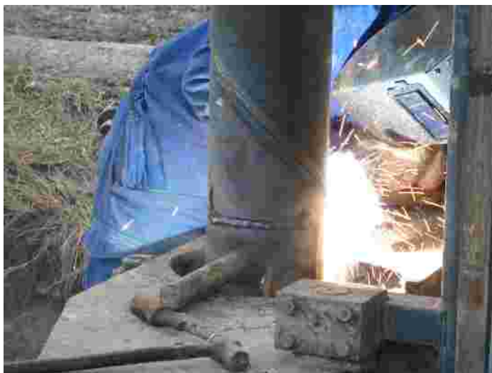
Soldando dos tramos de tubería ciega
