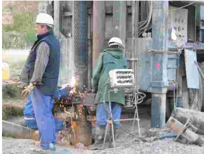
Soldando dos tramos de tubería de 180 mm de diámetro
