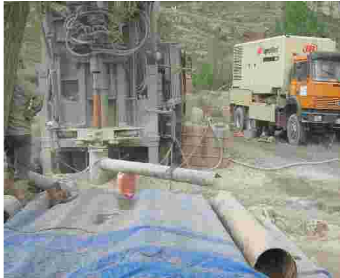
Perforando con el martillo de 220 mm de diámetro
