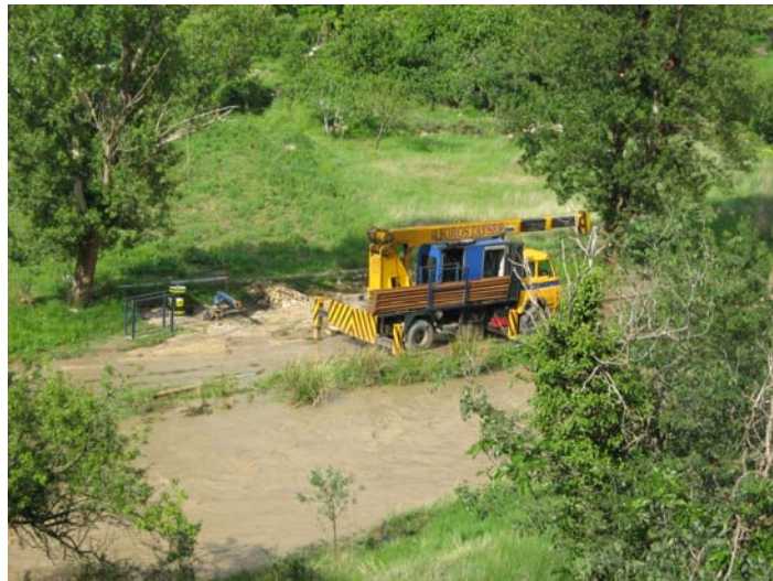
Emplazamiento tras el desbordamiento
