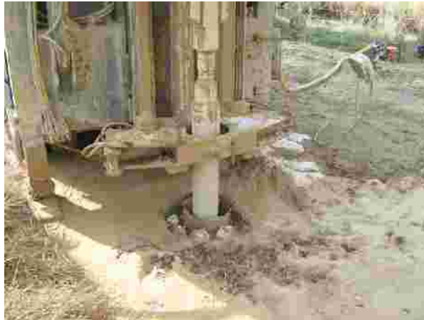
Perforando el emboquille
