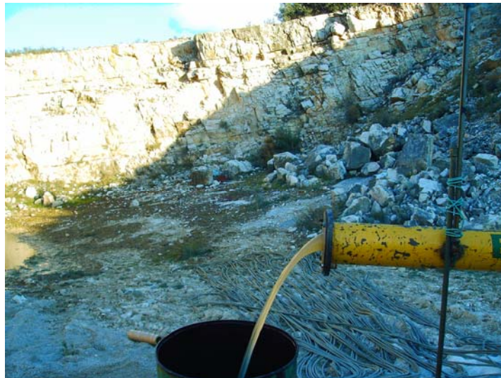
Cuarto escalón, 3 l/s de nuevo. Agua turbia.
