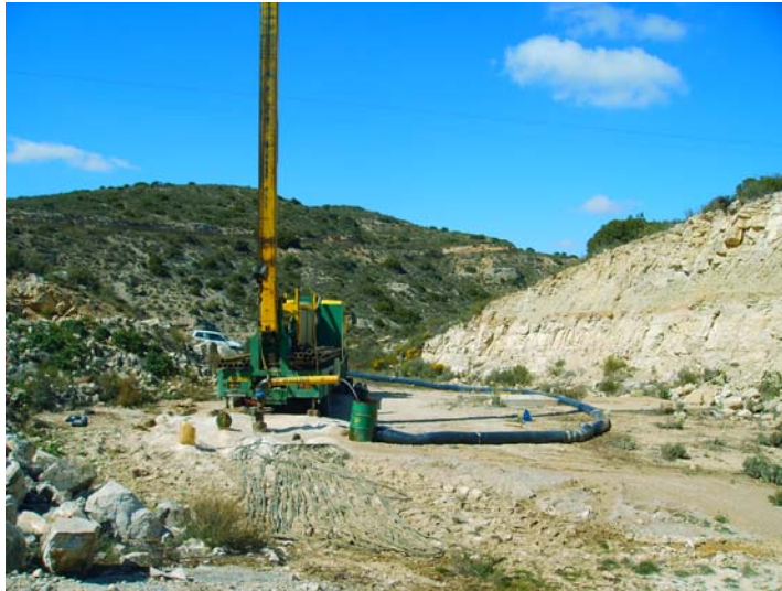
Maquina aforando y manguera flexible evacuando el agua hasta el barranco
