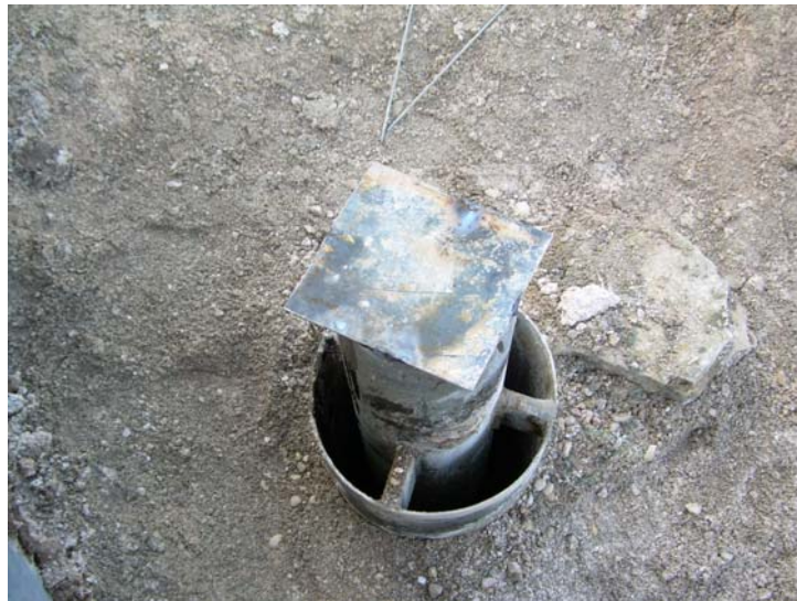
Chapa metálica cerrando el sondeo
