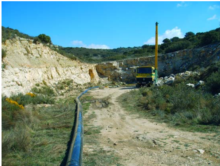
Manguera flexible evacuando el agua
