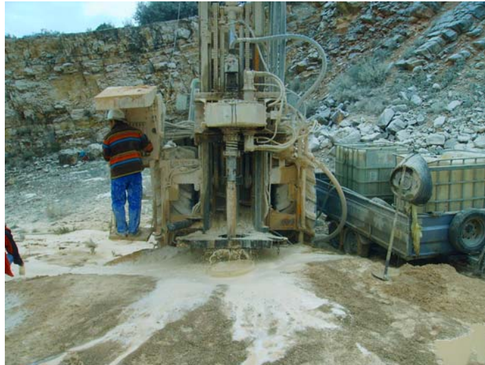
Perforación a partir de 123 m con agua y espumante
