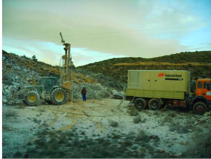
Equipo de perforación
