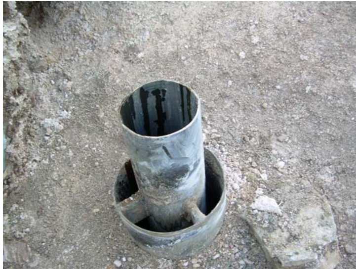
Sujeción de la tubería de 180 mm a la de 300 mm
