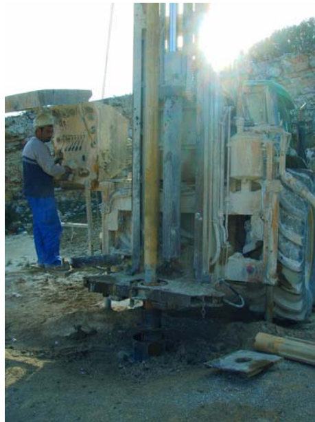
Introducción de la maniobra y martillo de 165 mm de diámetro
