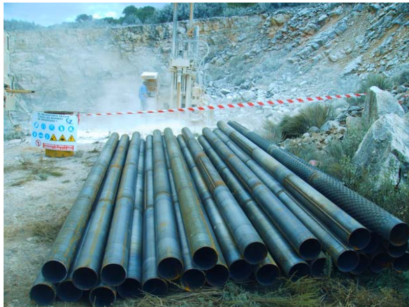
Tubería definitiva con soldadura vertical
