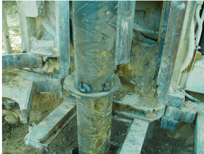
Tope a los 6 m para evitar la pérdida de la cementación
