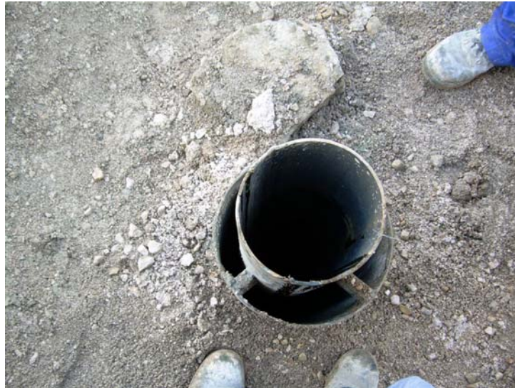
Final de la entubación, unión de la tubería de 180 mm a la de 300 mm
