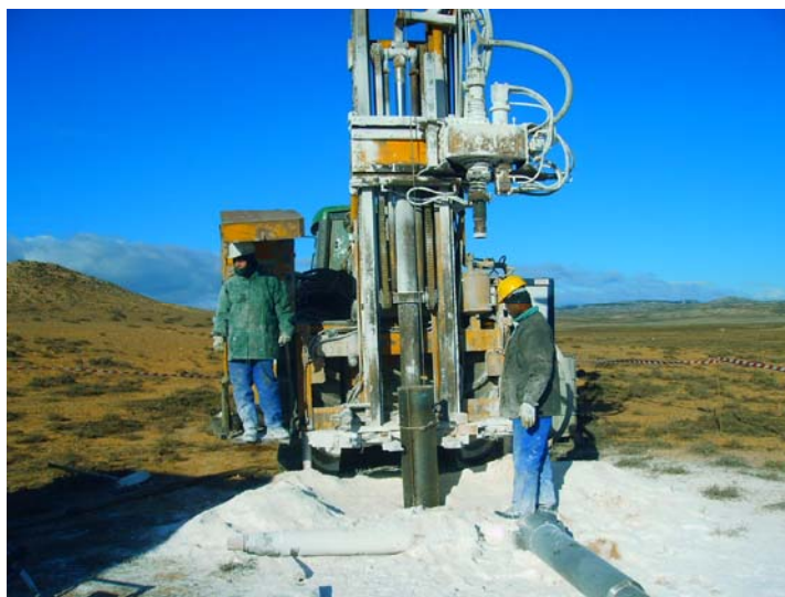
Introduciendo la tubería de “emboquille”
