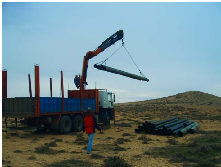
Acopio de tubería
