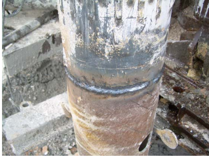
Detalle orejetas y soldadura entre tuberías
