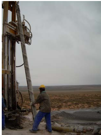
Elevando la tubería
