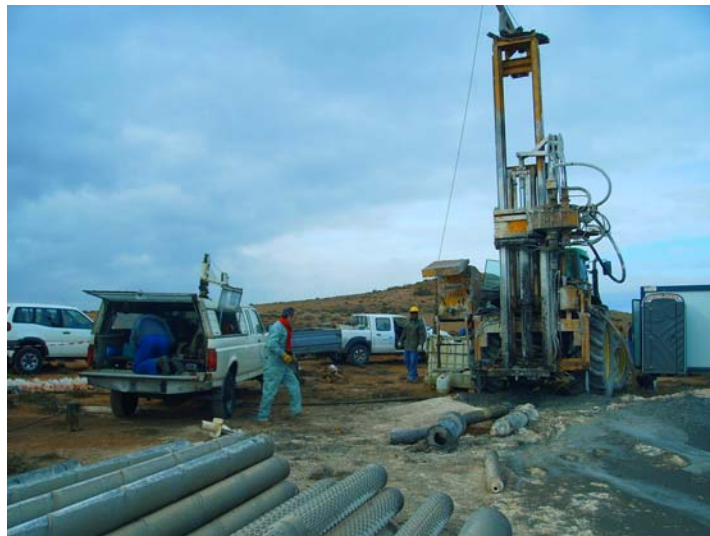
Preparando para la testificación geofísica
