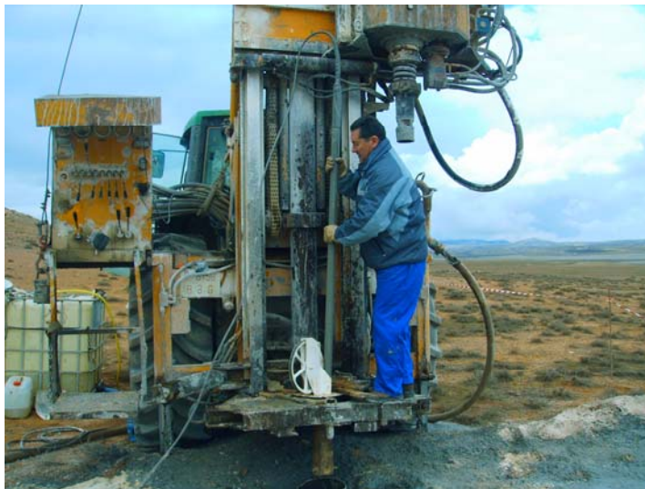
Introduciendo la sonda hidrogeológica
