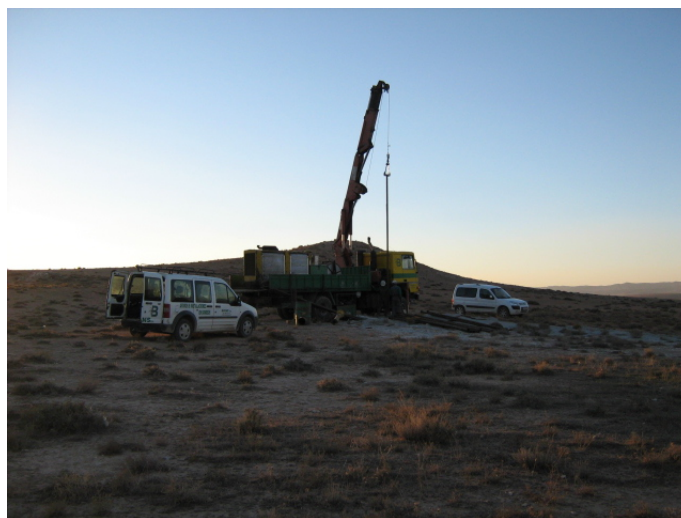
Vista del emplazamiento durante la introducción de la tubería
