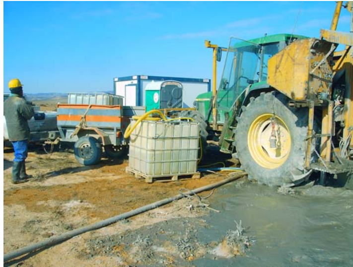
Cuba de agua inyectada para la limpieza
