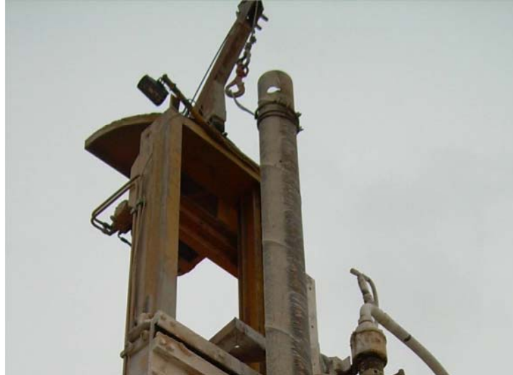
Gancho y cable tras elevar la tubería
