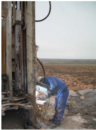
Soldando las tuberías
