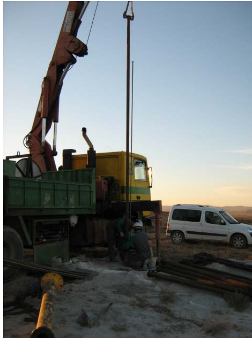
Introduciendo tuberías y cableado
