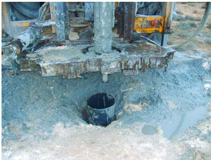
Tubería de emboquille tras extraer la maniobra.
