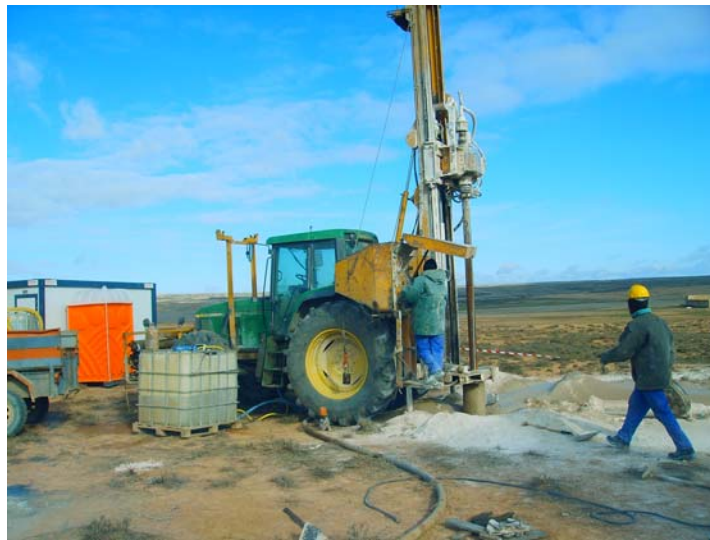
Perforando con el martillo de 220 mm
