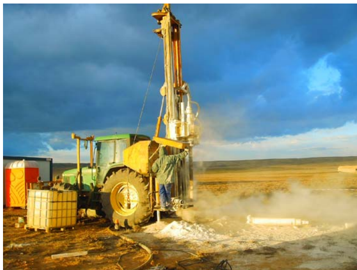
Perforando con el martillo de 220 mm
