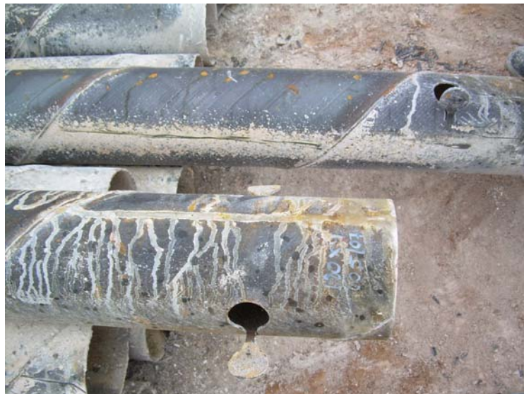
Detalle orejetas abiertas de la tubería ciega
