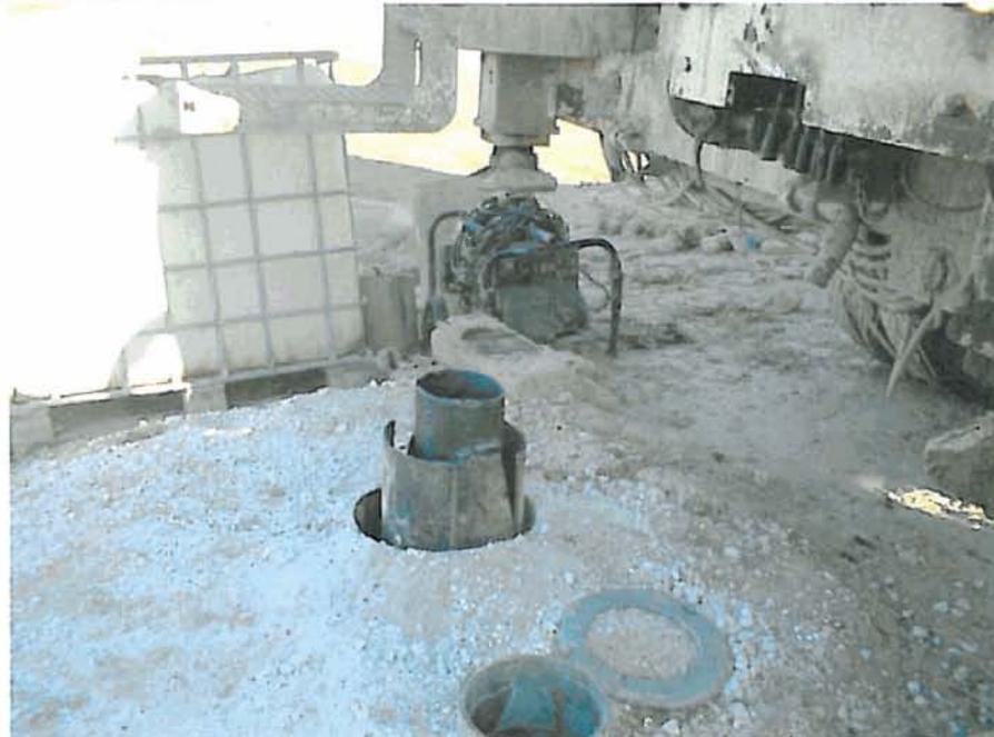
Preparación del solape final entre las tuberías de 180 y 300 mm.
