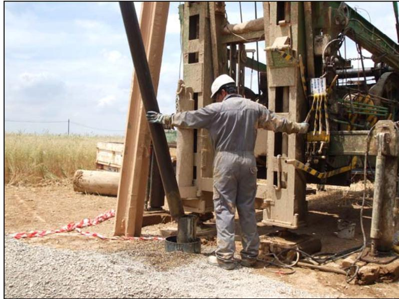
**Imagen 8.** Realización de limpieza mediante valvuleo.
