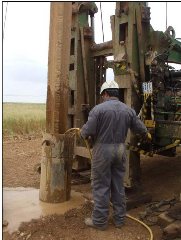
*Imagen 3. Primeros metros de perforación del sondeo.*
