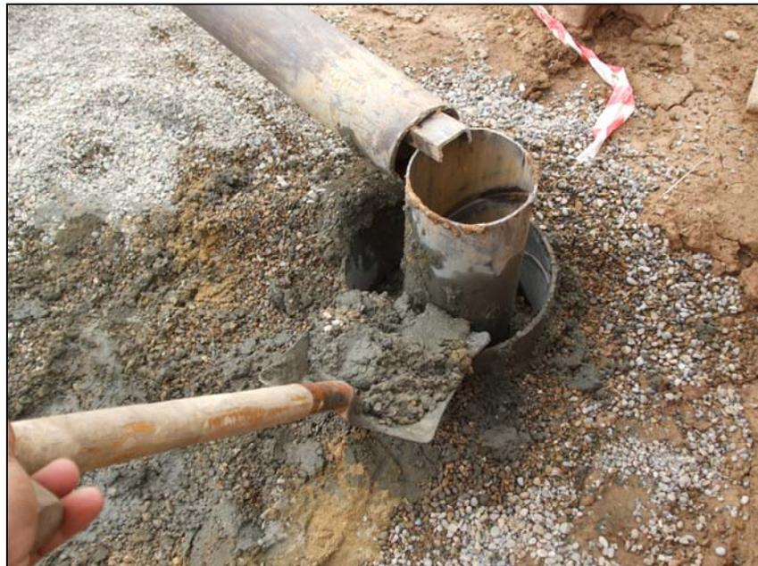
**Imagen 9.** Cementación del emboquille del sondeo.
