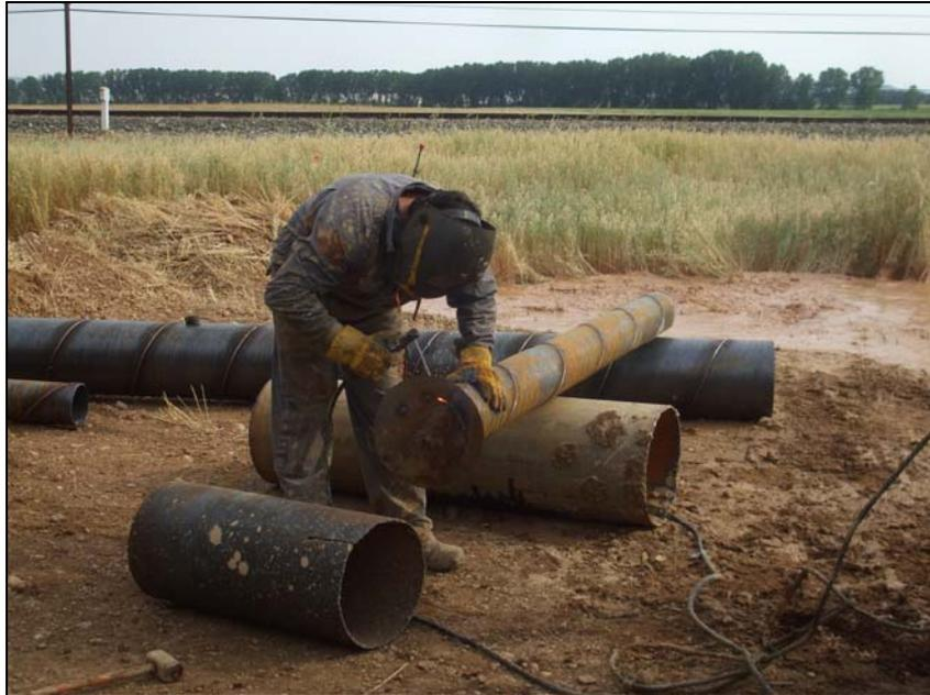
**Imagen 5.** Colocación de la tapa de fondo.
