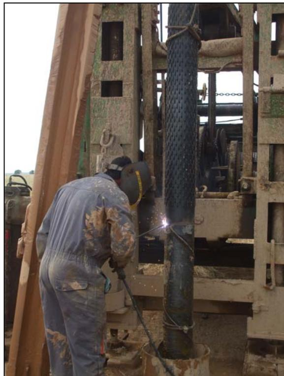
**Imagen 6.** Trabajos de soldadura durante la entubación del sondeo.
