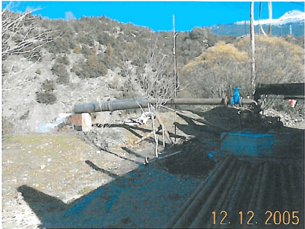
Primeras horas del ensayo de bombeo
