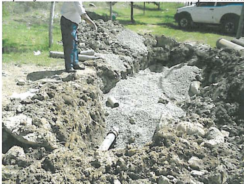
Detalle de la tubería reparada y de la grava vertida a su alrededor.
