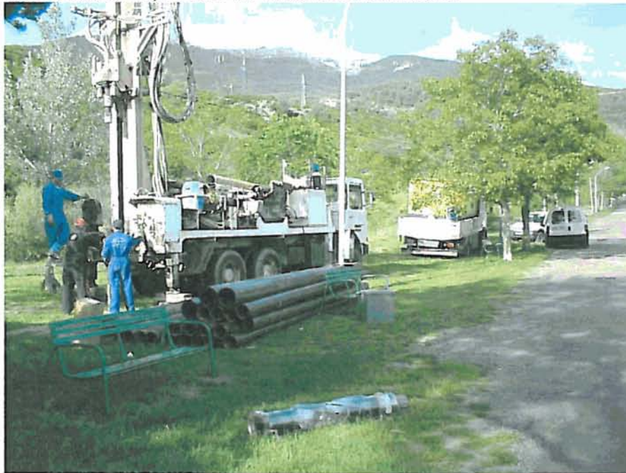
Sonda ubicada en emplazamiento previsto.
