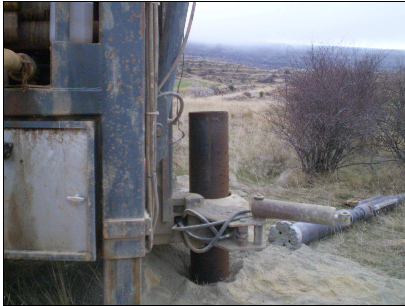
Imagen 3. Emboquille del sondeo.
