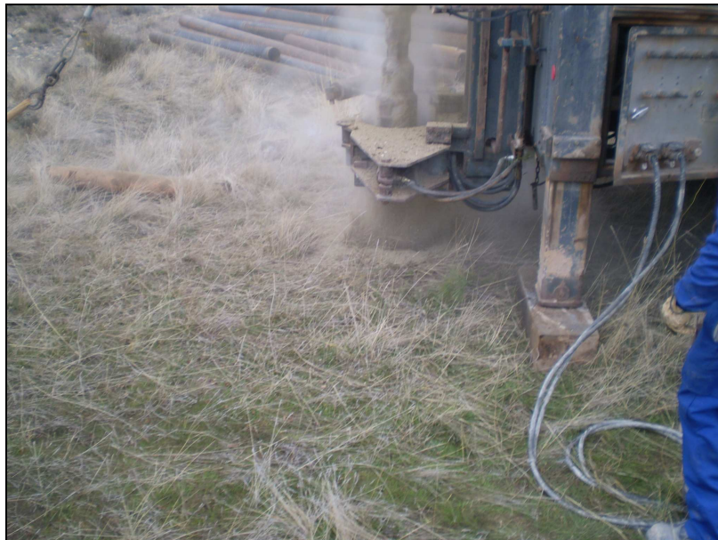
Imagen 2. Inicio de la perforación.
