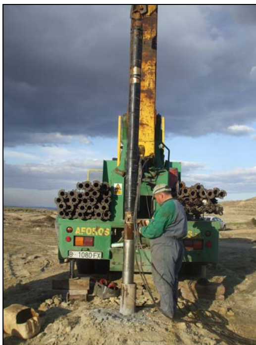
Imagen 1. Instalación del equipo de bombeo.
