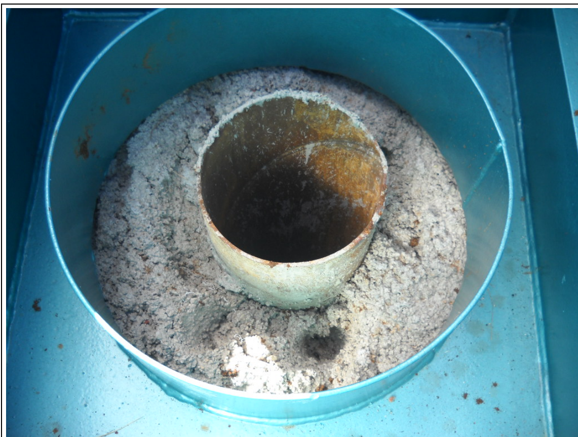
detalle boca del sondeo (11/05/2012)
