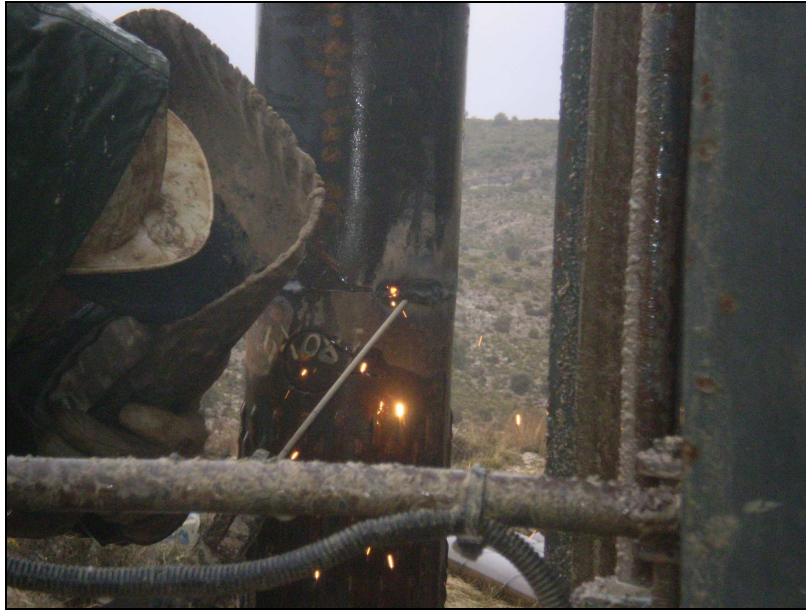
Imágenes 8 . Trabajos de entubación del sondeo (soldadura).
