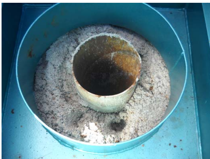
05/2012 detalle boca del sondeo
