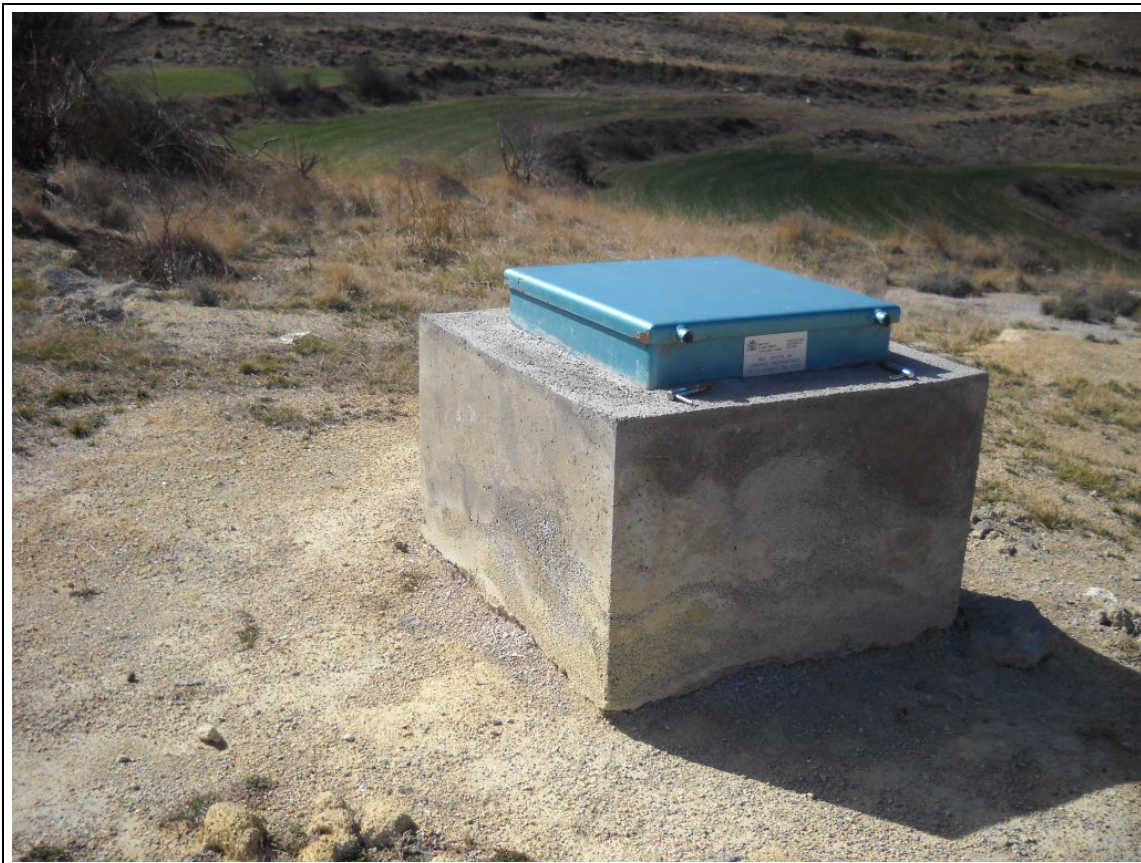
Detalle dado y arqueta (11/05/2012)
