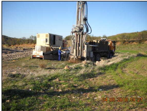
Fig.3. Labores de perforación del emboquille
