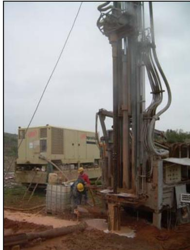
Durante la perforación los materiales atravesados han sido básicamente arenas, arcillas y gravas.
