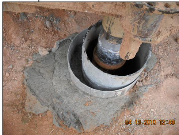
Fig.6. Aspecto provisional de cómo queda el emboquille del sondeo
