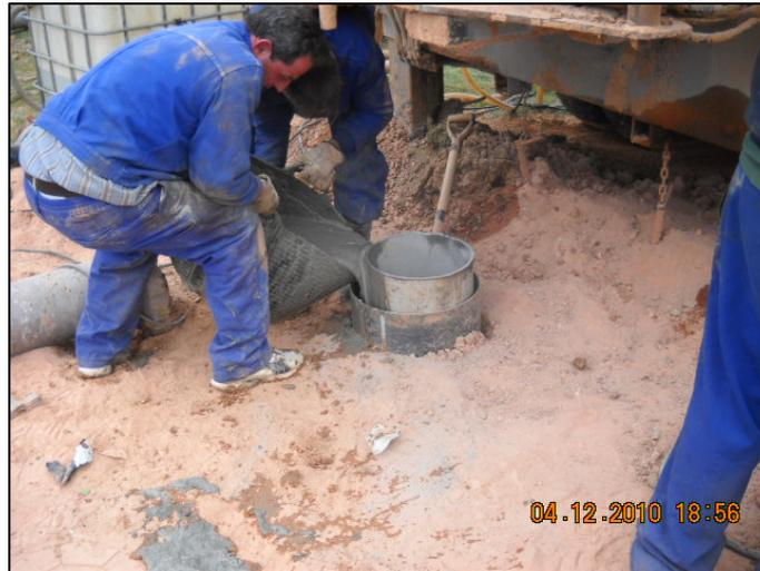
Fig.5. Labores de cementación del emboquille
