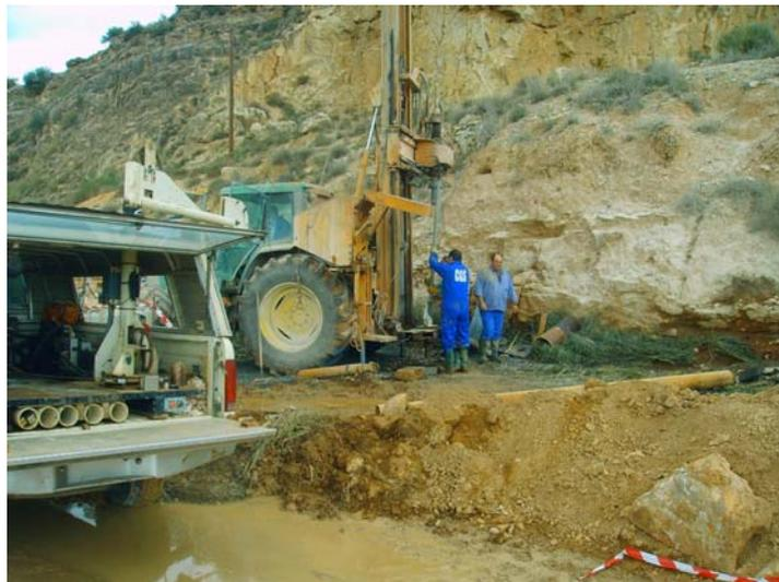
**Introducción de la sonda hidrogeológica**
