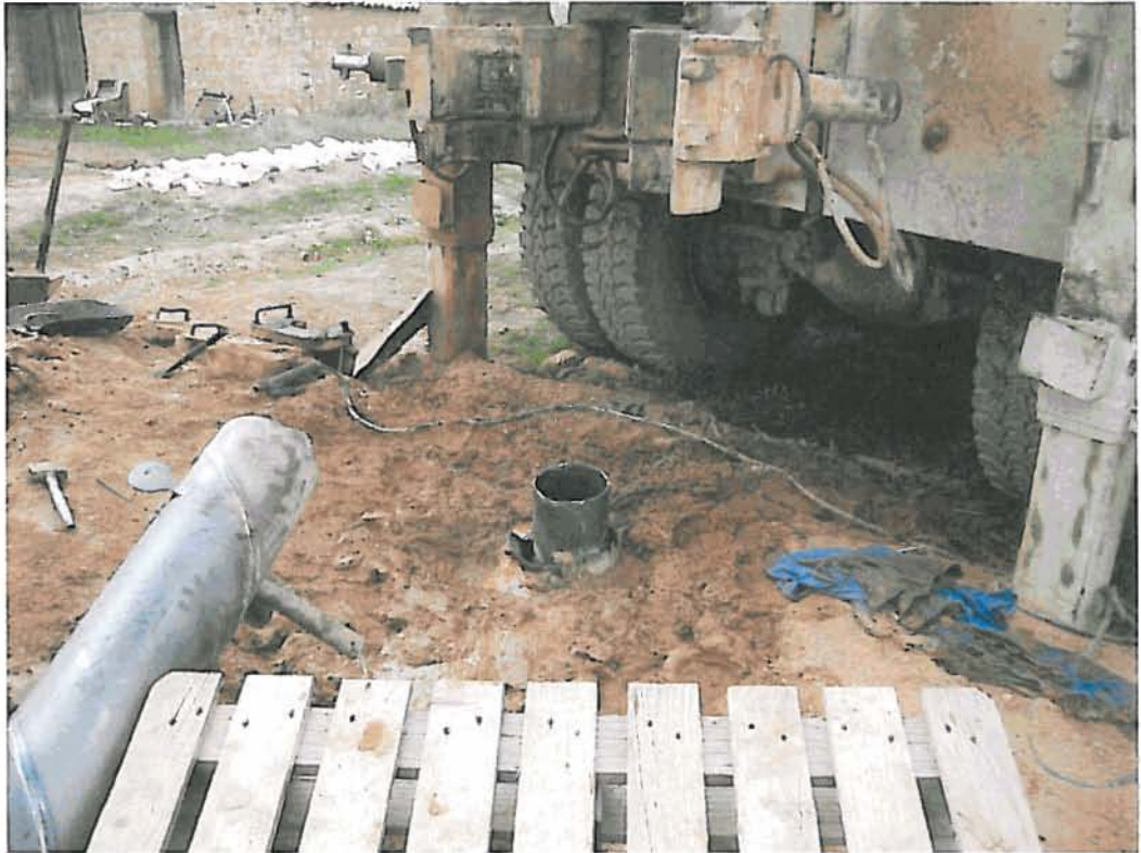
Detalle de tubería colgada mediante soldadura a la tubería de 250 mm.
