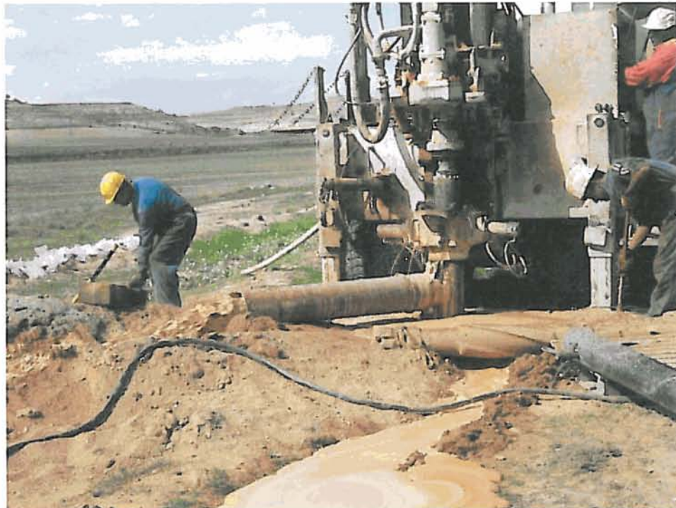
Proceso de limpieza de la perforación y entubación de los últimos metros.
