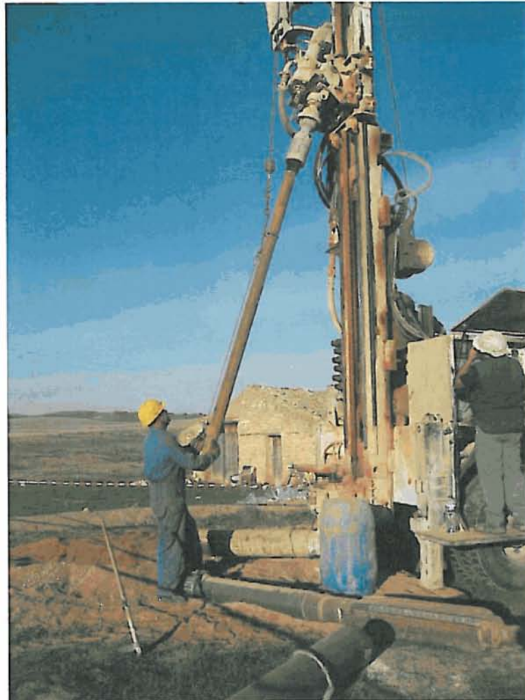
Colocación de varilla de perforación de 3 metros de longitud. Obsérvese el ripio rojizo procedente de las arcillas y areniscas atravesadas.
