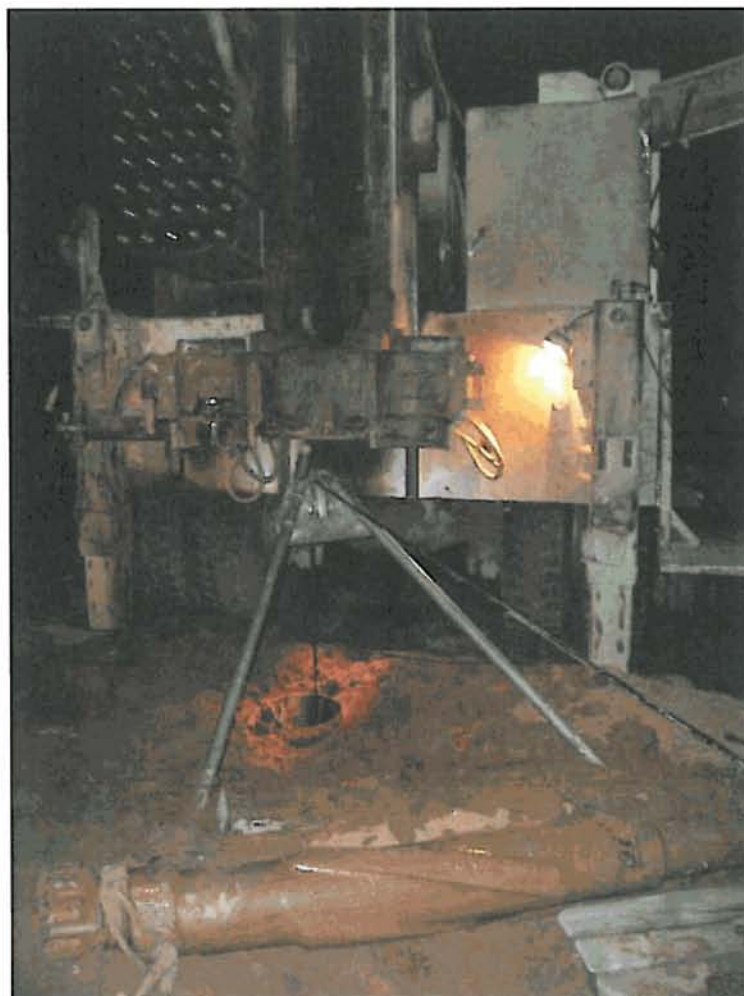
Sonda de testificación ya introducida en la perforación.
