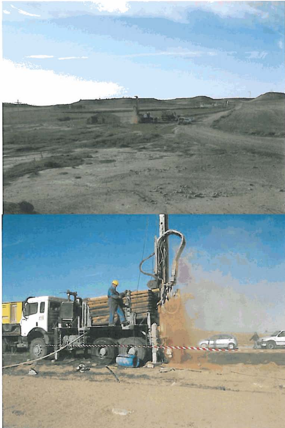
Entorno de la perforación y detalle de la misma.
