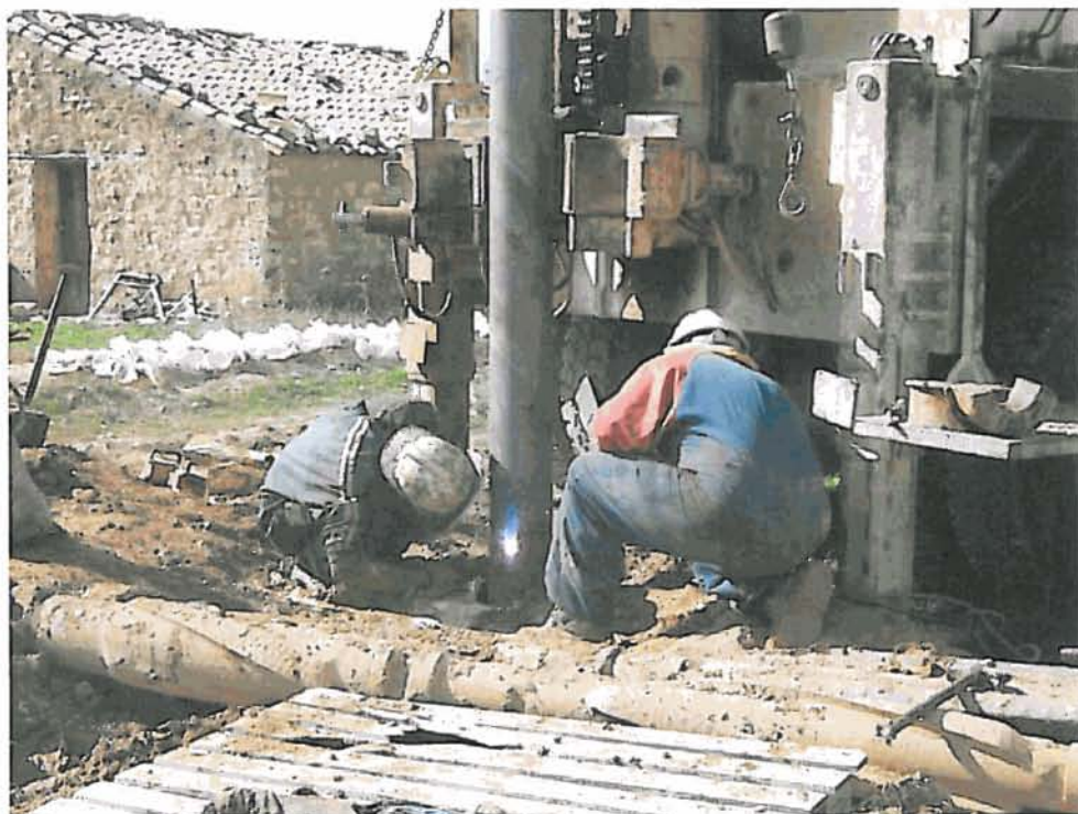
Proceso de limpieza de la perforación y entubación de los últimos metros.
