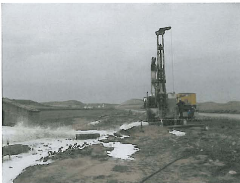
Detalle del caudal extraído en los últimos metros de perforación
