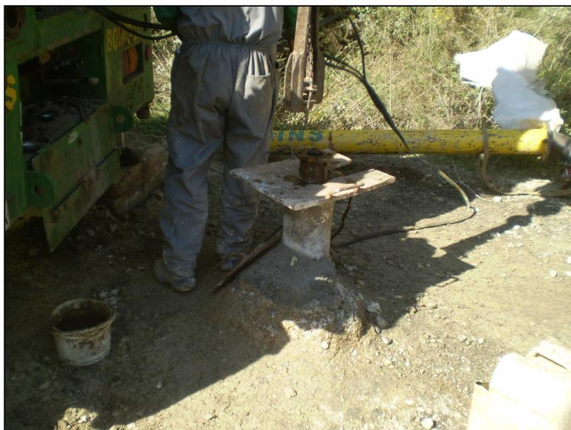
**Imagen 1.** Montaje de la bomba.
