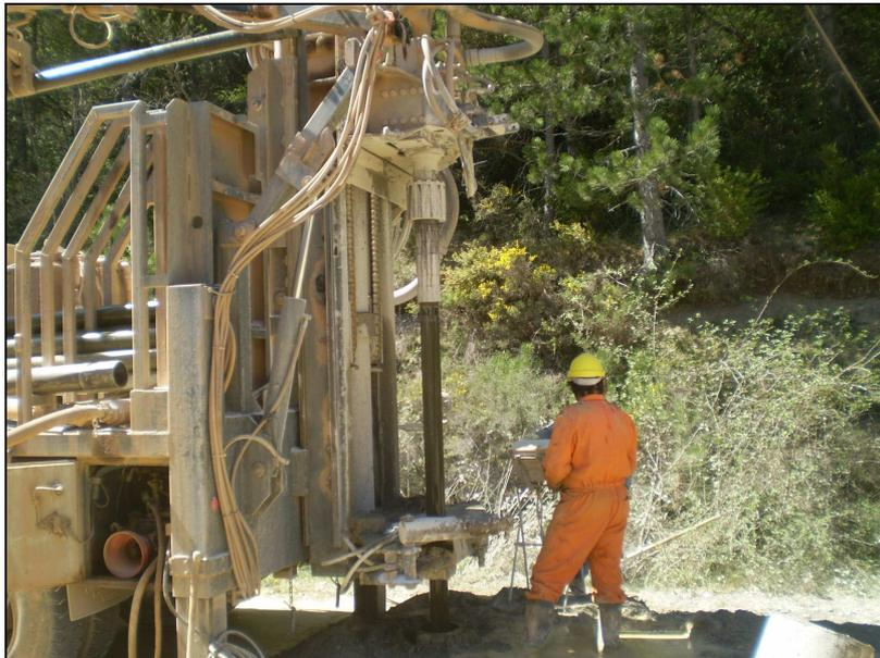
**Imagen 2.** Perforación del sondeo a 220 mm. de diámetro.
