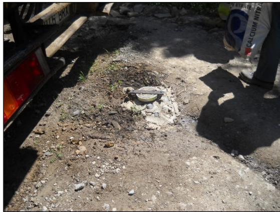
Fig. 15. Aspecto del dado del cierre del sondeo.
