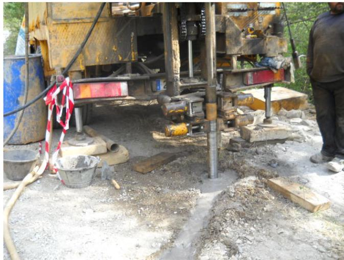
Fig.4. Detalle de la perforación y del procedimiento de evacuación del agua con los finos.
