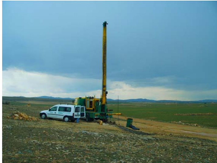
Maquinaria en el emplazamiento una vez comenzado el ensayo
