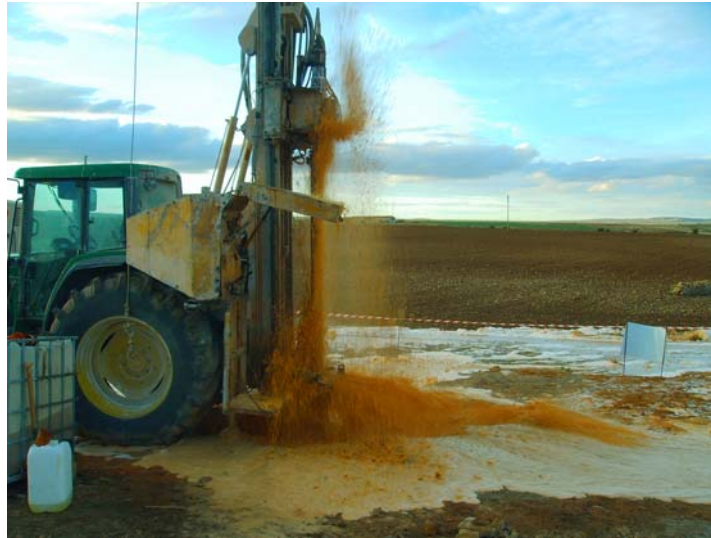
Sonda durante las maniobras de perforación
