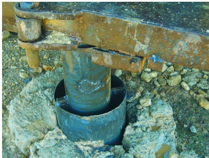
Unión de la tubería de 180 mm a la de emboquille
