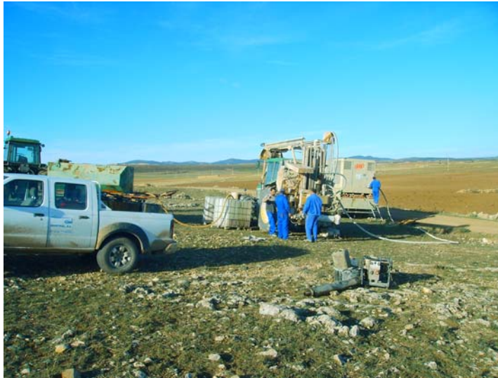
Emplazamiento del equipo de perforación
