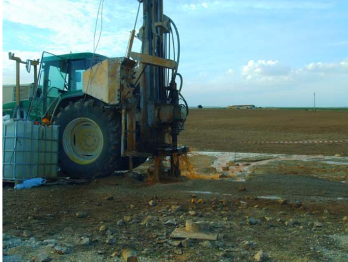
Limpieza del sondeo
