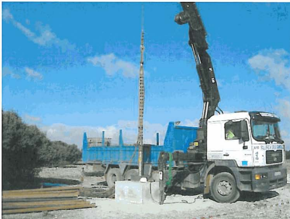
Instalación bomba (Torralba MMA)
