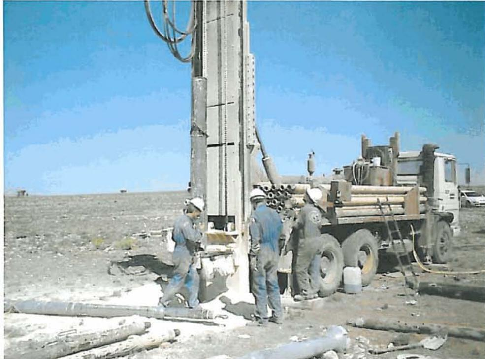
Colocación de la tubería de 300 milímetros para el emboquille.
