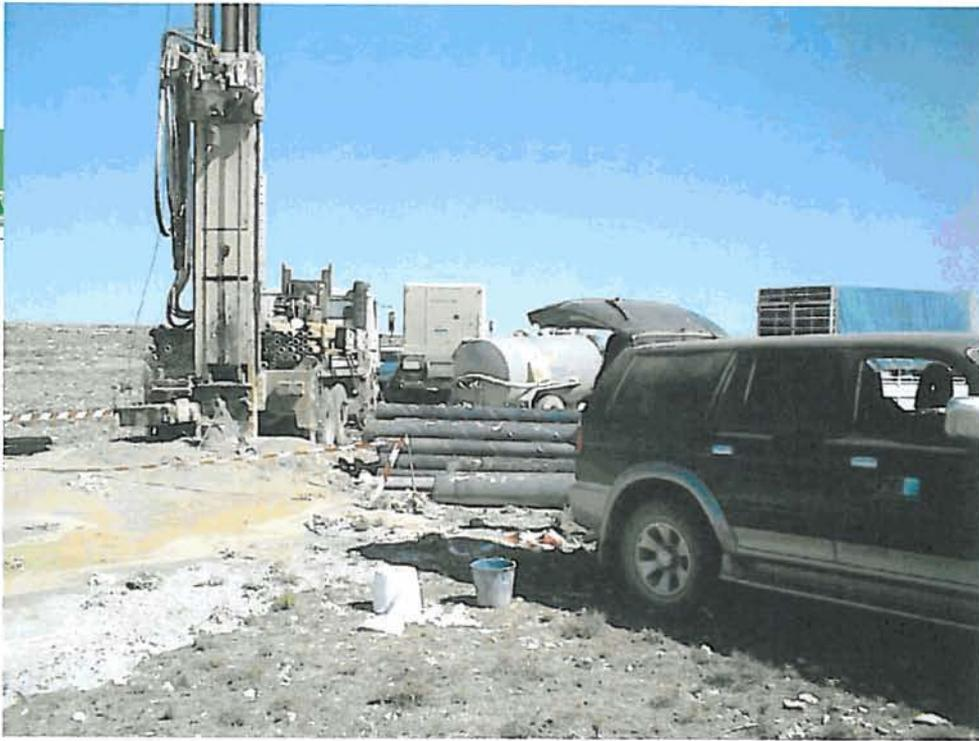
Testificación geofísica y colocación de los primeros tramos de tubería.
