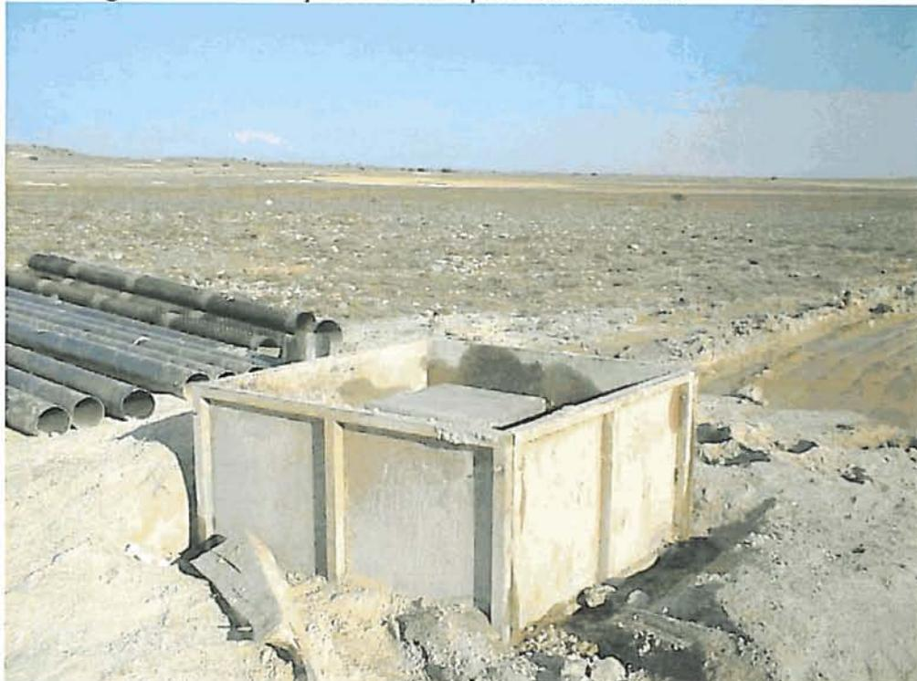
La foto se ha tomado a las 19:30, varias horas después del hormigonado. Se aprecian algunas grietas incipientes fruto de la intensa desecación por el calor. Aunque lo he regado por encima, creo que se notarán cuando se endurezca totalmente. Por este motivo, se deben tomar a partir del siguiente sondeo, las precauciones que tomábamos el verano pasado (riego a las pocas horas del hormigonado, cubrición con un plástico que evite la evaporación intensa de las primeras horas.
