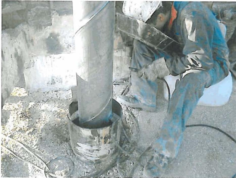
Soldadura de la tubería de 180 a la de 300 mm
