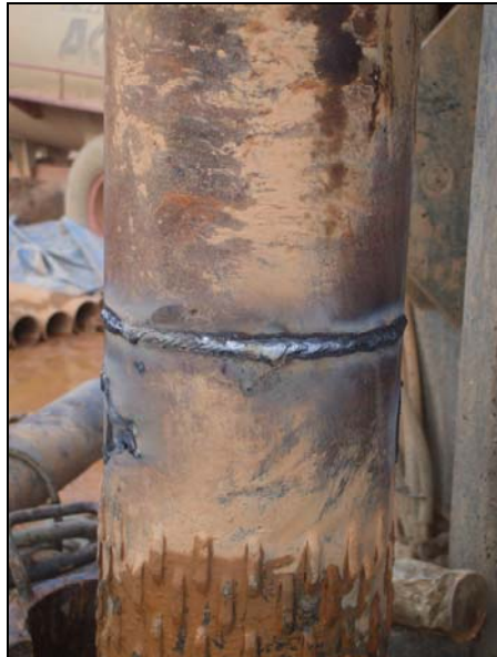
Imagen 9. Soldadura durante la entubación del sondeo.
