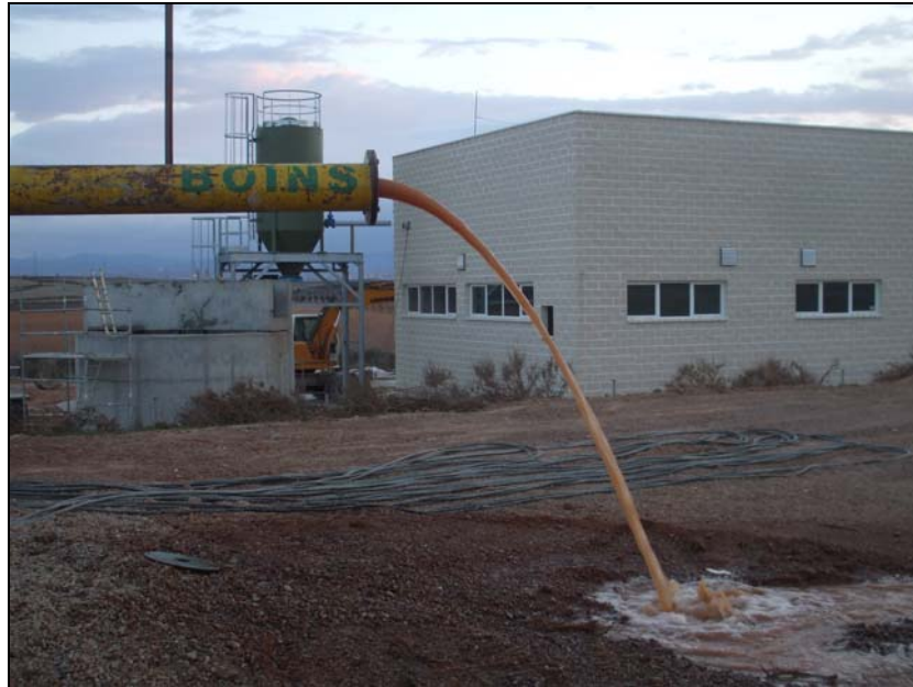
Imagen 6. Caudal extraído durante el tercer escalón.
