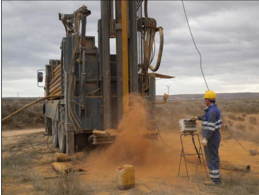
Imagen 2. Perforación del emboquille.
