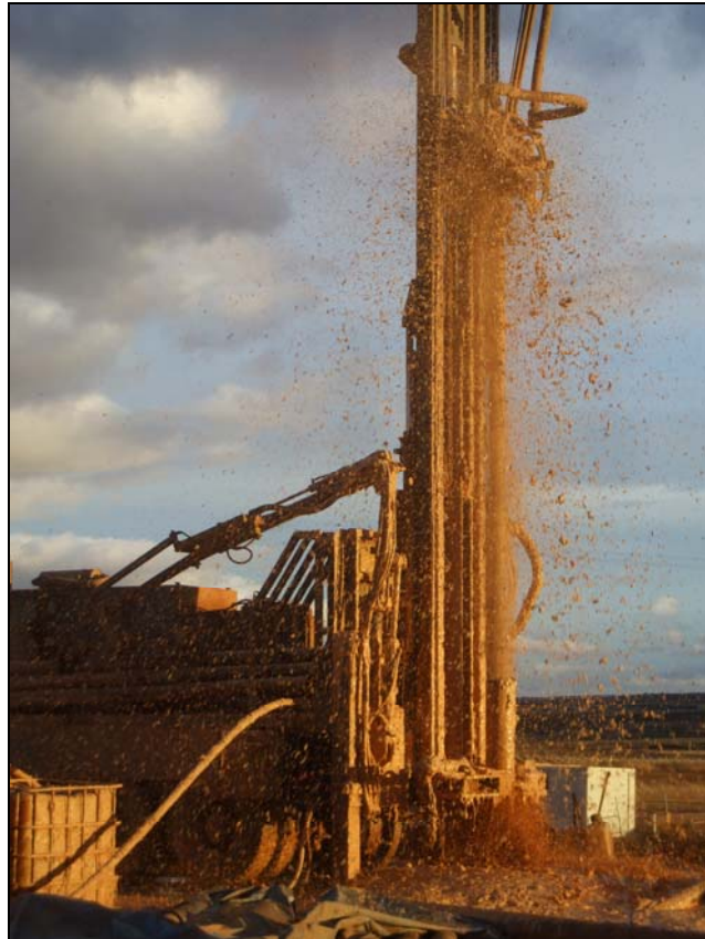
Imagen 6. Perforación del sondeo.
