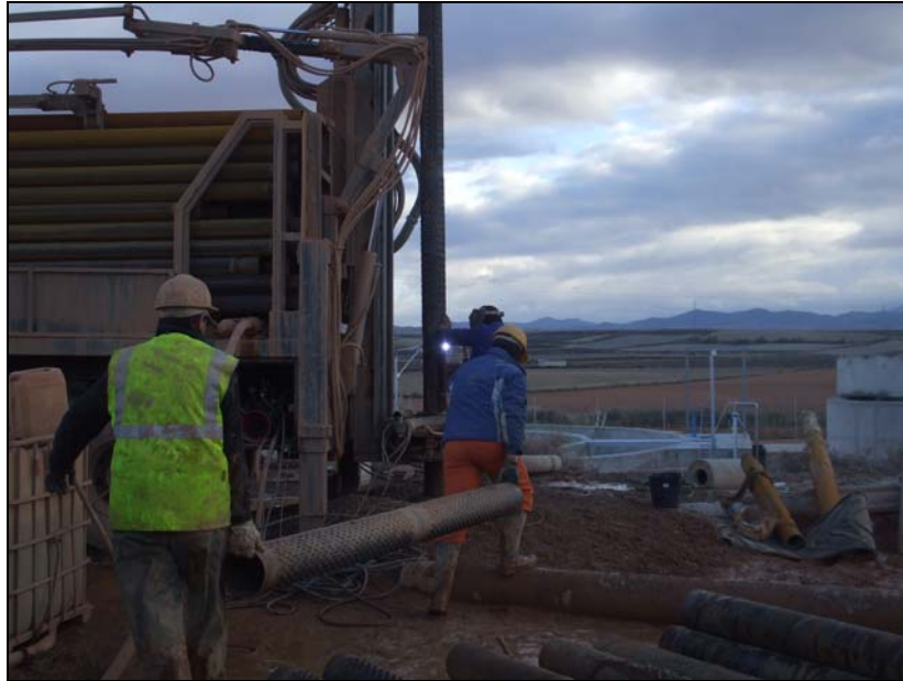
Imagen 8. Labores de entubación del sondeo.
