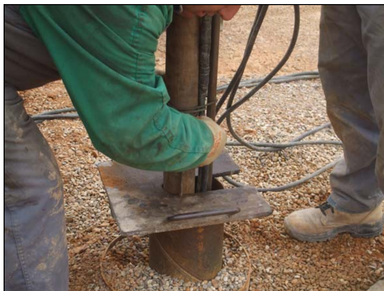
Imagen 2. Instalación del equipo de bombeo.
