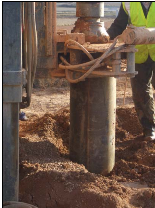
Imagen 4. Colocación de tubo auxiliar de 380 mm.
