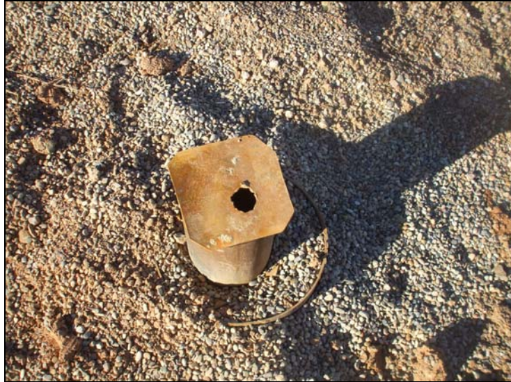
Imagen 14. Aspecto del cierre provisional del sondeo de Longares.
