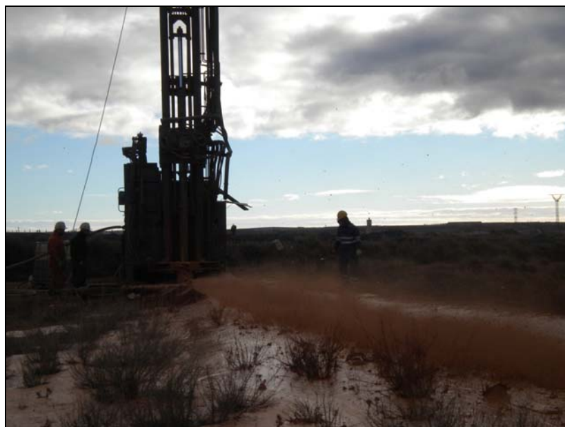
Imagen 3. Perforación del sondeo.
