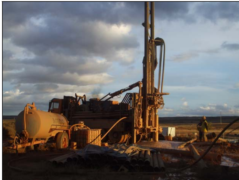
Imagen 5. Colocación de la tubería de 250 x 4 mm.
