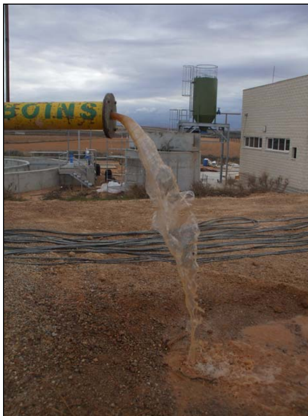
Imagen 3. Caudal extraído durante el primer escalón.
