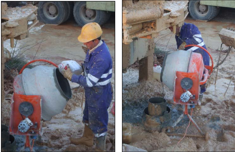
Imágenes 7 y 8. Adición del acelerante en la mezcla, y vertido de la misma en el interior del sondeo.
