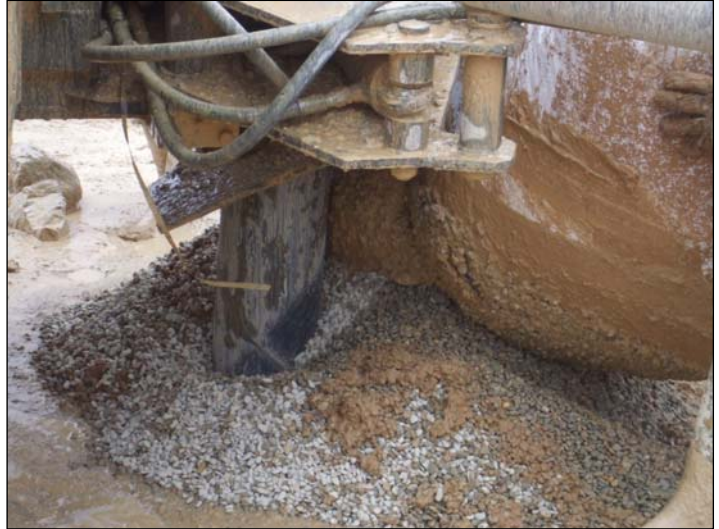
Imágenes 16 y 17. Engravillado del sondeo.
