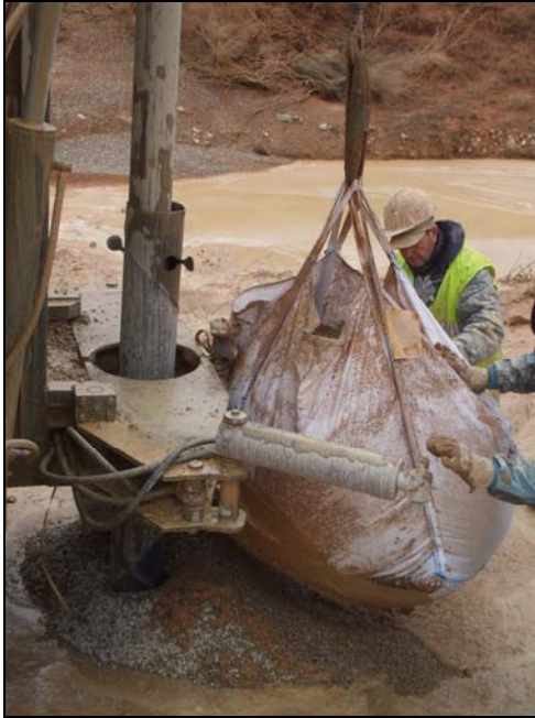
Imágenes 16 y 17. Engravillado del sondeo.
