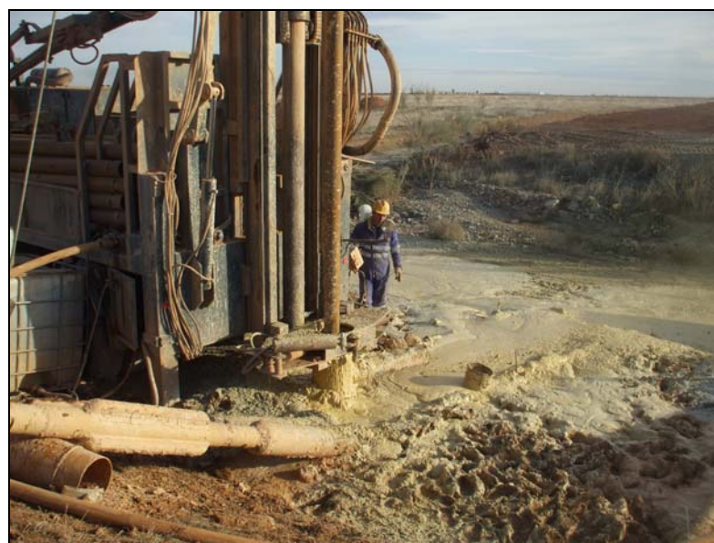
Imagen 3. Perforación del sondeo.
