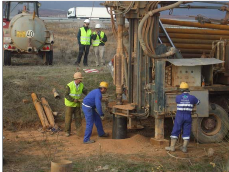
Imagen 2. Perforación por el interior del emboquille.
