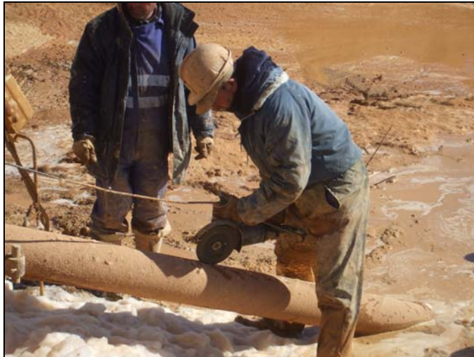
Imagen 14. Ranuración "in situ" del tramo inferior.
