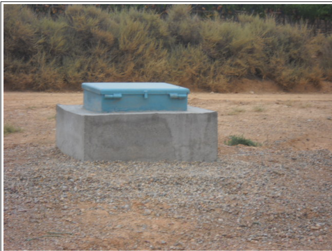
Aspecto de la Arqueta (10/05/2012)
