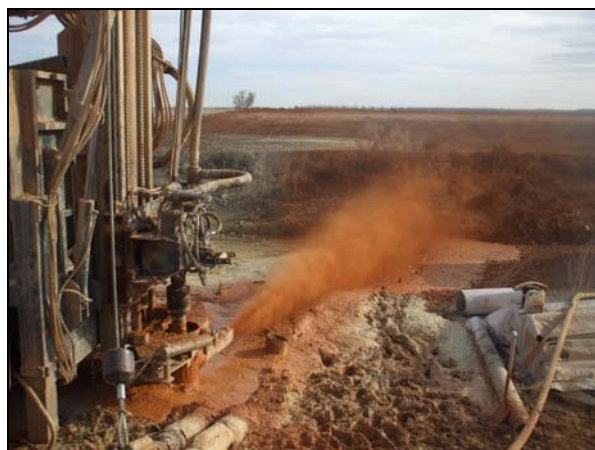
Imagen 11. Perforación del sondeo.
