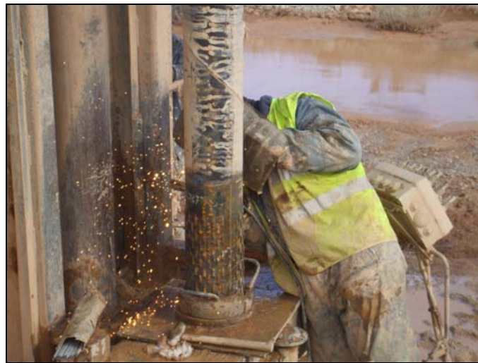
Imagen 15. Soldadura durante la entubación del sondeo.
