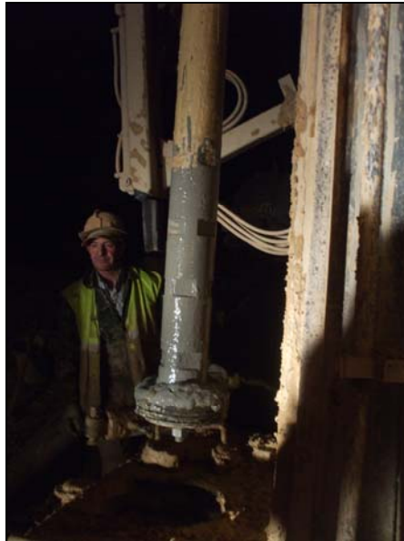
Imagen 10. Aspecto del pistón tras el cementado del sondeo.
