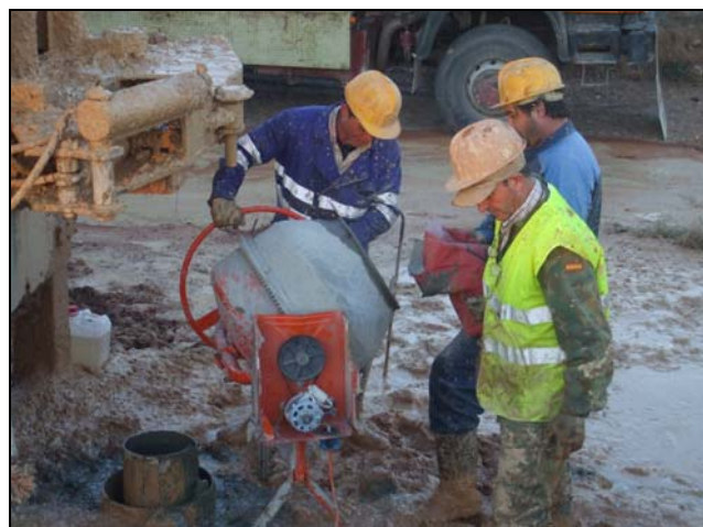
Imagen 6. Preparación del cemento en hormigonera.
