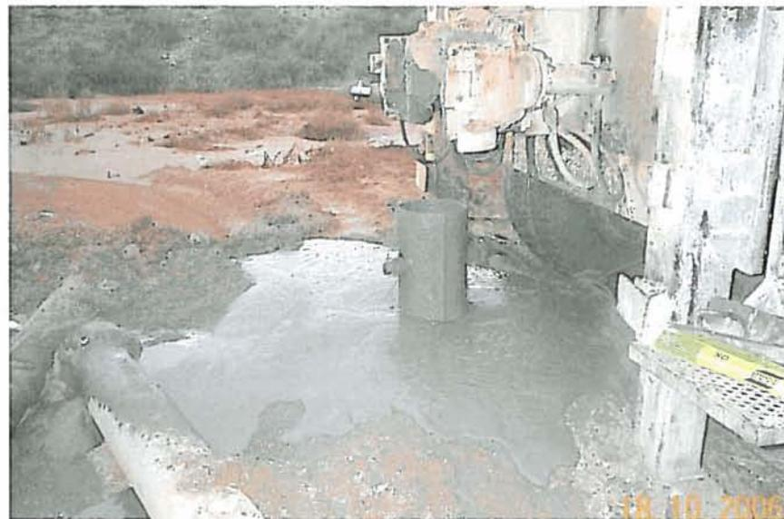
Estado del sondeo tras el vertido de hormigón en el emboquille.
