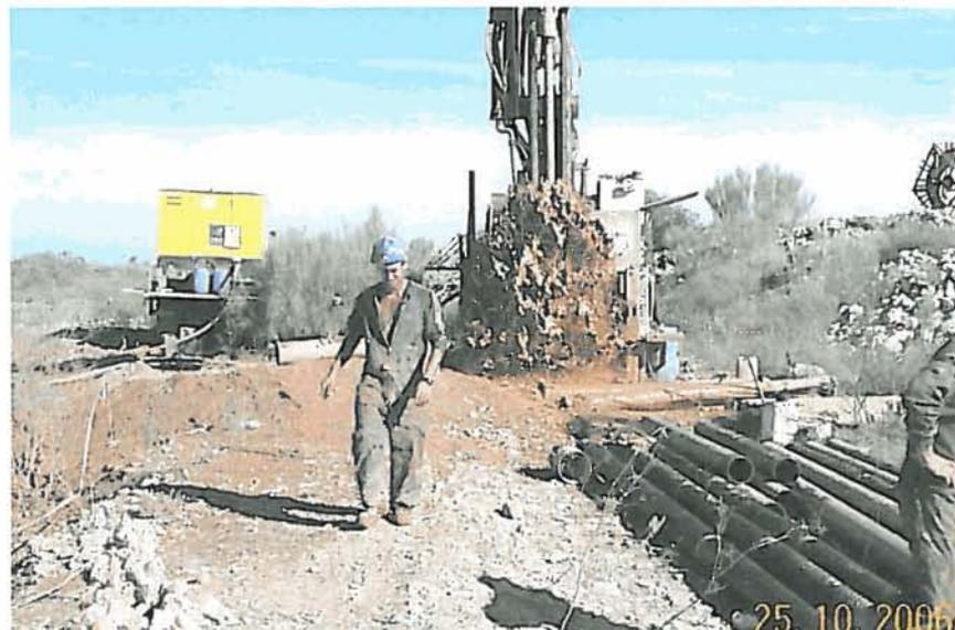
Soplado de la tubería durante la entubación
