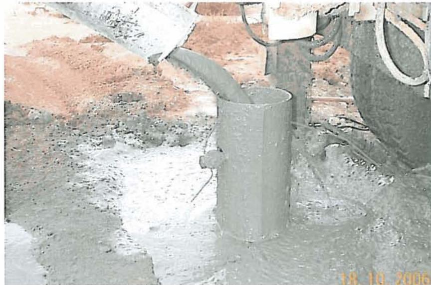
Cementación del anular y del fondo del sondeo.
