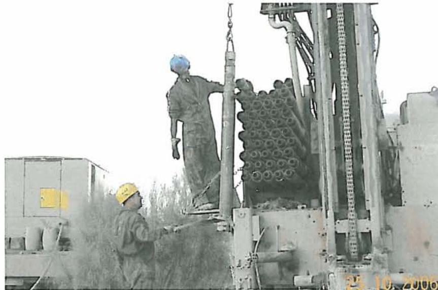
Final de extracción de varillaje y martillo de 165 mm de diámetro tras la limpieza
