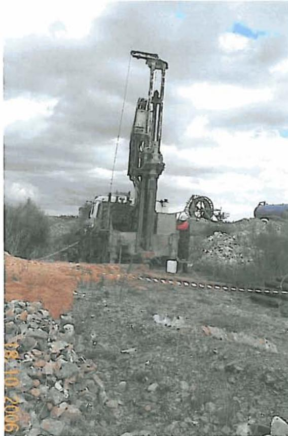
Perforación del emboquille y muestras extraídas.
