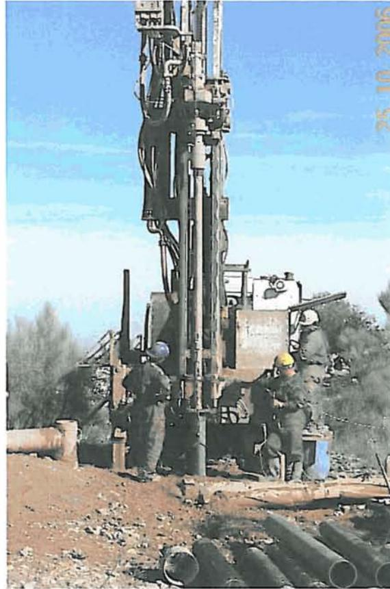
Entubación (empujando con el varillaje)
