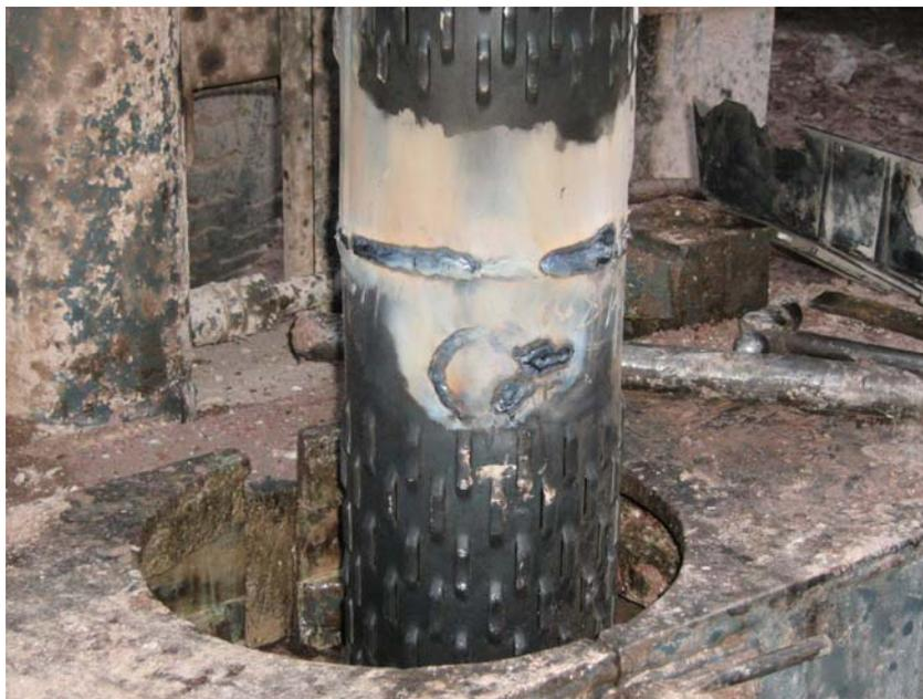
**Soldadura entre tuberías y cerrando orejetas**
