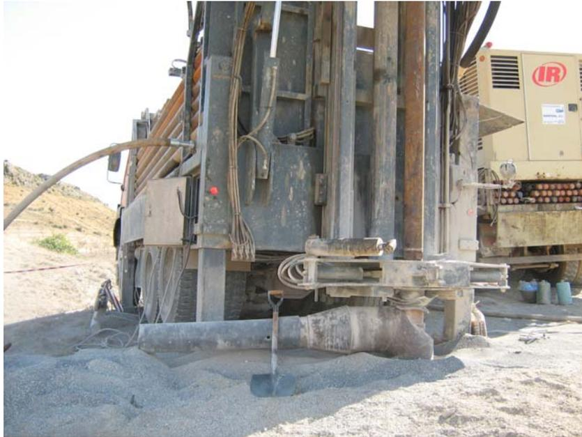
**Perforando a 45 m de profundidad (calizas de la Fm. Cuevas Labradas)**
