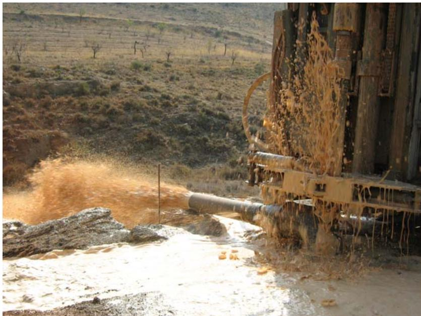
**Perforación a 243 m de profundidad (caudal muy elevado, entre 15-20 l/s)**
