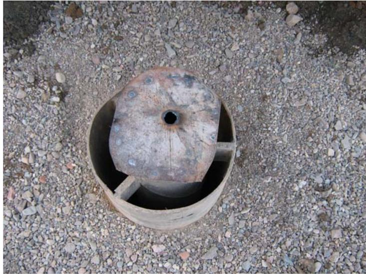
**Sondeo tapado con chapa metálica provisionalmente**
