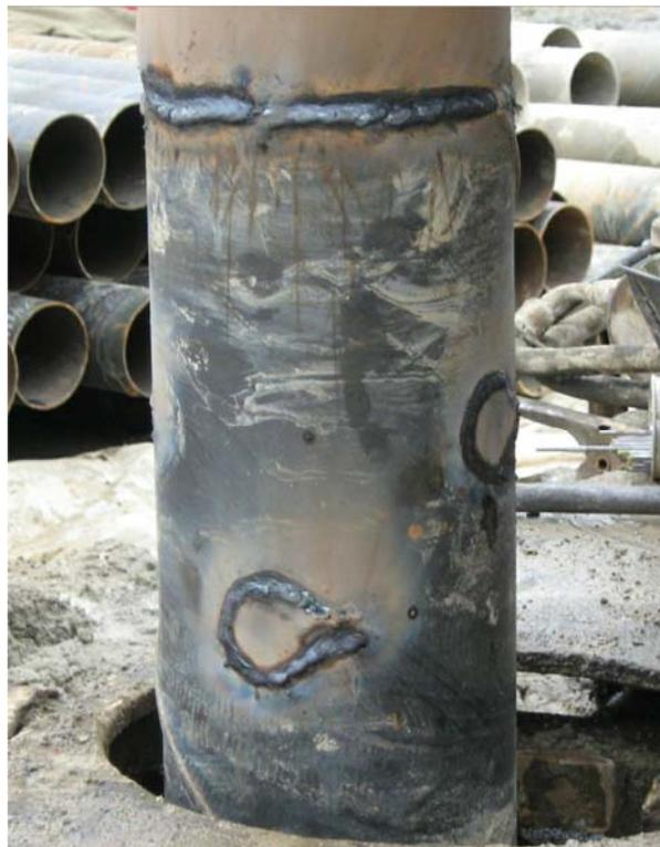
**Detalle soldadura cerrando orejetas y entre tuberías**
