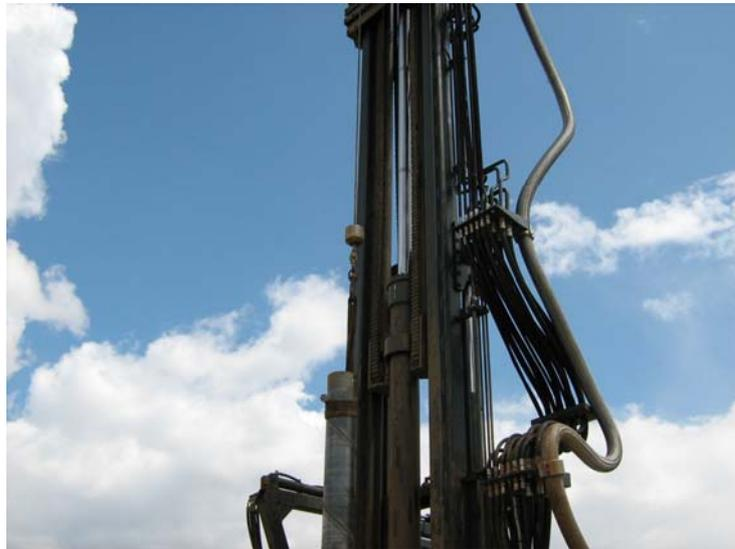
**Sujeción con cablestante de un tramo de tubería ciega de 6 m**
