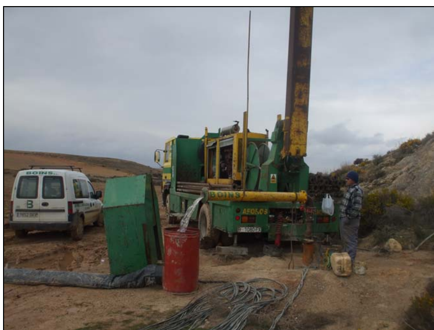
Imagen 1. Vista general del equipo de bombeo durante el aforo.
