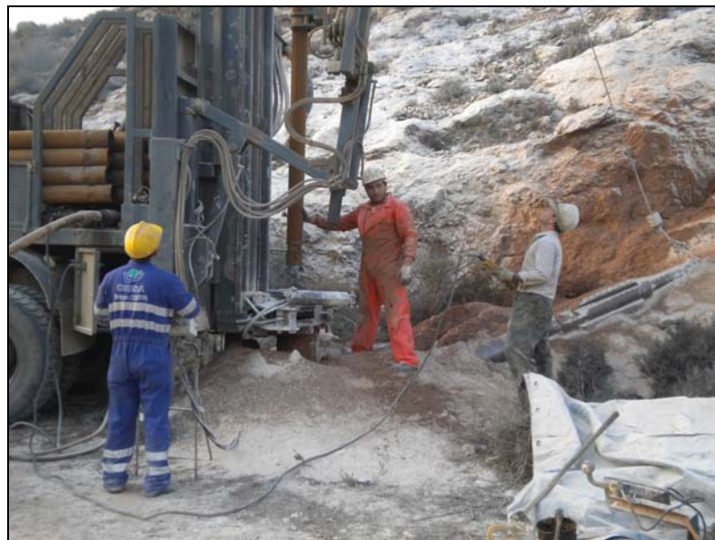
Imagen 3. Perforación del sondeo.
