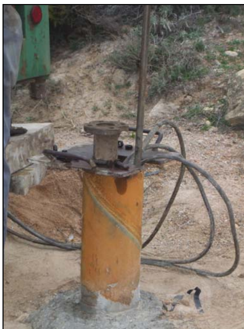
Imagen 2. Instalación del equipo de bombeo.
