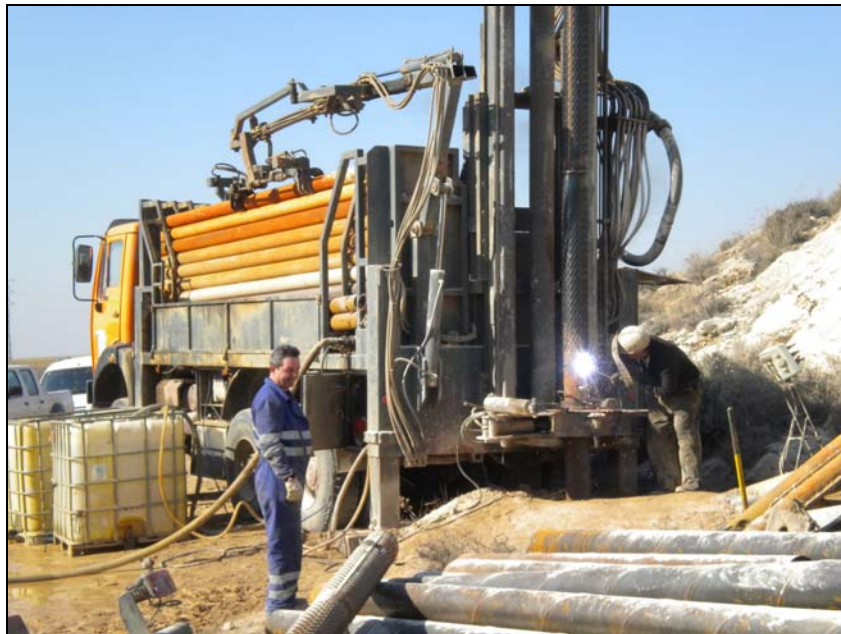
Imagen 6. Soldadura durante la entubación del sondeo.
