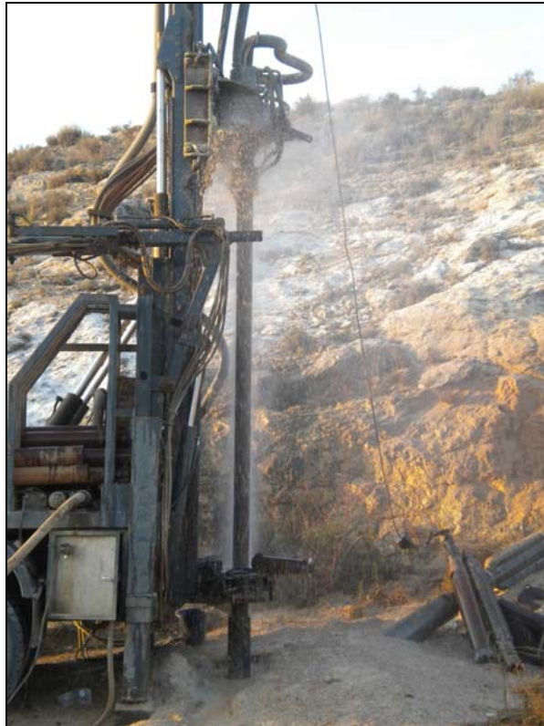
Imagen 7. Realización de limpieza.
