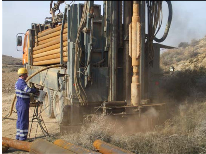
Imagen 2. Perforación del emboquille.
