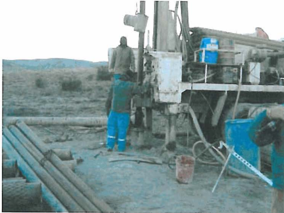
Fin perforación Arandiga (26/1/05 18:00)
