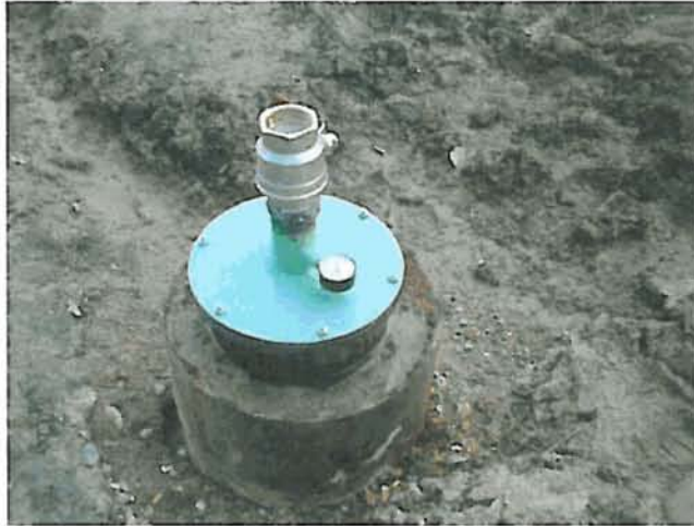
Detalle de la brida con manómetro y llave de bola
