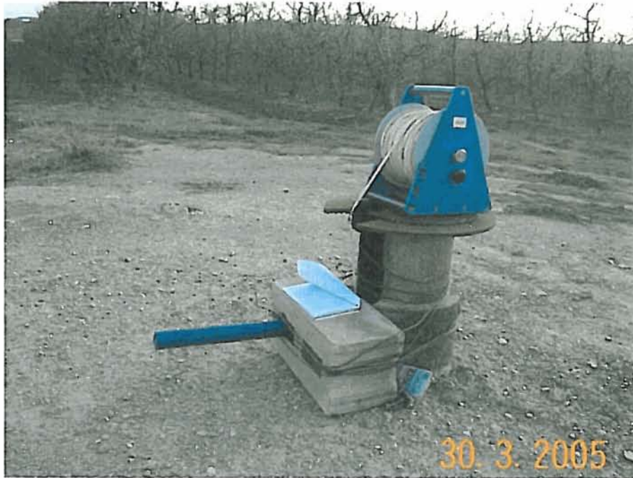
Control del sondeo de Valdechurlinos
