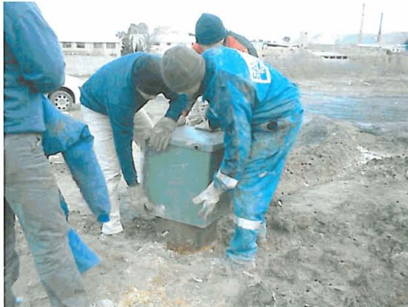
Colocación de la arqueta antivandálica.
