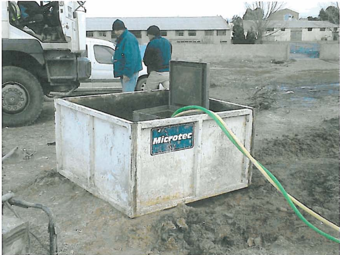
Encofrado preparado para el hormigonado del dado.
