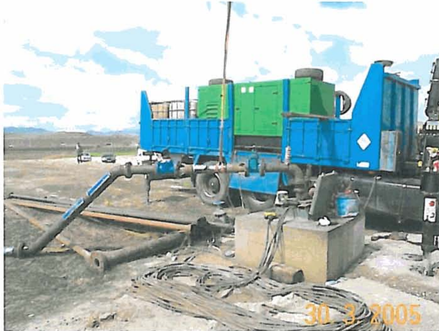
Instalación del equipo de bombeo
