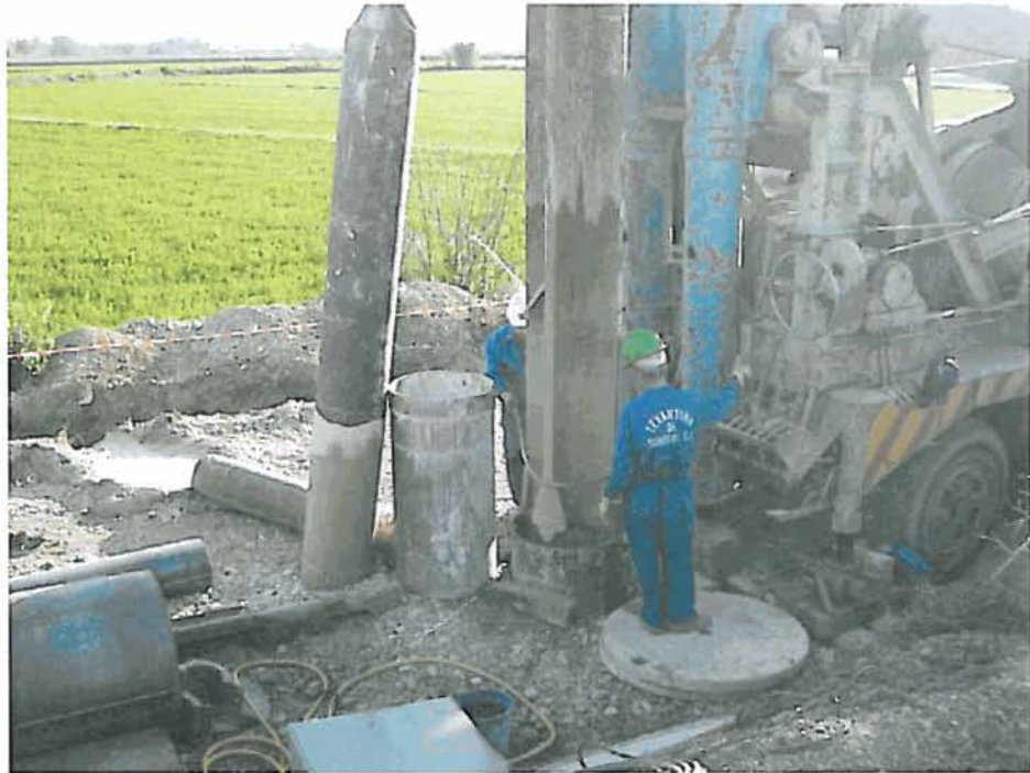
Detalle de la extracción del trépano para la limpieza del fondo
