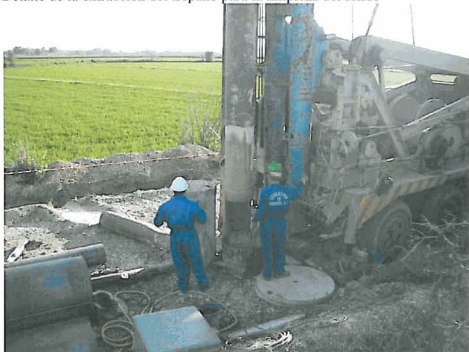
Extracción de la cuchara para ubicarla sobre la tubería que desagua sobre la zanja.
