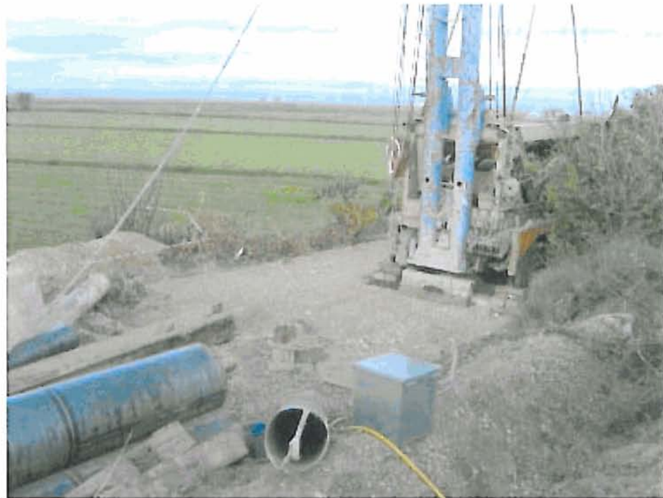
Maquina emplazada para piezómetro de Tauste
