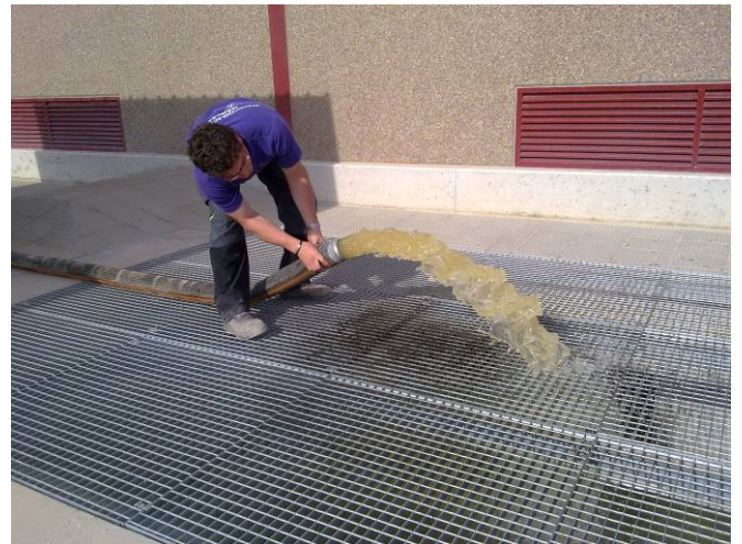
Ensayo de bombeo. Desagüe
