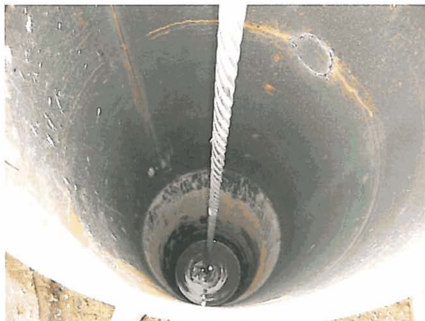
Se puede observar como el nivel ha subido por encima de los 6 metros.
