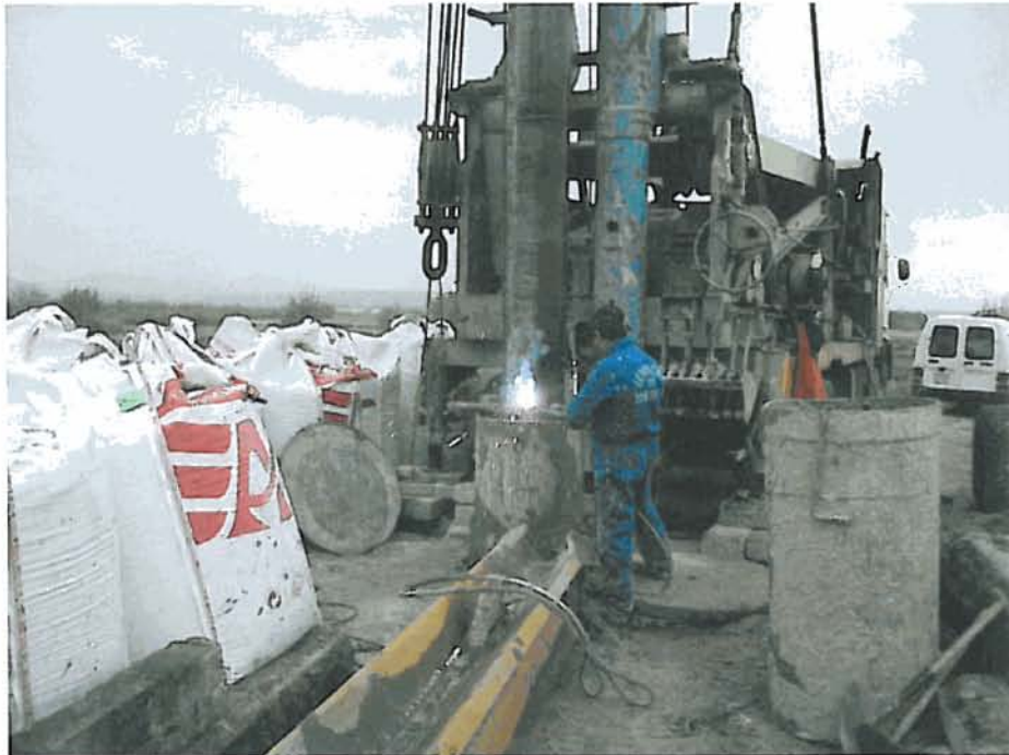
Soldadura del último tramo de ciega-puentecillo. Abajo, soldadura de la tapa provisional para evitar el vertido de gravilla durante el engravillado.
