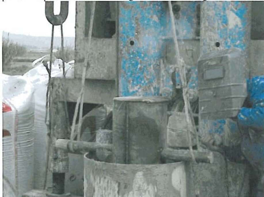
Soldadura del último tramo de ciega-puentecillo. Abajo, soldadura de la tapa provisional para evitar el vertido de gravilla durante el engravillado.
