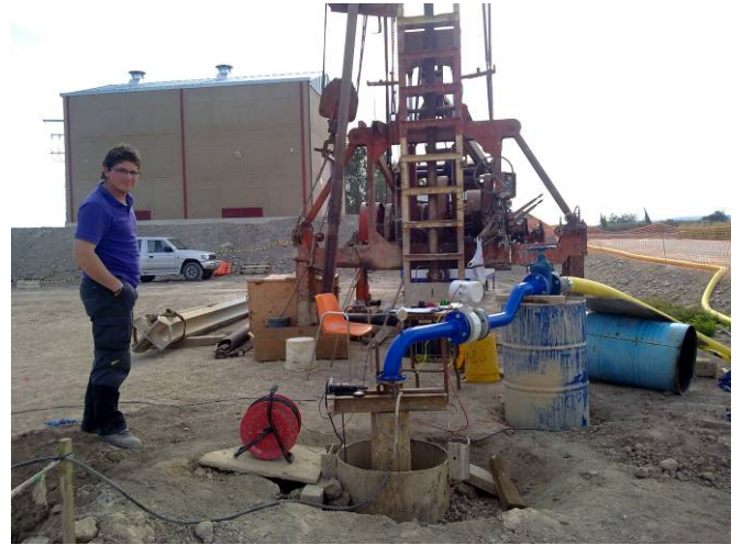
Ensayo de bombeo. Medida piezométrica pozo 1
