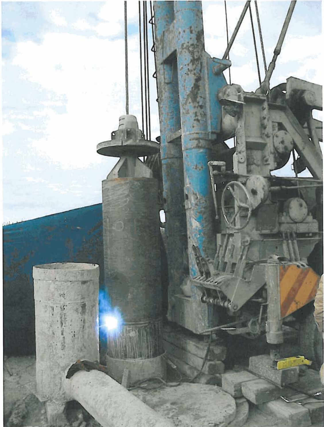
Soldadura de la tubería auxiliar y detalle del suplemento superior para empujar los tramos colocados.
