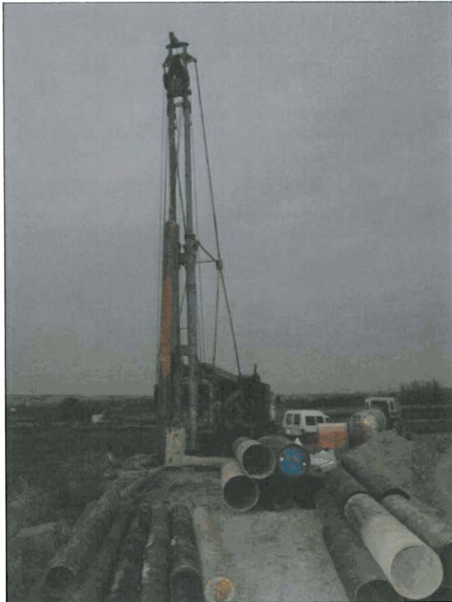
Perforación sondeo de Cortes en 2 m
