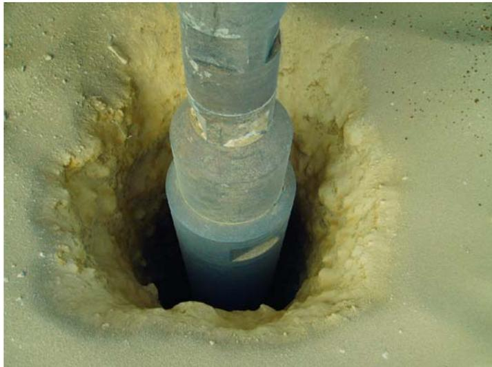
**Perforando en seco el "emboquille" (arenas y gravas, cuaternario)**
