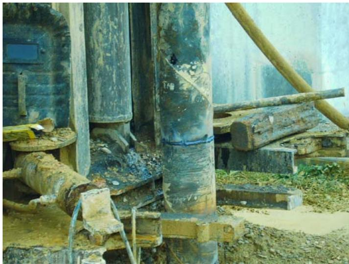
**Soldadura entre tuberías ciegas de 180 mm**
