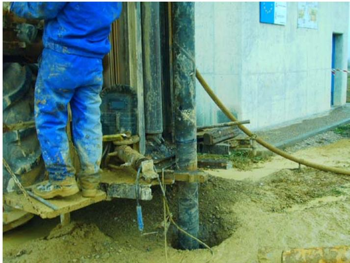
**Introduciendo la tubería de 180 mm**
