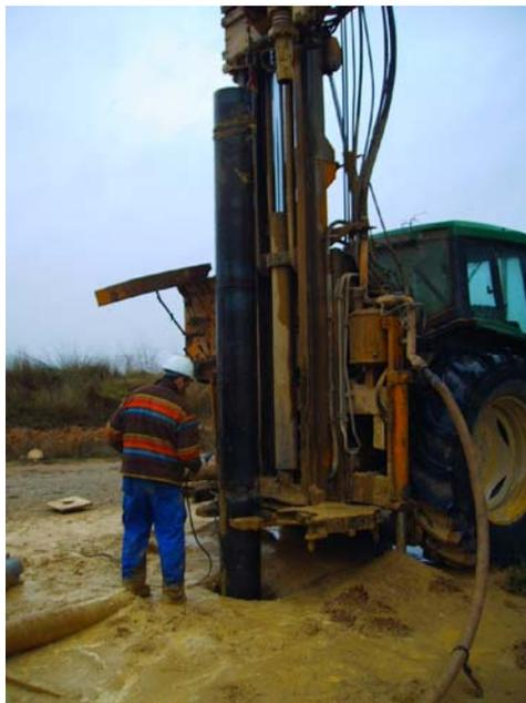
**Introduciendo la tubería de "emboquille"**
