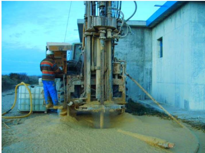
**Inyectando agua a la perforación**
