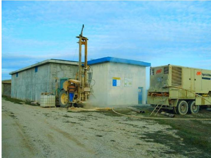
**Perforando en seco con el martillo de 324 mm**
