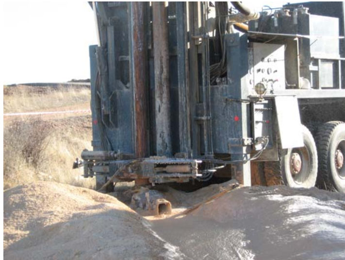
Perforando a 150 m con agua y espumante
