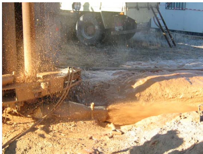
Perforando a 195 m de profundidad
