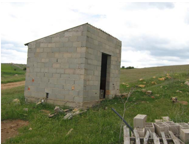
Caseta donde se ubica el sondeo 2001-P-1481
