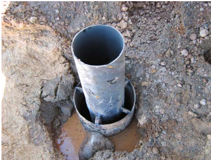
Tubería de 180 mm soldada con 4 tacos de acero a la tubería de 300 mm
