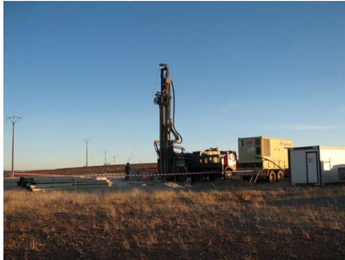
Vista del emplazamiento durante la perforación
