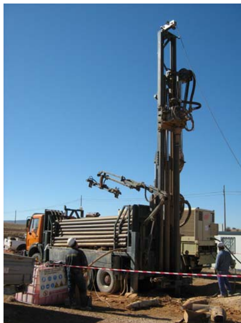
Introduciendo la maniobra para la limpieza del sondeo
