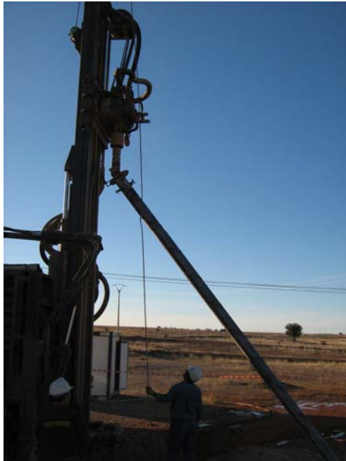
Elevando un tramo de tubería ciega
