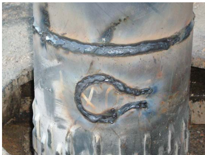
Detalle soldadura entre tuberías y cerrando orejetas
