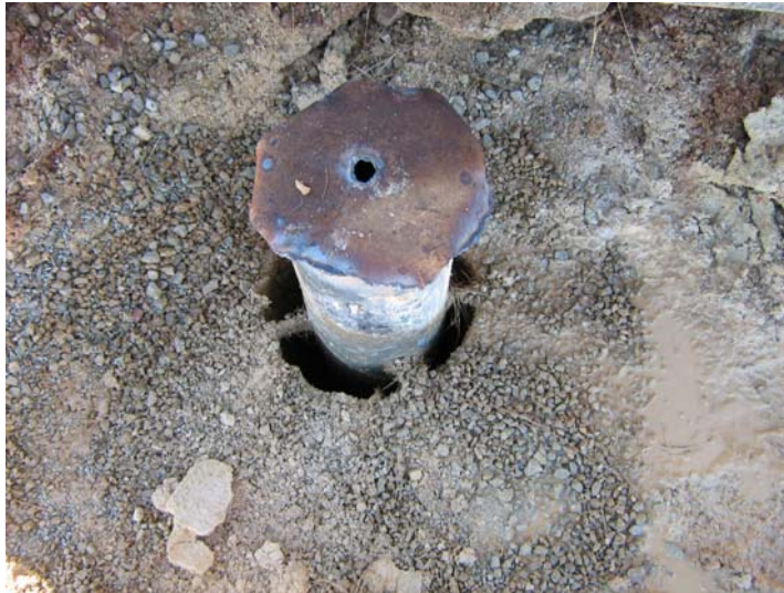
Sondeo tapado provisionalmente con chapa metálica
