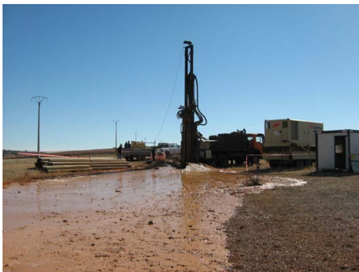
Emplazamiento durante la perforación
