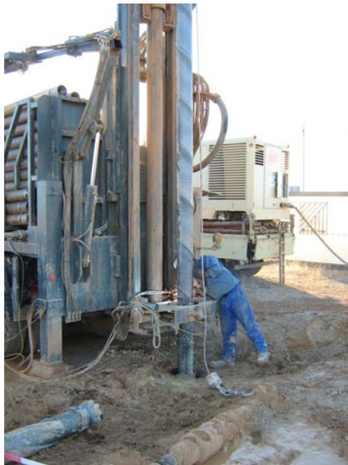
Soldando dos tramos de tubería
