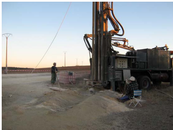
Perforando a 220 mm de diámetro a 75 m de profundidad (arenas finas amarillentas)
