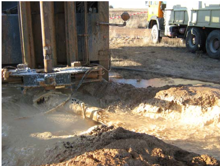
Perforando a 248 m de profundidad
