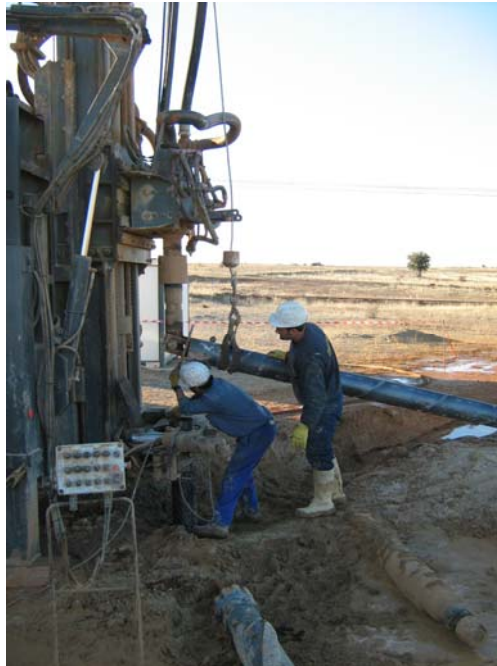
Elevando un tramo de tubería con el cabezal de la máquina
