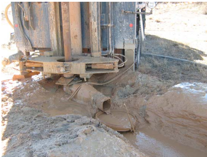
Perforando a 208 m de profundidad (caudal entorno a 1-1,5 l/s)
