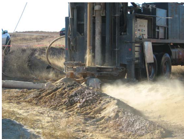
Perforando a 85 m de profundidad
