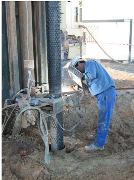
Soldando dos tramos de tubería de filtro
