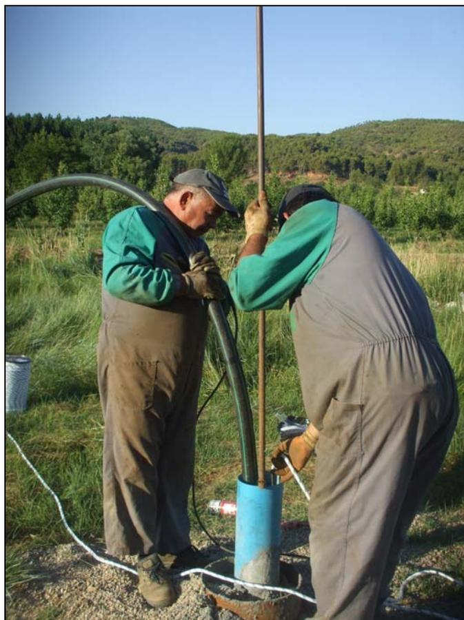
*Imagen 3. Instalación del equipo de aforo.*
