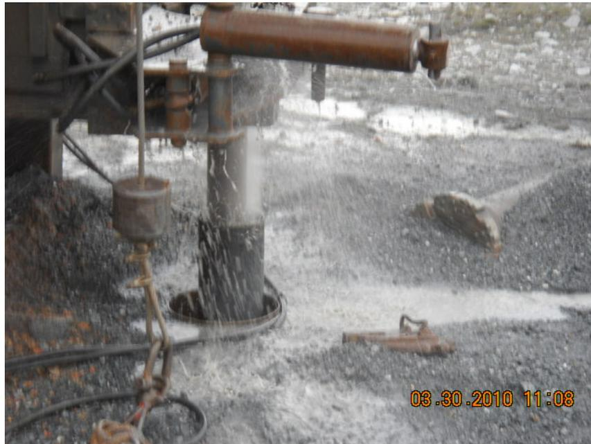
Fig. 7. Detalle de la salida del agua por la boca del sondeo durante las labores de limpieza.
