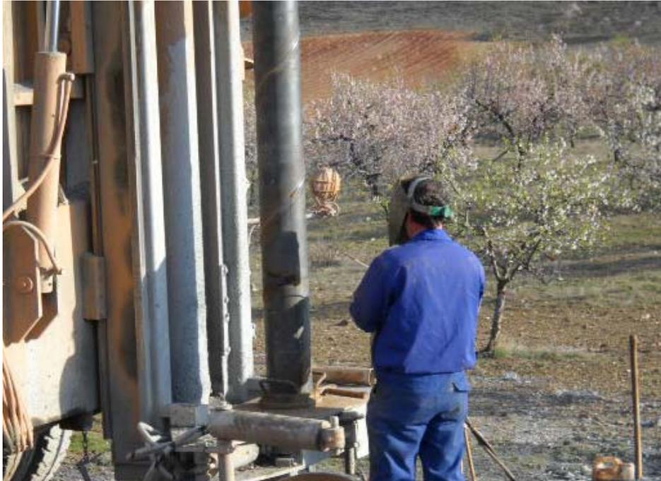
Fig. 6. Trabajos de soldadura durante la entubación del Sondeo de Munebrega
