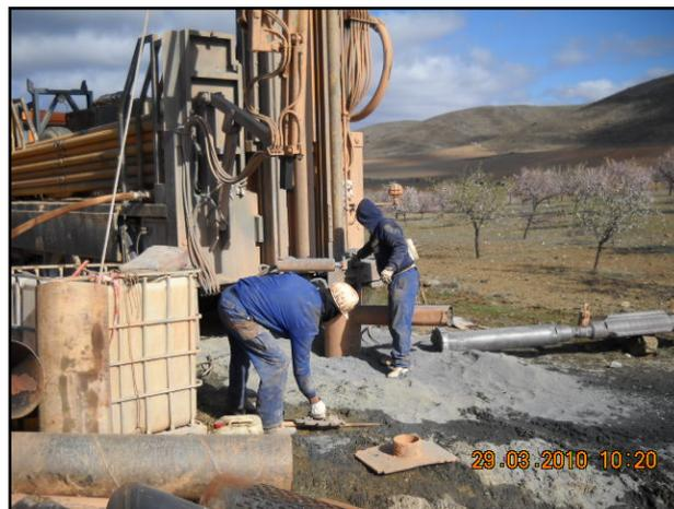
Fig.2. Labores de preparación después de finalizar el entubado del emboquille
