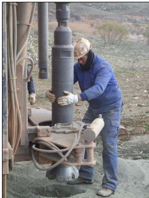
**Foto 2.** Extracción del martillo con el que se ha perforado el emboquille.
