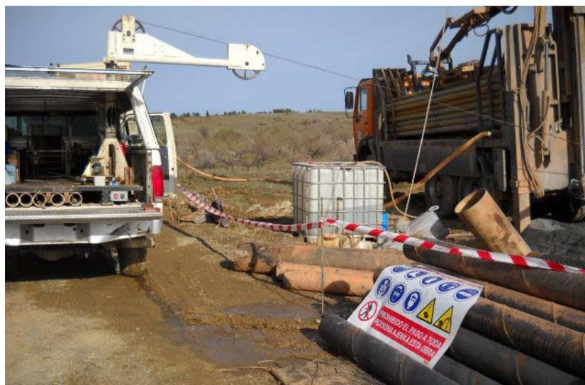
Fig. 5. Detalle del sistema de poleas por el que se realiza la bajada de las sondas-
