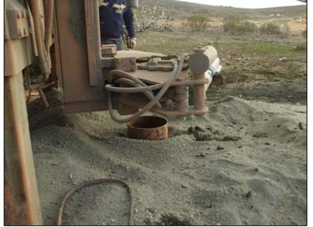
**Fotos 3 y 4.** Colocación de la tubería de emboquille.
