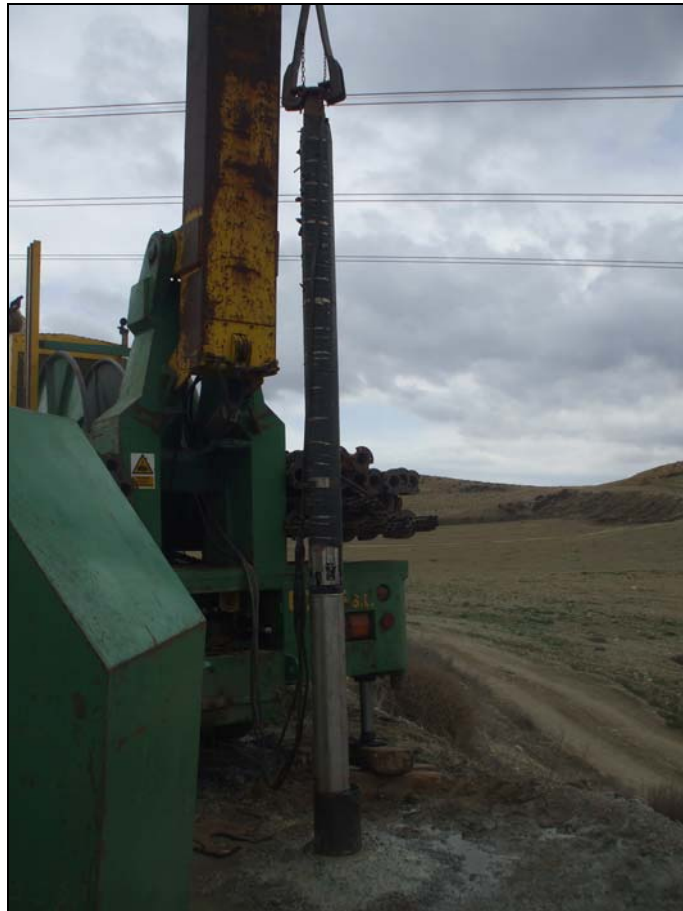
Imagen 2. Bomba instalada para el ensayo de bombeo.
