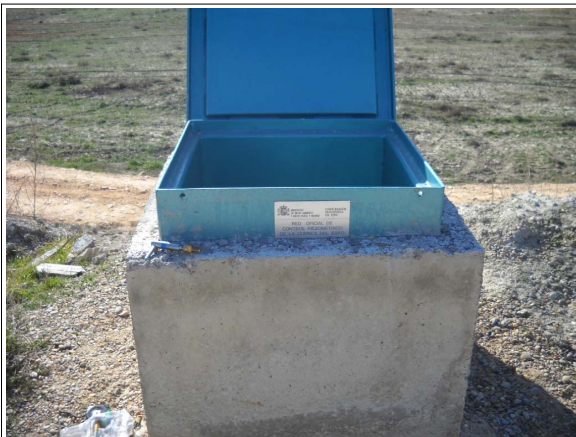
Detalle de la Arqueta (10/05/2012)
