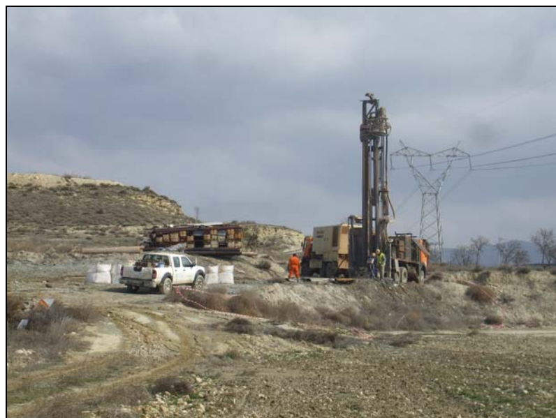
Imagen 1. Vista general del sondeo de Calatayud.
