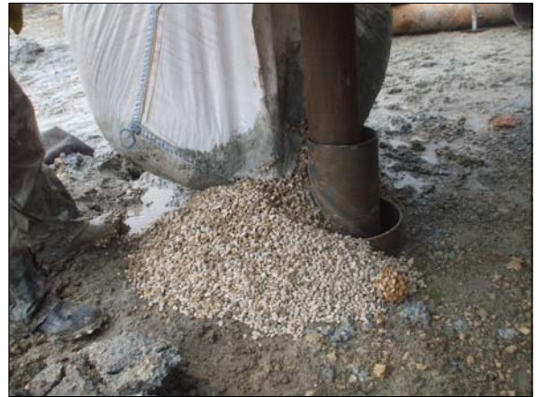
Imágenes 5 y 6. Engravillado del sondeo.
