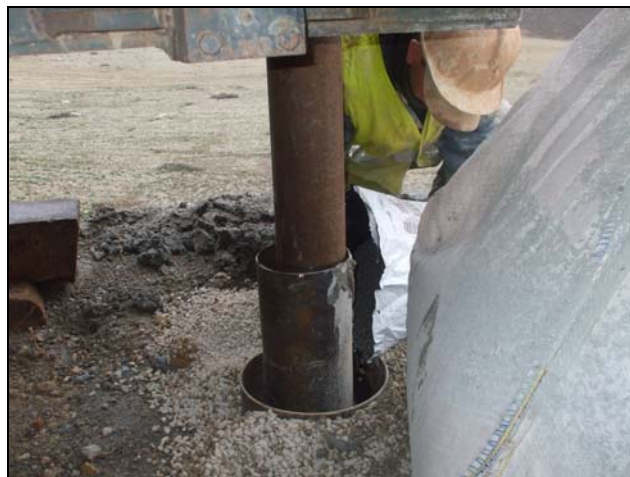
Imágenes 7. Colocación del sello bentonítico (mikolit).
