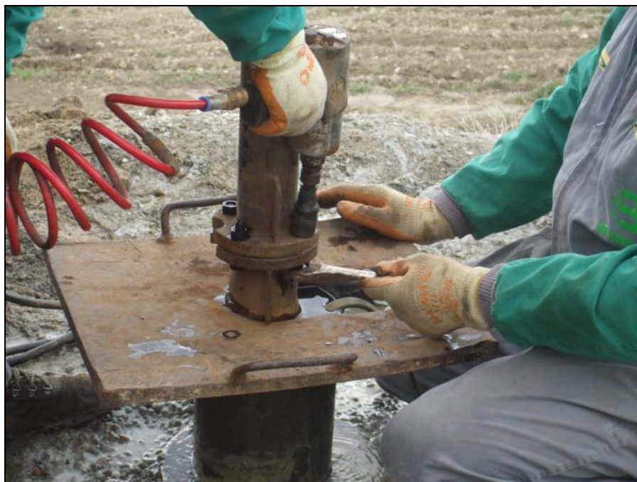
Imagen 3. Instalación del equipo de bombeo.
