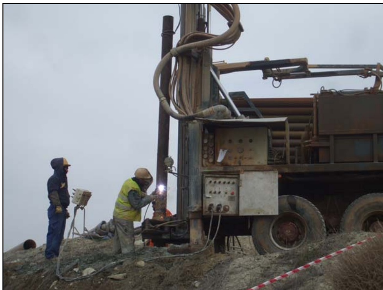
Imagen 4. Labores de entubación del sondeo.
