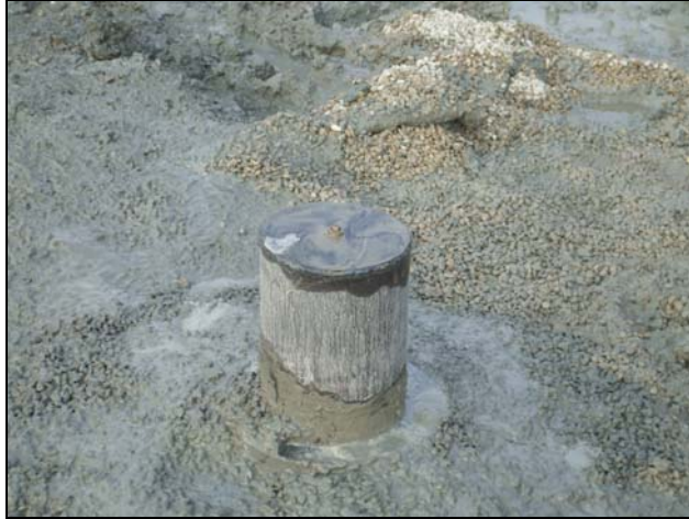
Imagen 10. Aspecto del cierre provisional del sondeo de Calatayud.
