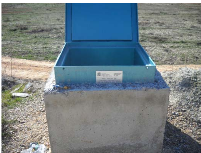
05/2012 Detalle de la Arqueta ACCESO
