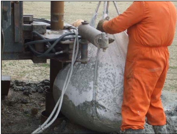
Imágenes 5 y 6. Engravillado del sondeo.
