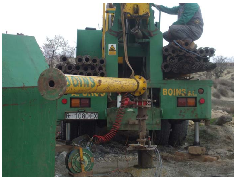
Imagen 4. Instalación del equipo de bombeo.
