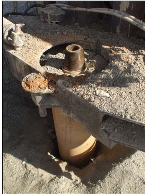
Imagen 2. Perforación por el interior del emboquille.
