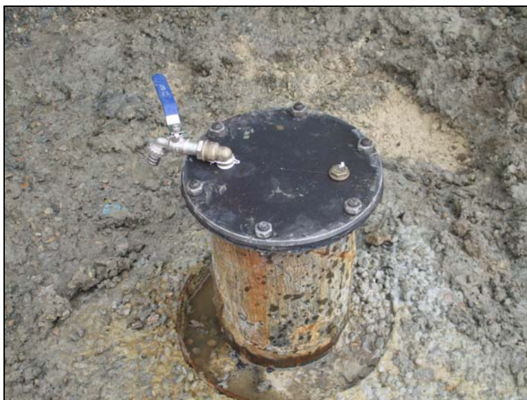
Imagen 11. Colocación de tapa estanca.
