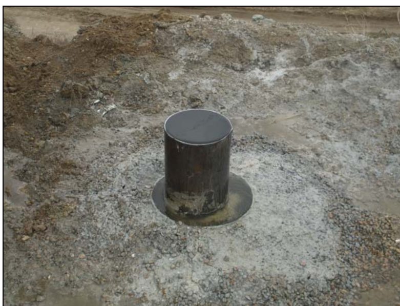
Imagen 1. Aspecto del sondeo antes de comenzar.
