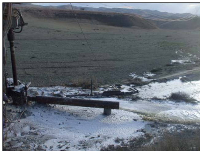
Imagen 3. Perforación del sondeo.
