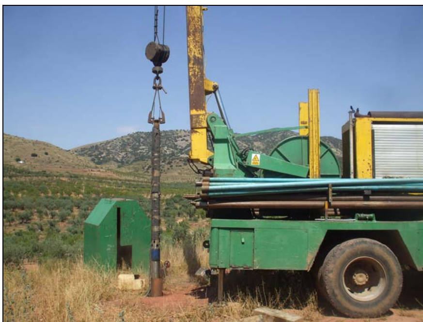
Imagen 1. Colocación de la bomba.
