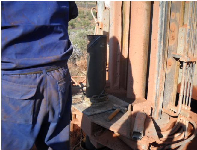
Fig. 9. Detalle del dispositivo de centrado usado durante la entubación
