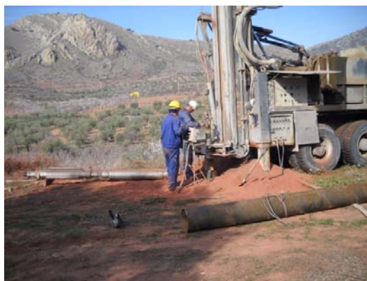
Fig.5. Labores previas a la realización del emboquille
