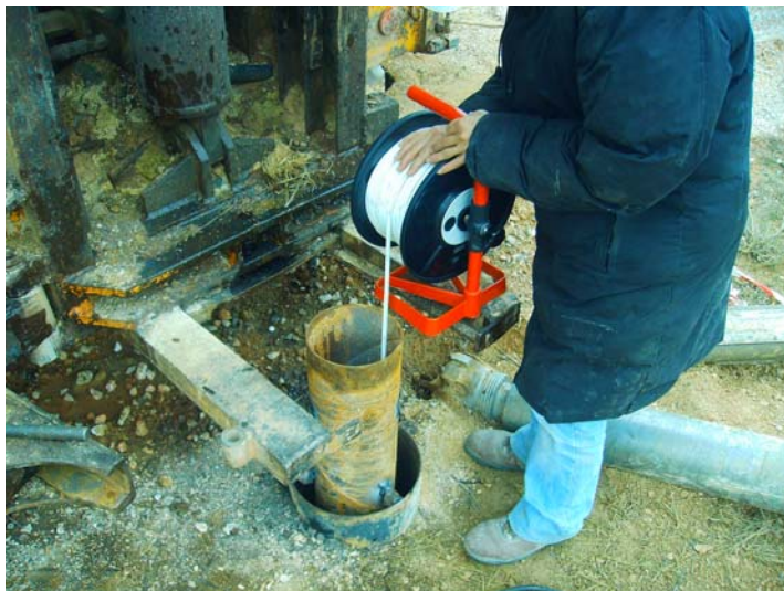
Midiendo el nivel tras la entubación y unión de la tubería de 180 a la de 300 mm
