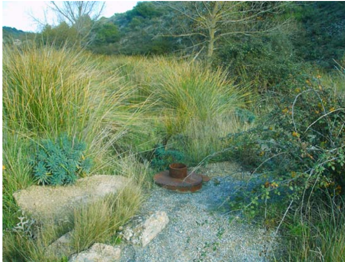
Piezómetro Z-36 bis antes de acondicionar
