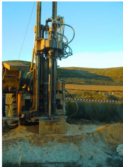
Perforación con el martillo de 220 mm de diámetro
