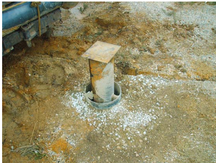
Chapa metálica tapando el sondeo provisionalmente
