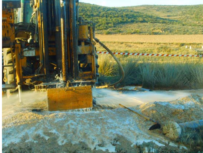
Perforando tras cortar nivel
