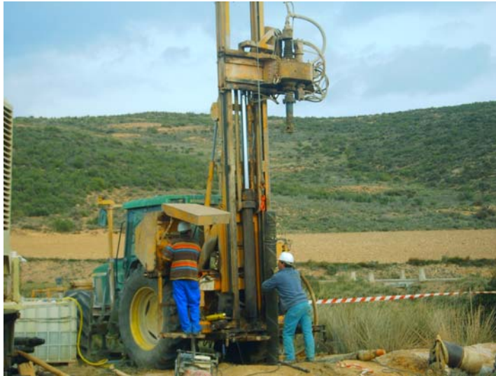
Entubando los últimos metros
