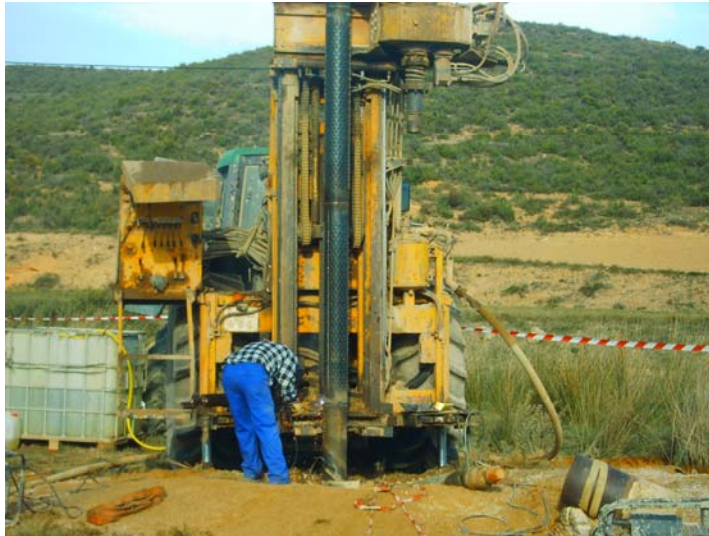
Soldando durante la entubación
