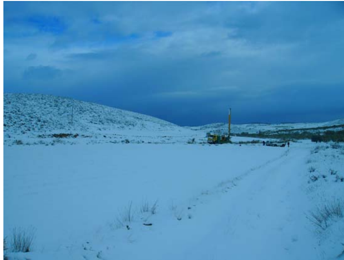
Vista del equipo en el emplazamiento durante el aforo (20/03/07)
