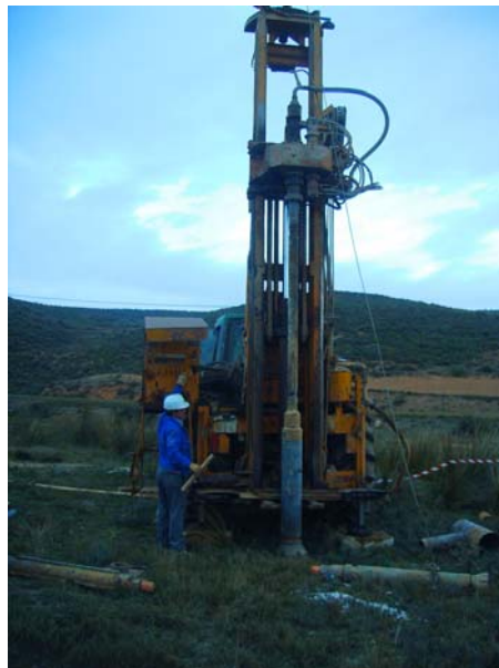
Nivelación y comienzo de la perforación con el martillo de 324 mm de diámetro
