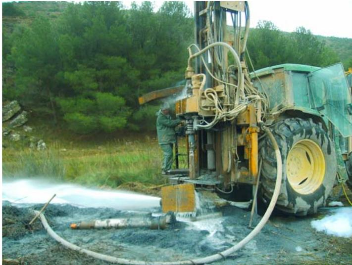
**Perforando con el martillo de 220 mm (a los 140 m de profundidad)**
