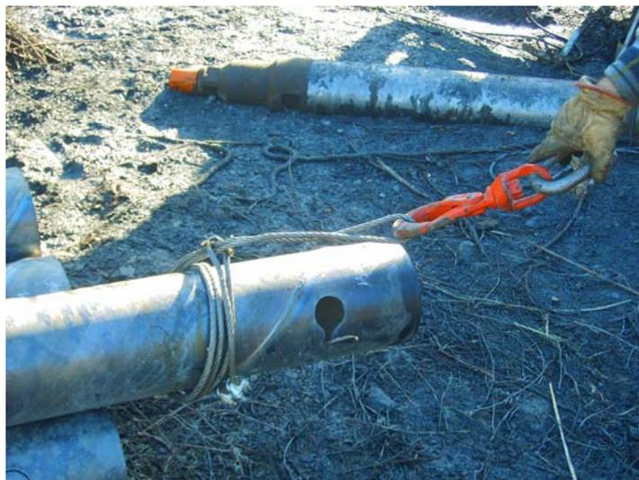
Engarzado del cable de acero de la maquina con la tubería antes de elevarla
