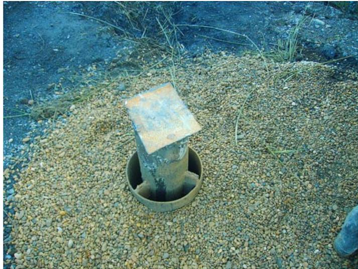
**Sondeo tapado con chapa metálica provisionalmente**
