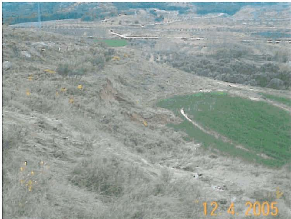
Zona afectada por el ensayo de bombeo.
