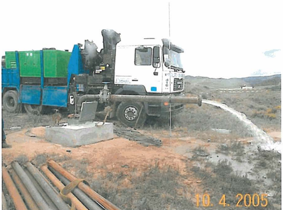
Ensayo de bombeo de Tarazona
