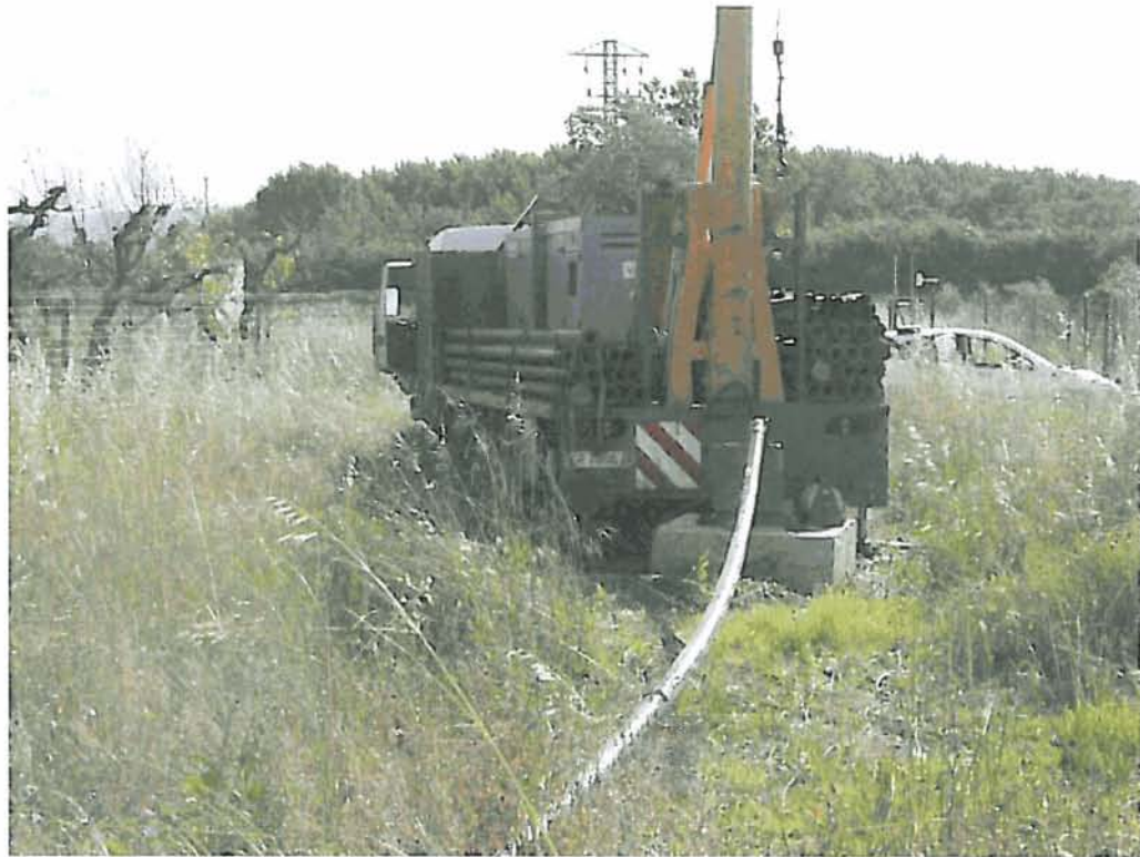
Detalle del emplazamiento del piezómetro.
