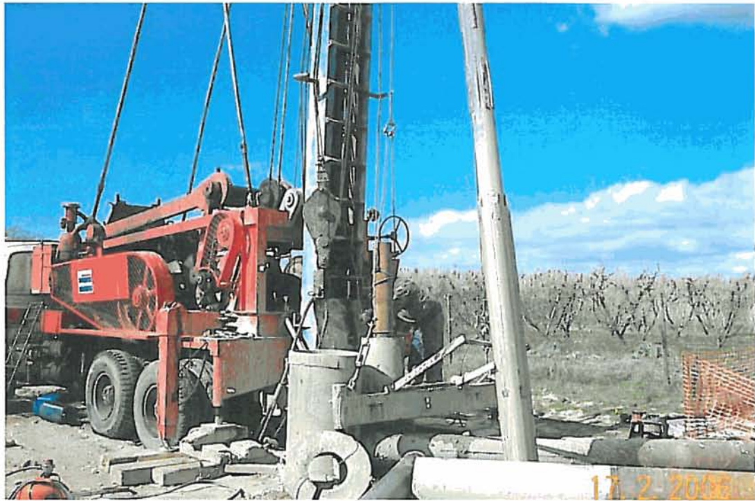
Entubación del piezómetro
