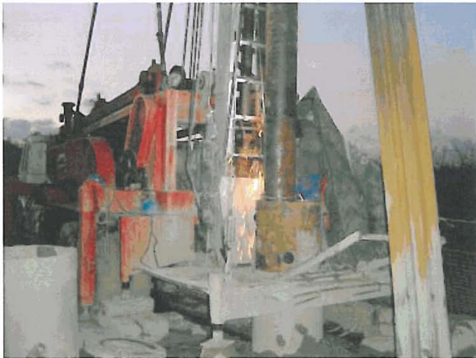
Entubación sondeo De Rincón de Soto
