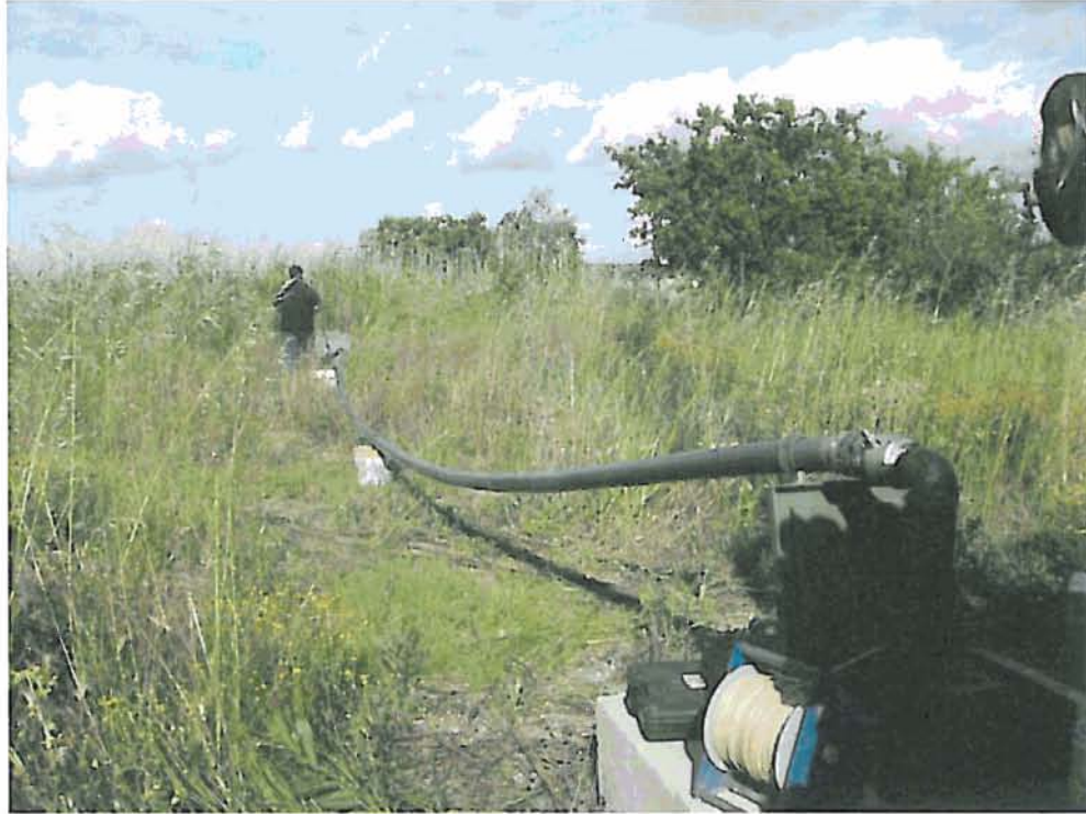
Montaje del equipo de bombeo
