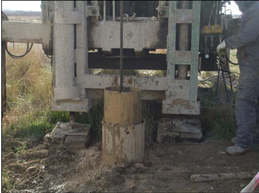
*Imagen 3. Uso de tubería auxiliar durante la perforación del sondeo.*
