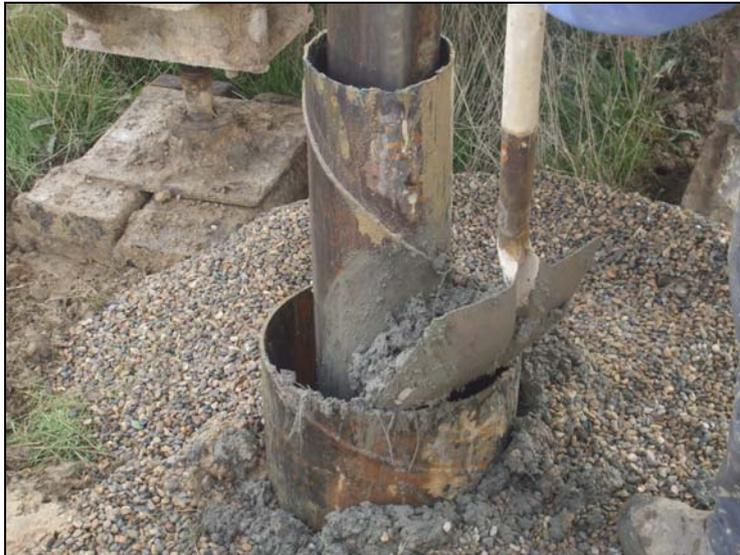
*Imagen 9. Cementado de la parte superior del sondeo.*
