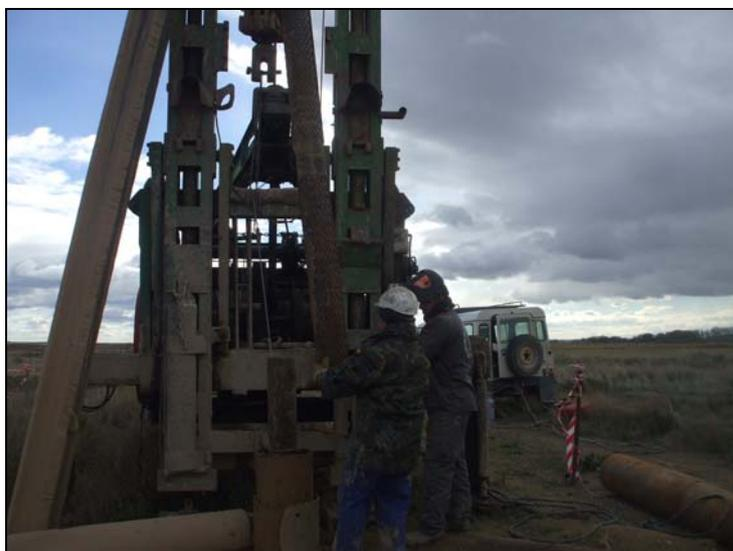
**Imagen 5.** Labores de entubado del sondeo.
