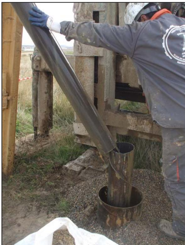
**Imagen 8.** Realización de limpieza mediante valvuleo.
