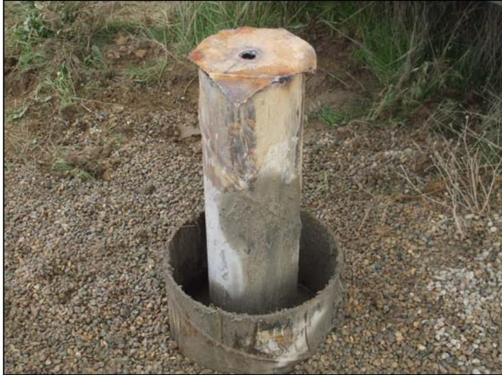
**Imagen 10.** Colocación de la tapa superior.
