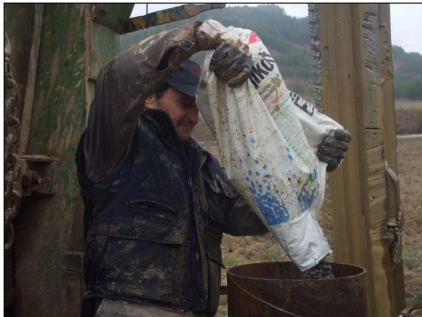
Imagen 10. Vertido del compactonit en el sondeo.
