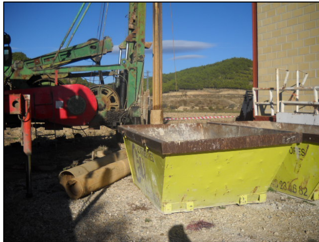
Fig.5. Detalle de las labores de perforación y la de los contenedores dispuestos para los detritos.
