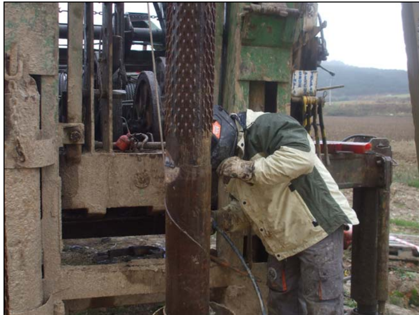
Imagen 8. Soldadura de tubería.
