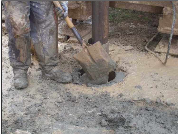
Imagen 12. Cementado de la parte superior del sondeo.
