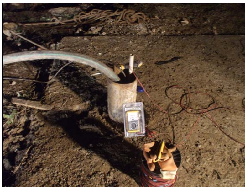
Imagen 1. Instalación del equipo de bombeo.
