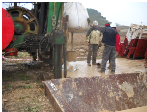
Fig.5. Aspecto de las labores de engravillado
