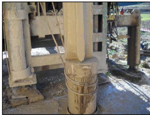
Fig.6. Detalle del cierre provisional del sondeo.
