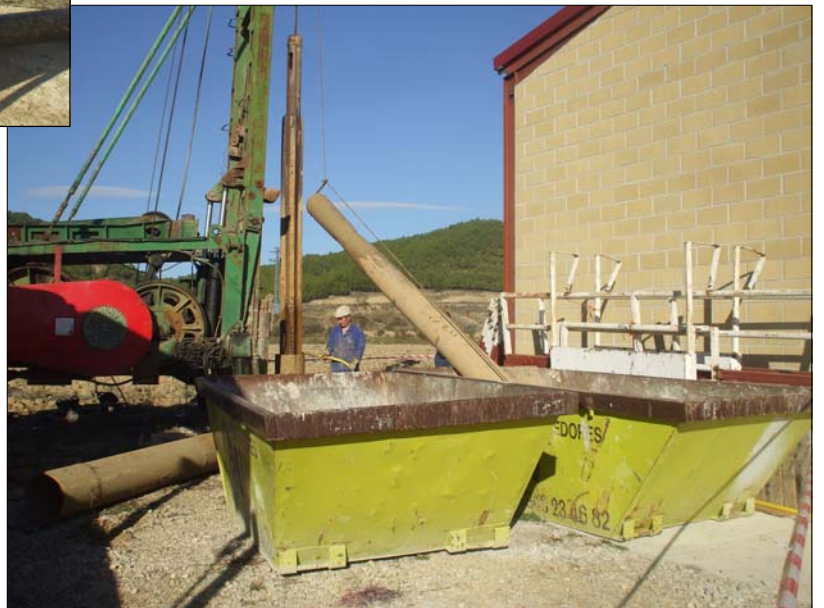
Imágenes 4, 5, 6 y 7. Vistas generales de la obra y diversos momentos de la perforación.
