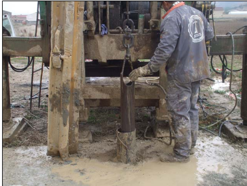
Imagen 11. Realización de limpieza mediante valvuleo.
