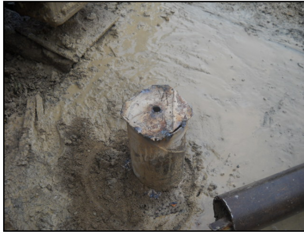
Fig.9. Cementación del sondeo y cierre definitivo
