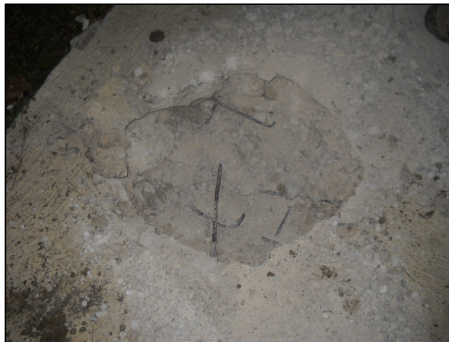
Fig.3. Perforación de la losa de Hormigón.
