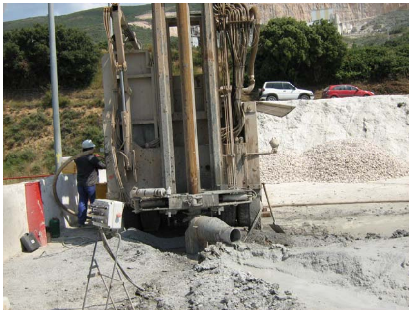
Perforando a 220 mm de diámetro a 65 m de profundidad
