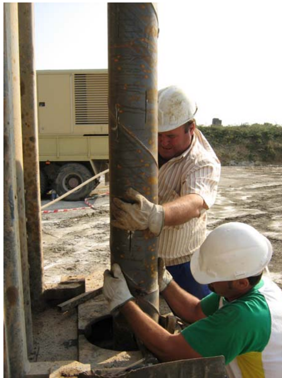
Colocando un tramo de tubería ranurada para ser soldada al tramo anterior
