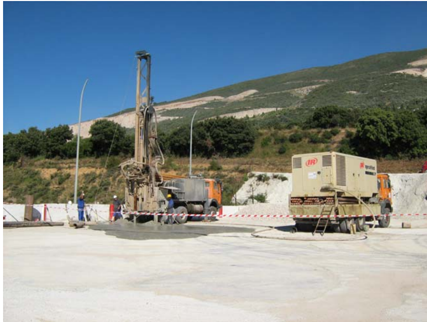
Maquinaria trabajando en el Emplazamiento de Tiebas
