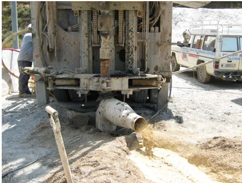
Perforando a 180 m de profundidad
