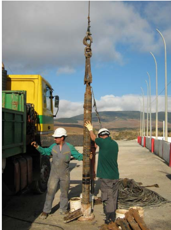
Introduciendo la bomba
