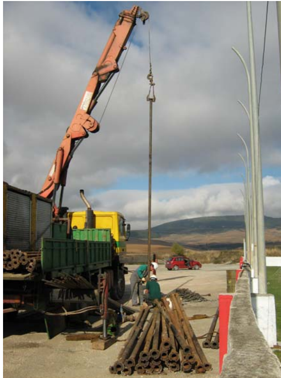
Uniendo tuberías con el taladro
