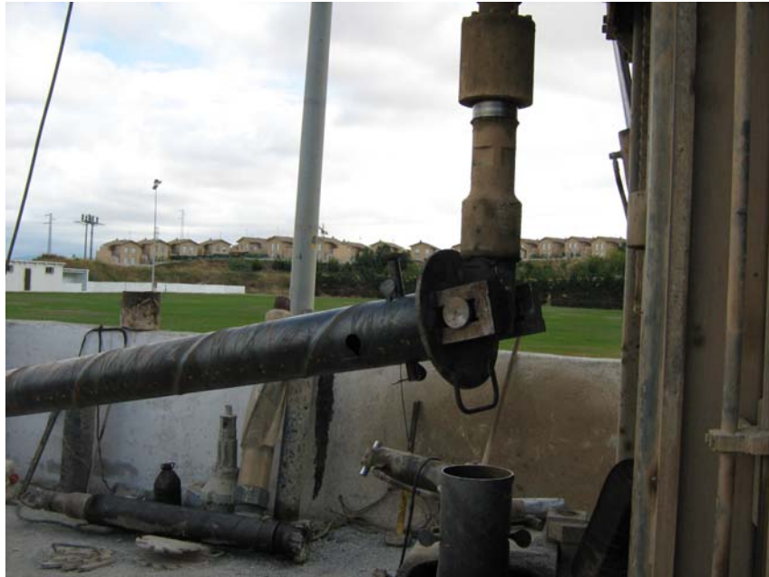
Elevando un tramo de tubería ciega
