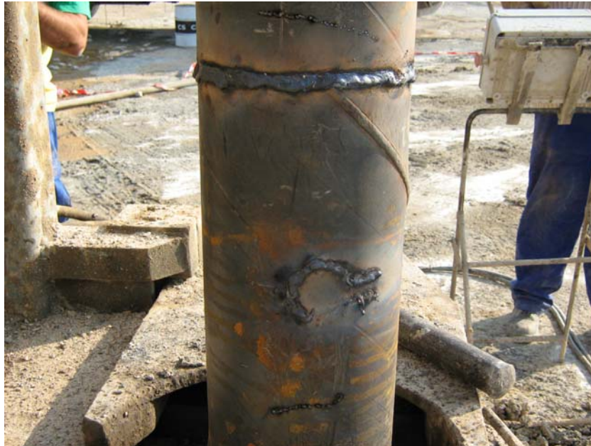
Detalle soldadura entre tuberías y cerrando orejetas
