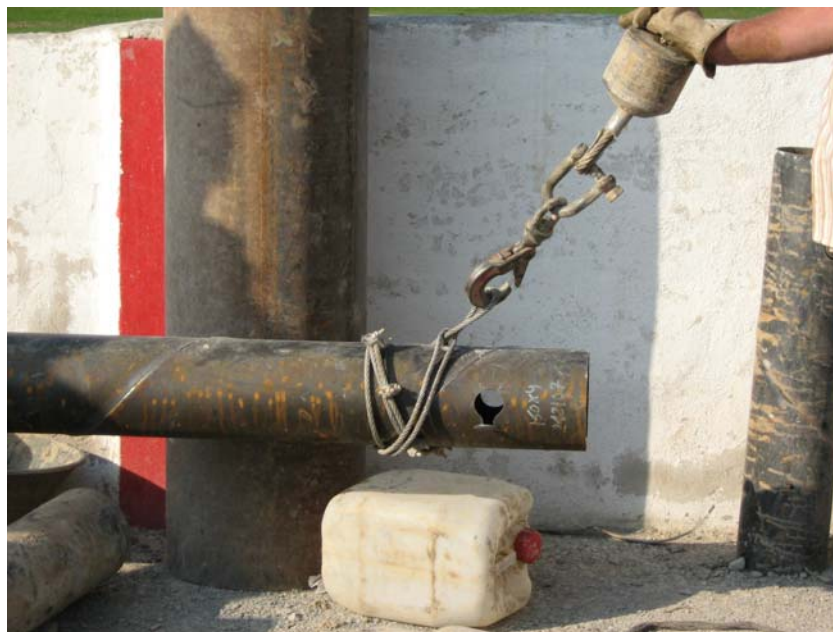
Detalle unión cablestante con cable metálico para elevar la tubería
