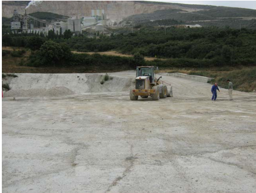
Finalizando la limpieza del emplazamiento
