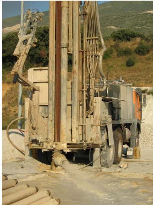
Perforando a 165 m de profundidad
