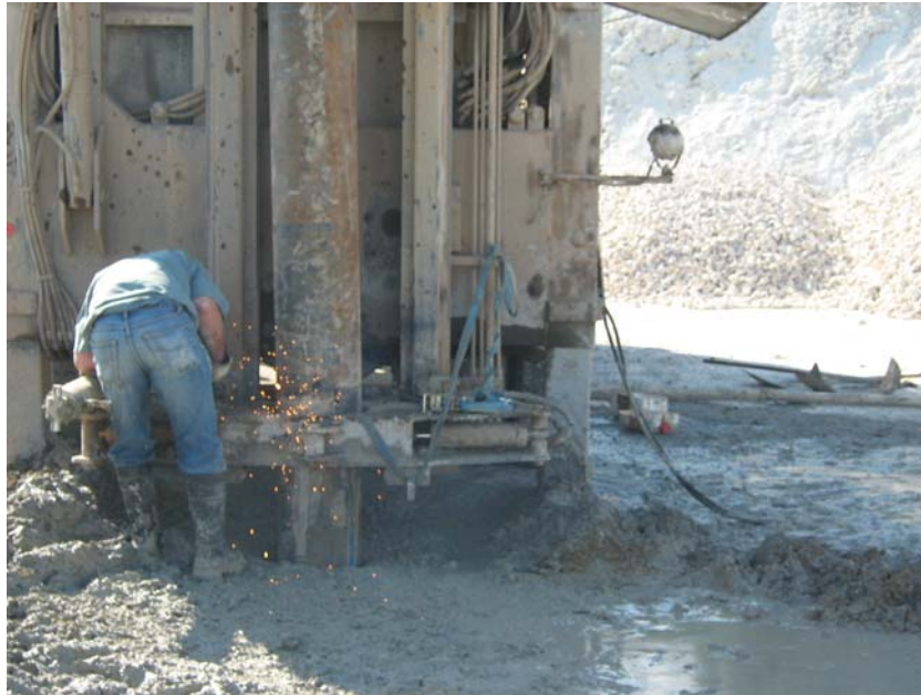
Soldando dos tramos de tubería de 300 mm
