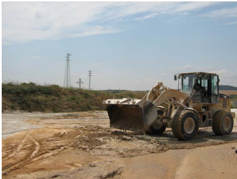
Pala limpiando el emplazamiento
