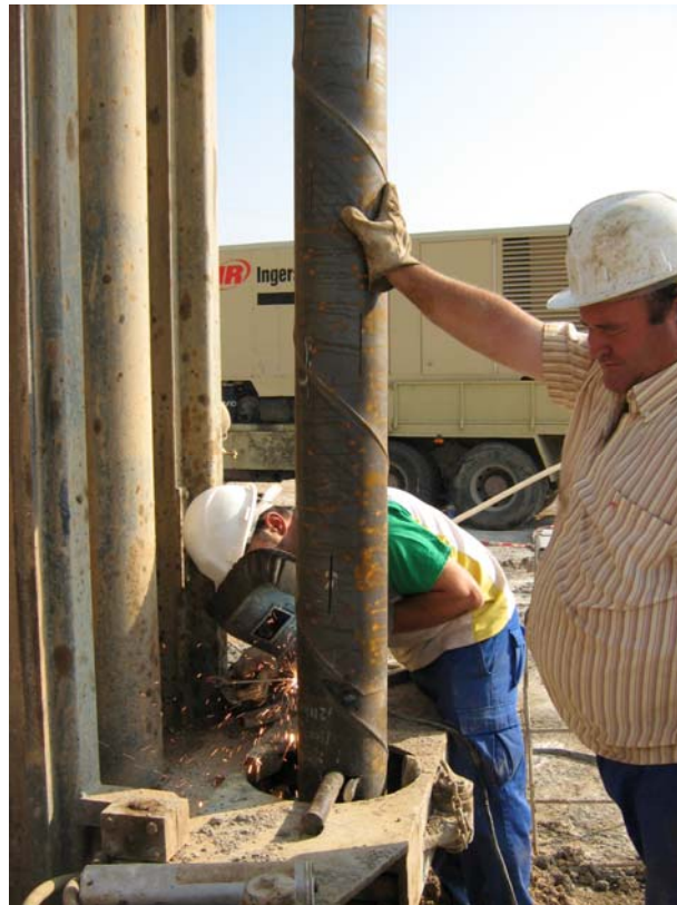
Soldando un tramo de tubería ranurada a un tramo ciego
