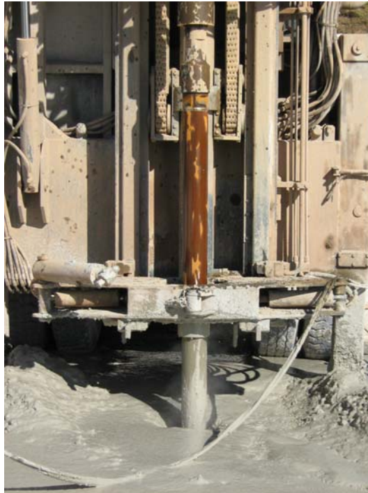
Perforando a 324 mm de diámetro
