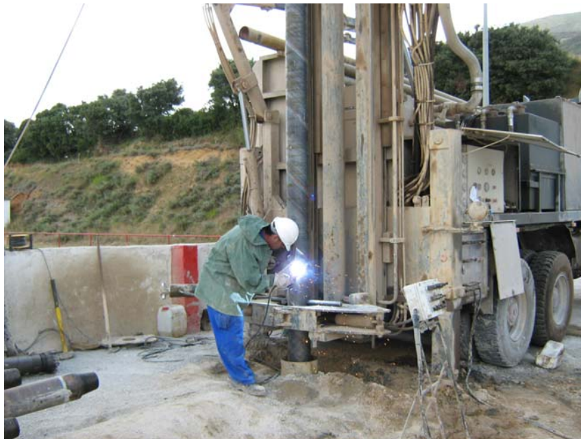
Soldando dos tramos de tubería ciega
