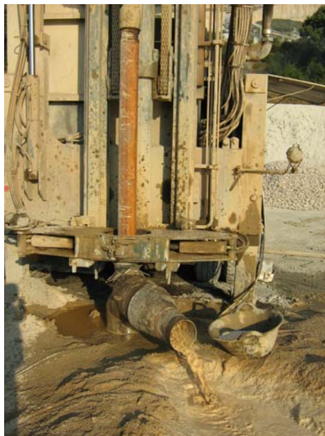
Perforando a 234 m de profundidad
