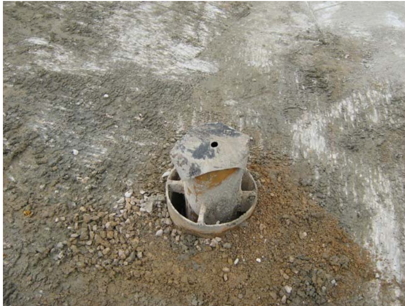
Sondeo tapado con chapa metálica a la espera de la instalación del dado y la arqueta.
