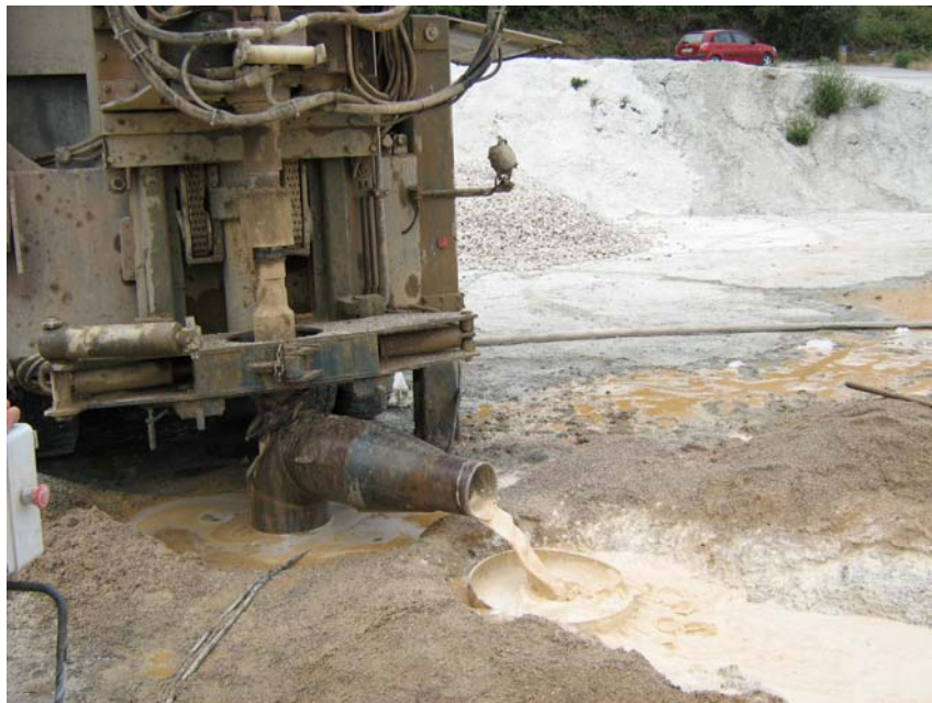
Perforando a 248 m de profundidad
