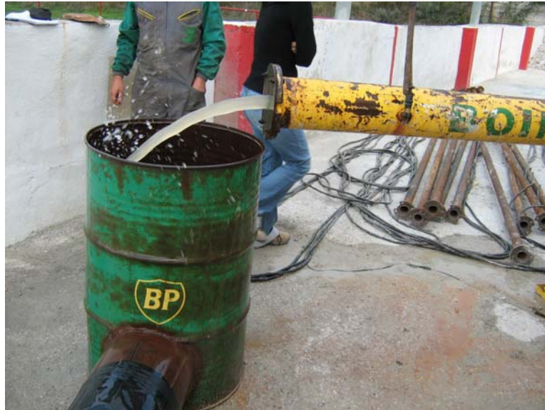
18:30 h, tercer escalón (agua casi clara, 3 l/s)
