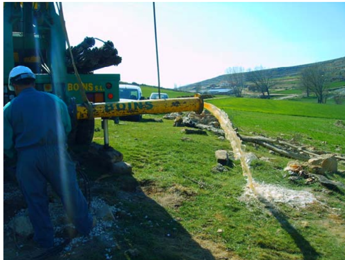
Agua turbia al comenzar el aforo
