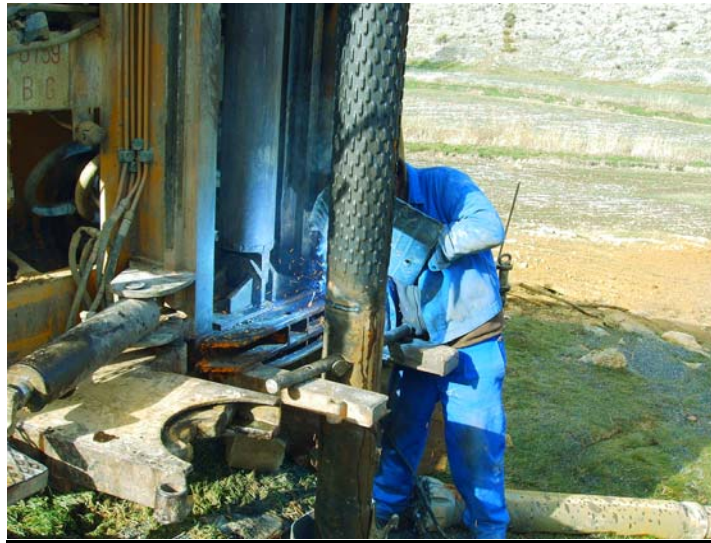
Soldando las tuberías
