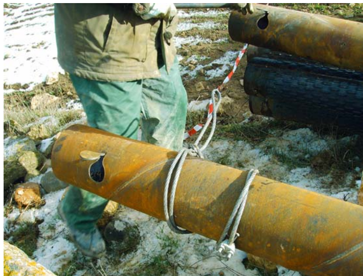
Detalle orejetas abiertas y cable que irá unido al gancho elevador de la máquina
