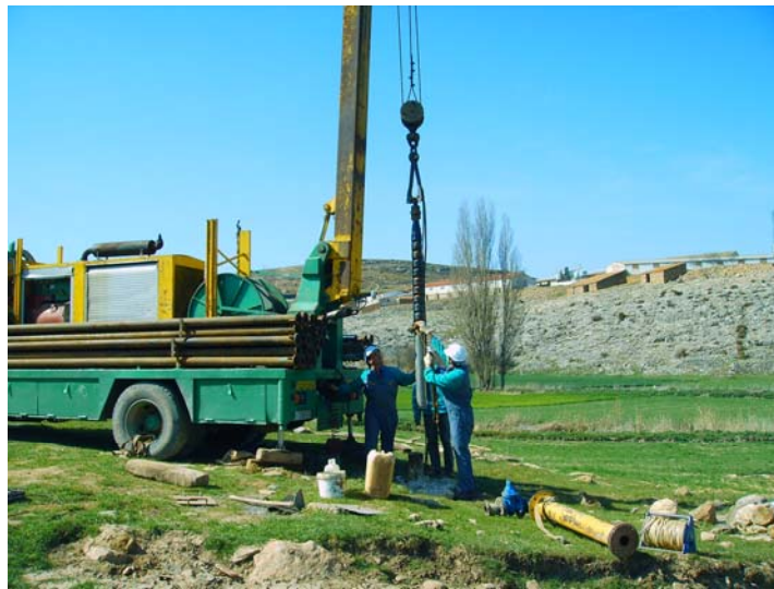
Bajando la bomba para introducirla
