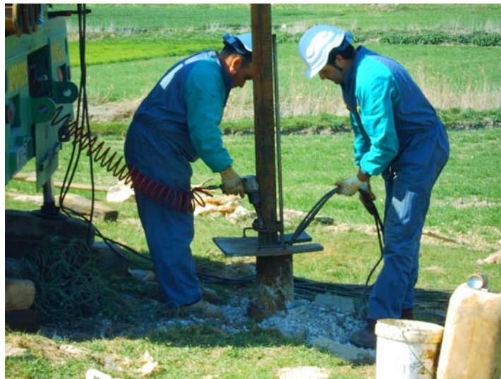
Uniendo las tuberías con el taladro
