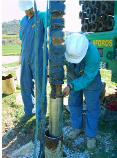
Detalle bomba y rodetes
