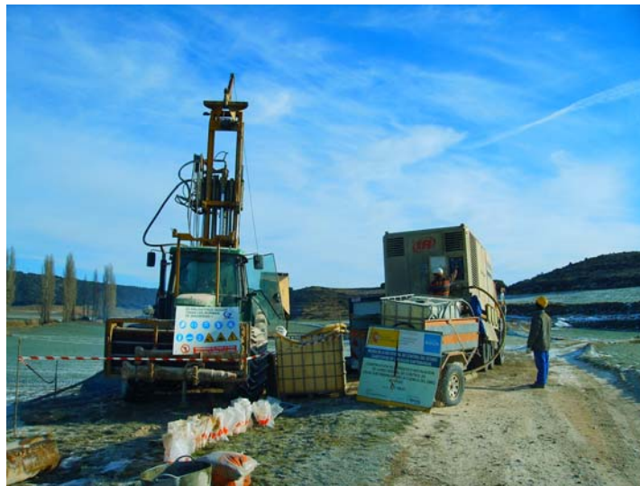
Vista del emplazamiento
