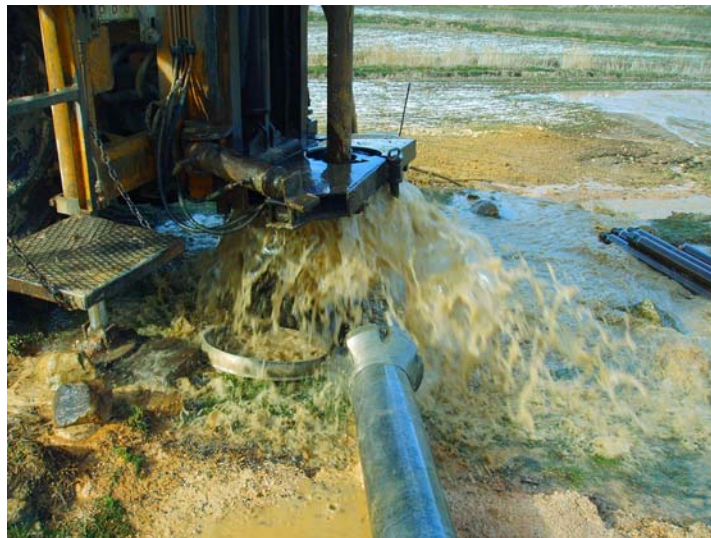
Perforando a 52 m de profundidad
