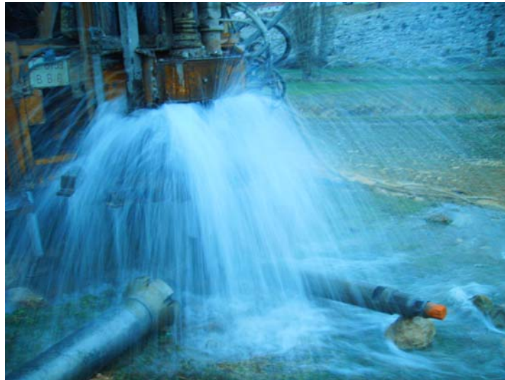
Agua con una turbidez prácticamente nula al final de la limpieza (18:30)
