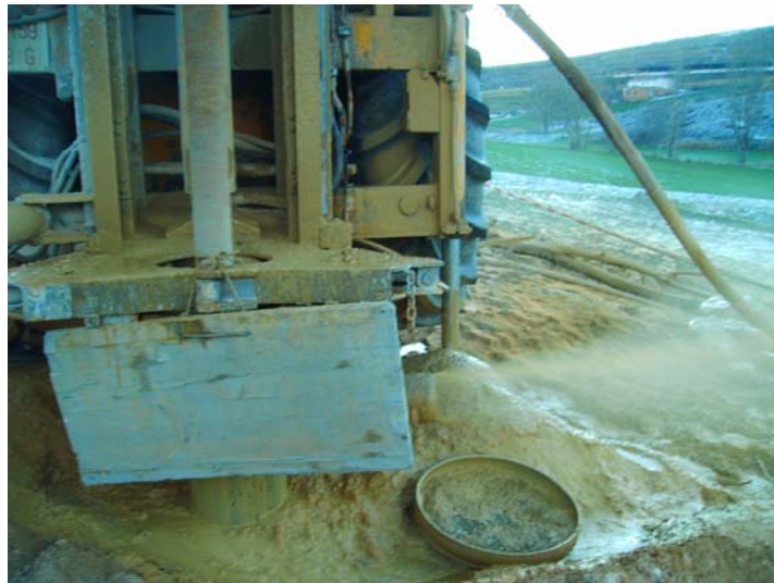
Perforando en el momento que se corta nivel
