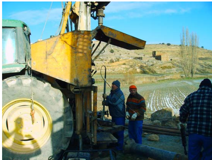
Introduciendo la sonda hidrogeológica
