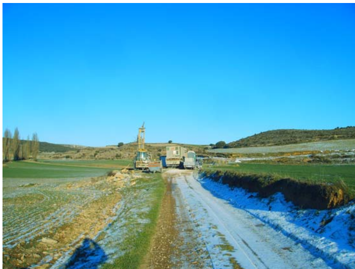
Emplazamiento de la maquinaria
