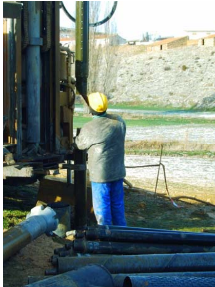
Martillo en superficie para ser desobstruido
