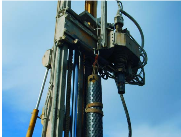
Detalle de la tubería al ser elevada
