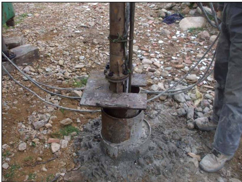
**Imagen 2.** Instalación del equipo de bombeo.
