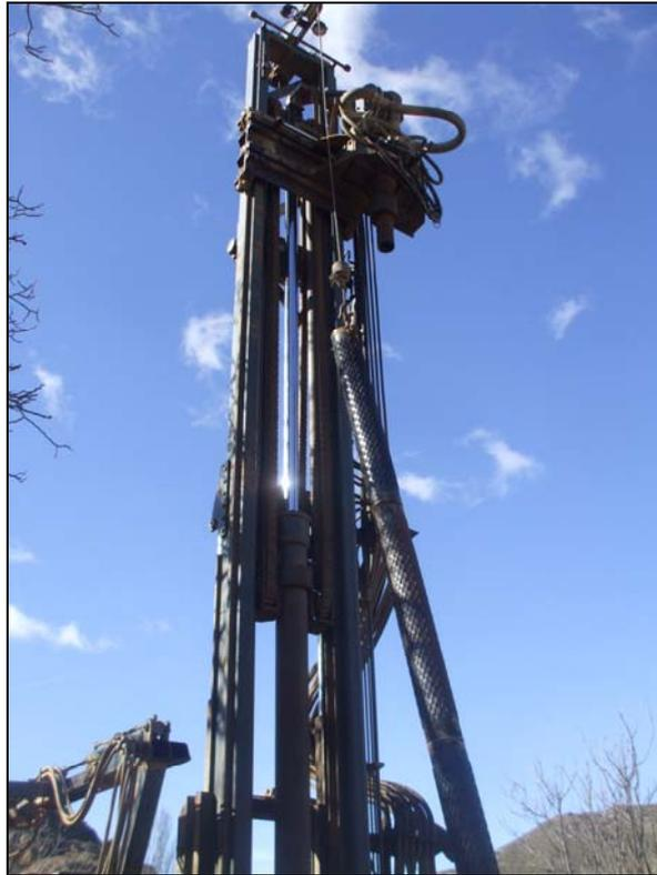
*Imagen 9. Labores de entubación del sondeo.*
