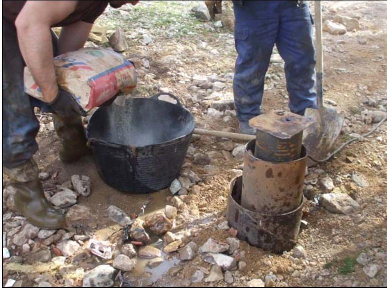
*Imagen 12. Cementación del emboquille del sondeo.*
