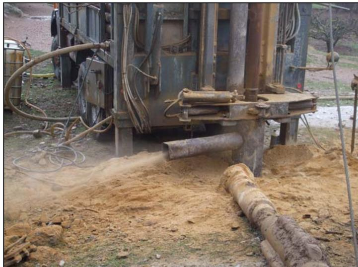
**Imagen 4.** Perforación del sondeo por el interior del emboquille.
