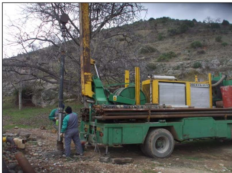
*Imagen 1. Vista general del equipo de bombeo, durante la colocación de la bomba.*
