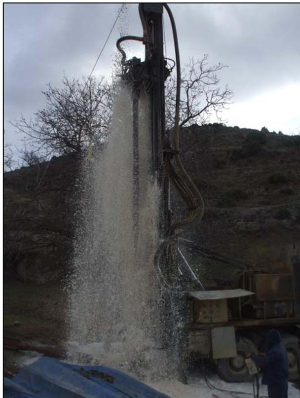
*Imagen 6. Perforación del sondeo.*
