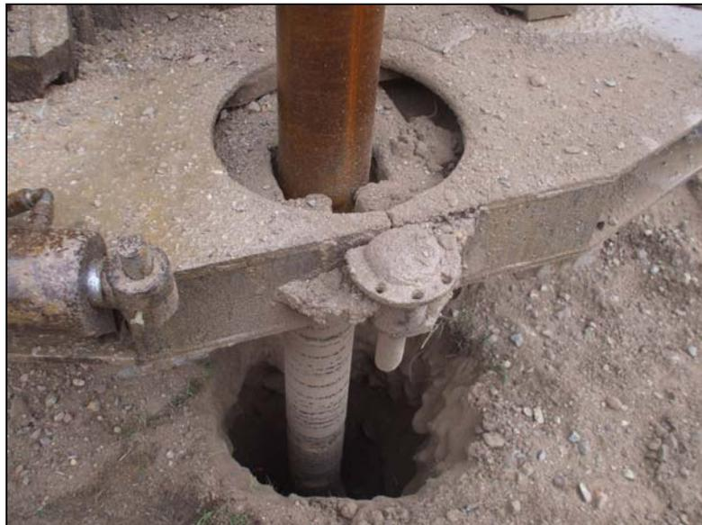
*Imagen 2. Perforación del emboquille.*
