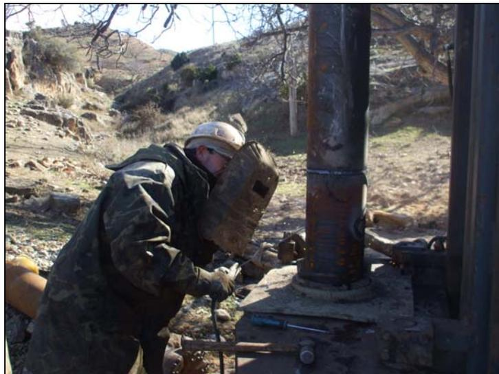
*Imagen 10. Soldadura durante la entubación del sondeo.*
