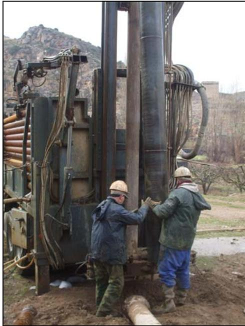
**Imagen 3.** Colocación de la tubería de emboquille.
