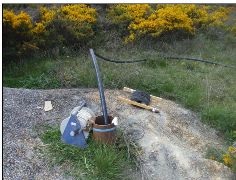
Imágenes 2 y 3. Inyección de agua en el sondeo.
