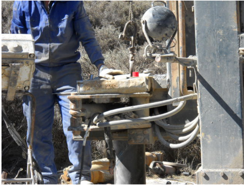
Fig.7. Finalización de la entubación del sondeo de Valdeprado
