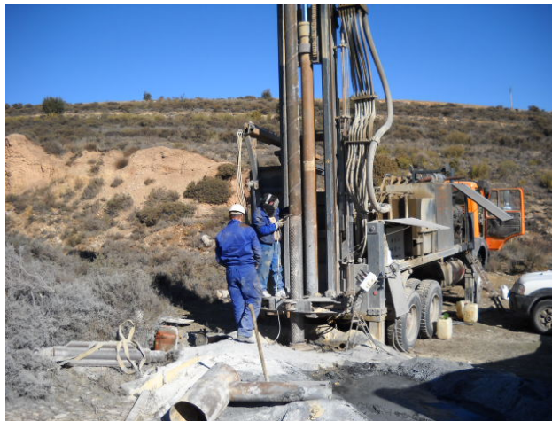
Fig. 6. Soldadura de los tramos de entubación del sondeo de Valdeprado
