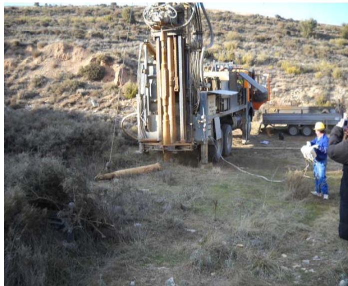
Fig.2. Comienzo de los trabajos de realización del Emboquille en el sondeo de Valdeprado.
