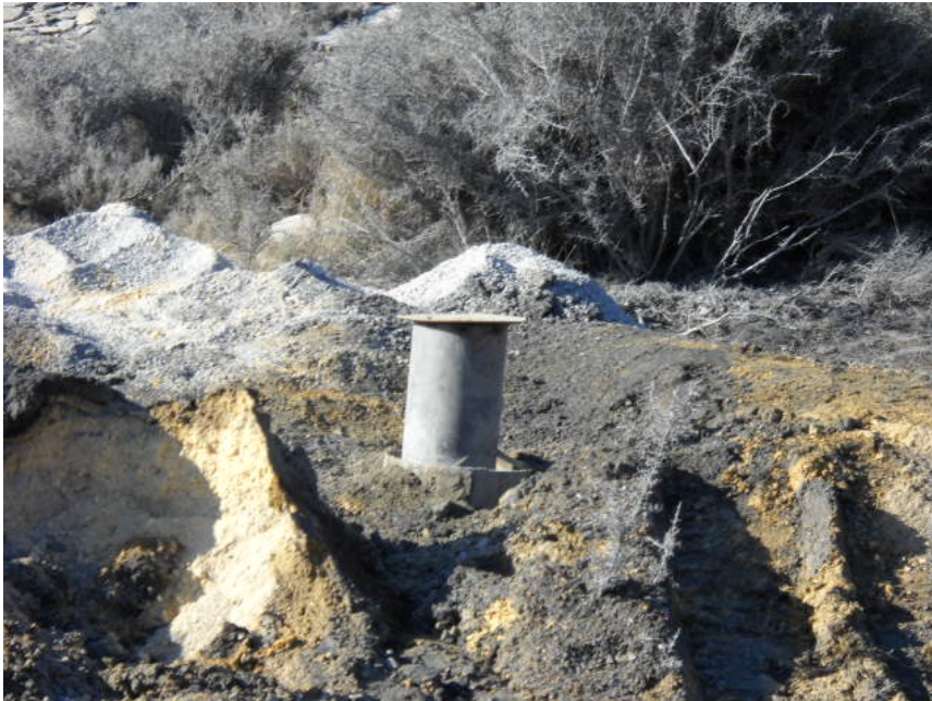
Fig.9. Aspecto final de el emboquille provisional del sondeo de Valdeprado.
