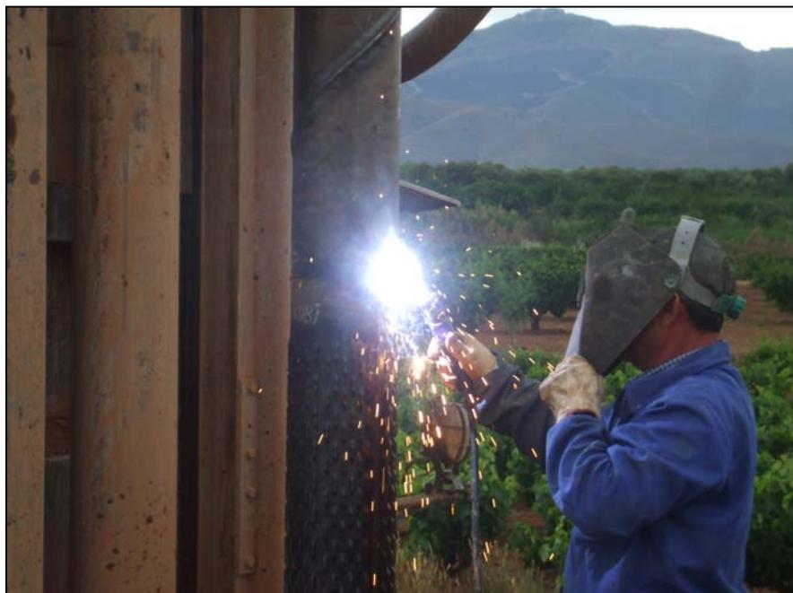
*Imagen 12. Trabajos de soldadura durante la entubación del sondeo.*
