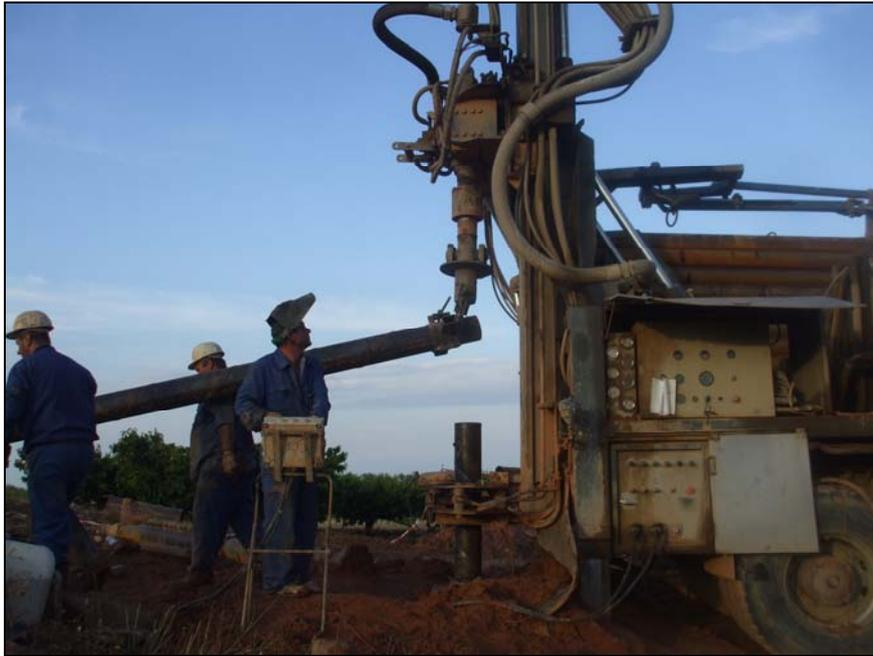
**Imagen 13.** Colocación de tubería durante la entubación del sondeo.
