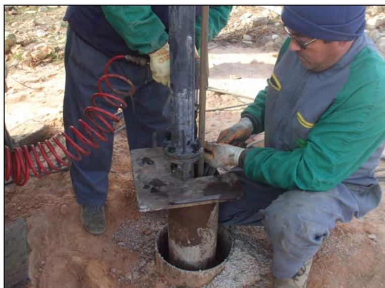
**Imagen 2.** Instalación del equipo de bombeo.
