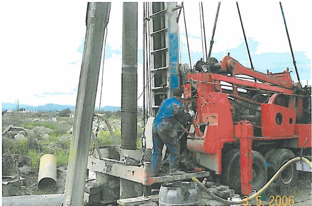
Entubación del piezómetro
