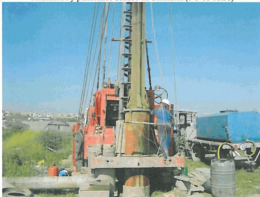
Piezómetro y perforando sondeo en Calahorra (1-5-06 10:30)
