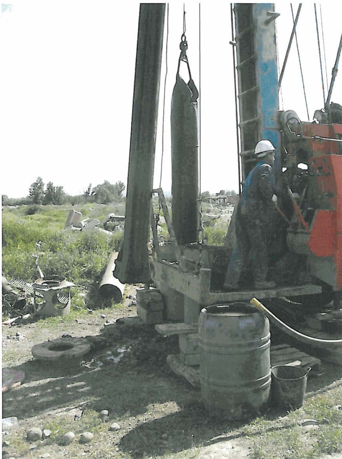
Proceso de evacuación del detritus extraído con la cuchara.
