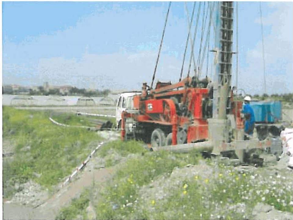
Finalizando la perforación del piezómetro de Calahorra (28-7-06 13:00)
