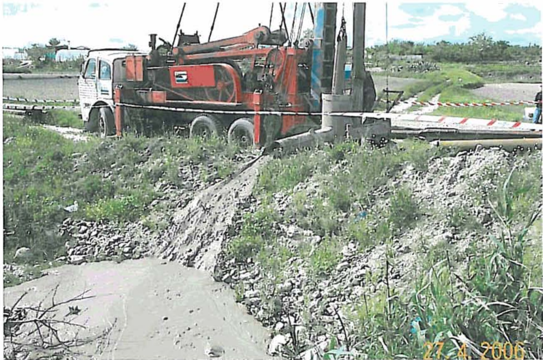
Detalle de la perforación y la excavación utilizada como balsa para el detritus extraído.
