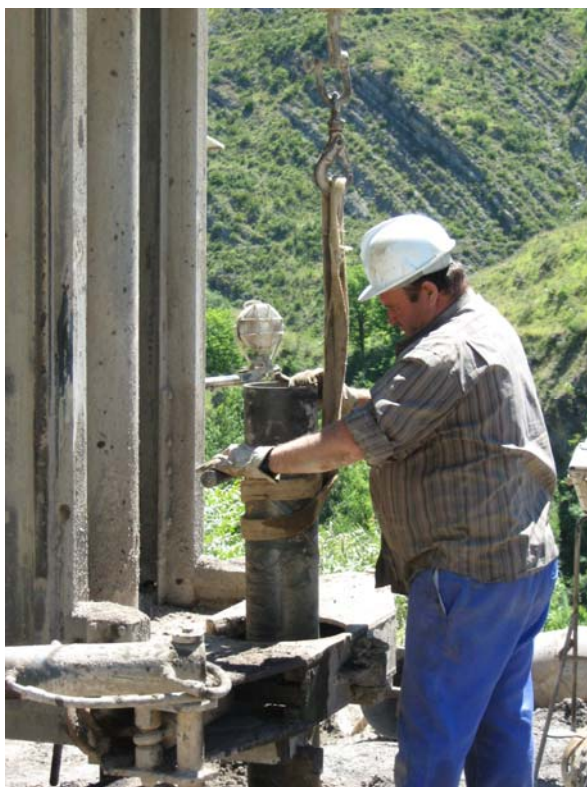
Introduciendo un tramo de tubería ciega de 180 mm
