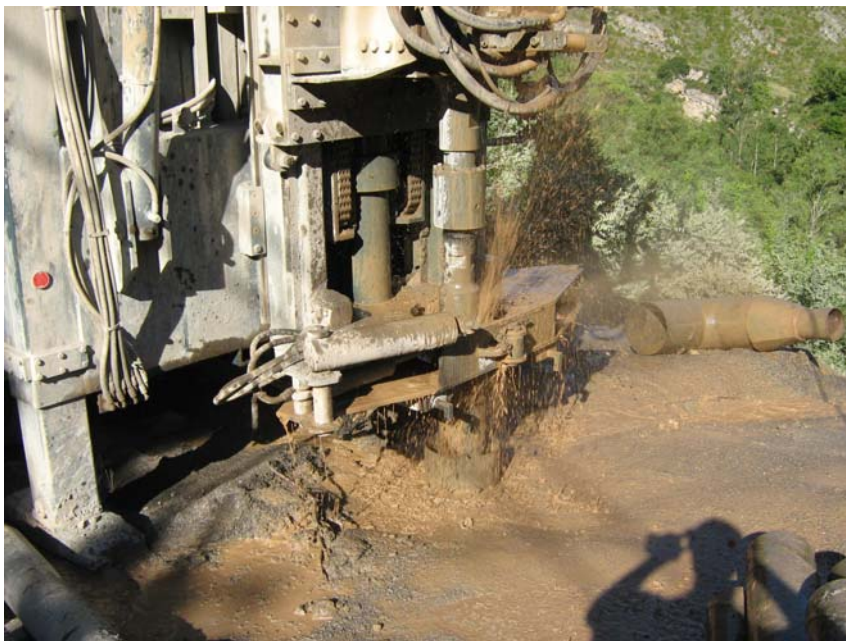
Comienzo limpieza. Agua muy turbia.
