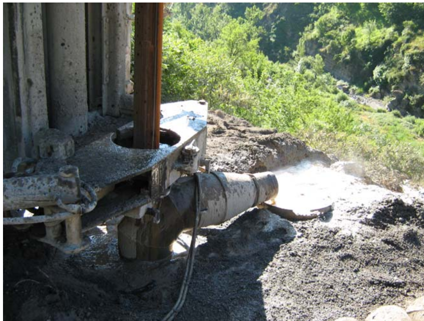
Perforando a 143 m de profundidad
