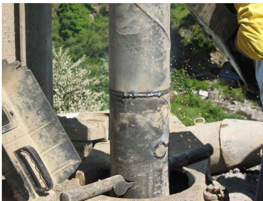
Soldadura entre tuberías y cerrando orejetas
