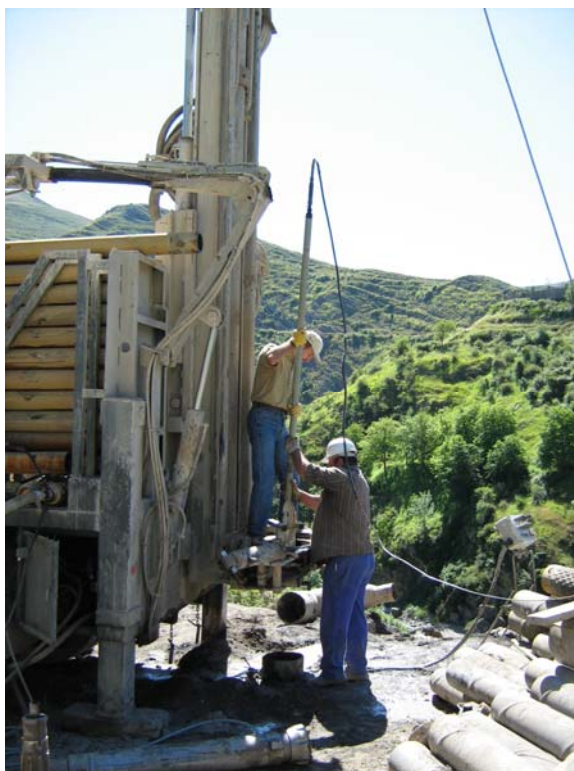
Introduciendo la sonda hidrogeológica
