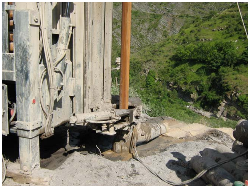
Perforando a 90 m de profundidad
