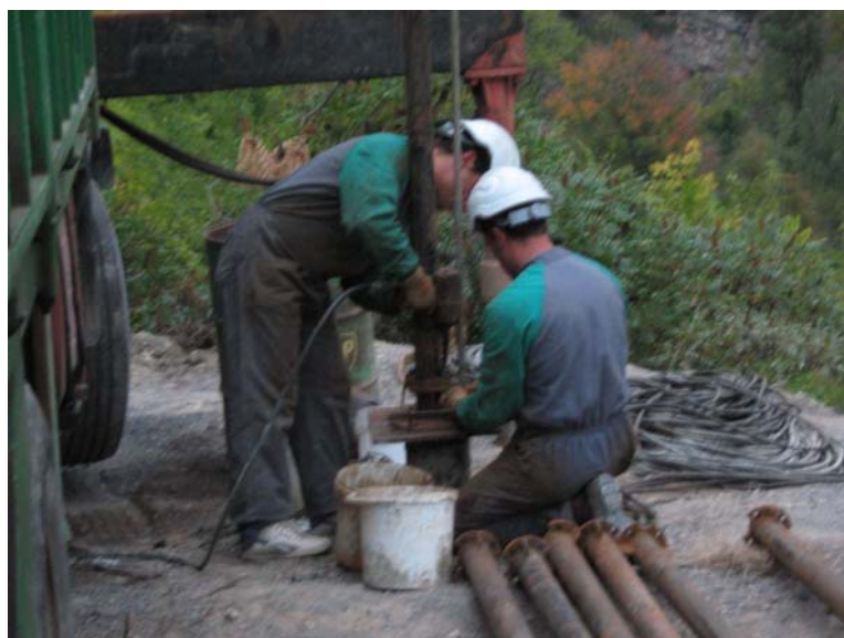
Uniendo tuberías con el taladro
