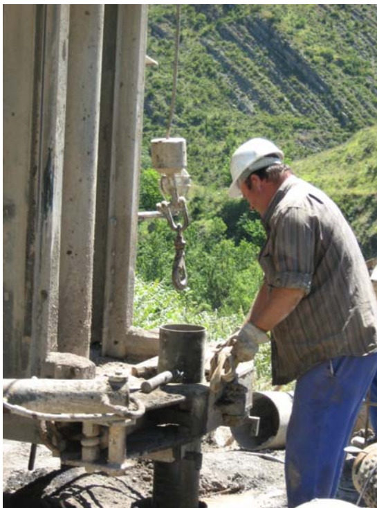
Tramo tubería ciega preparada para ser soldada a otro tramo
