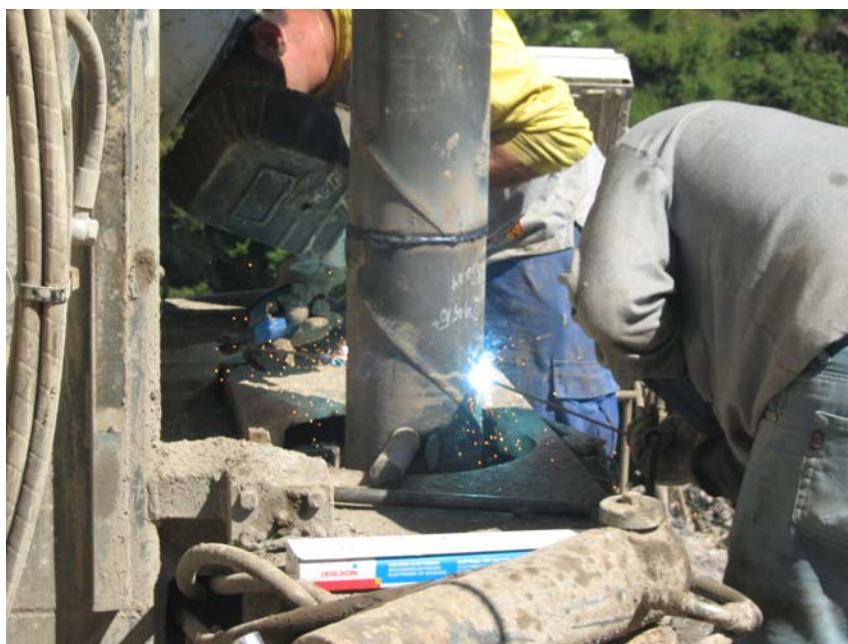
Soldando 2 tramos de tubería ciega de 180 mm
