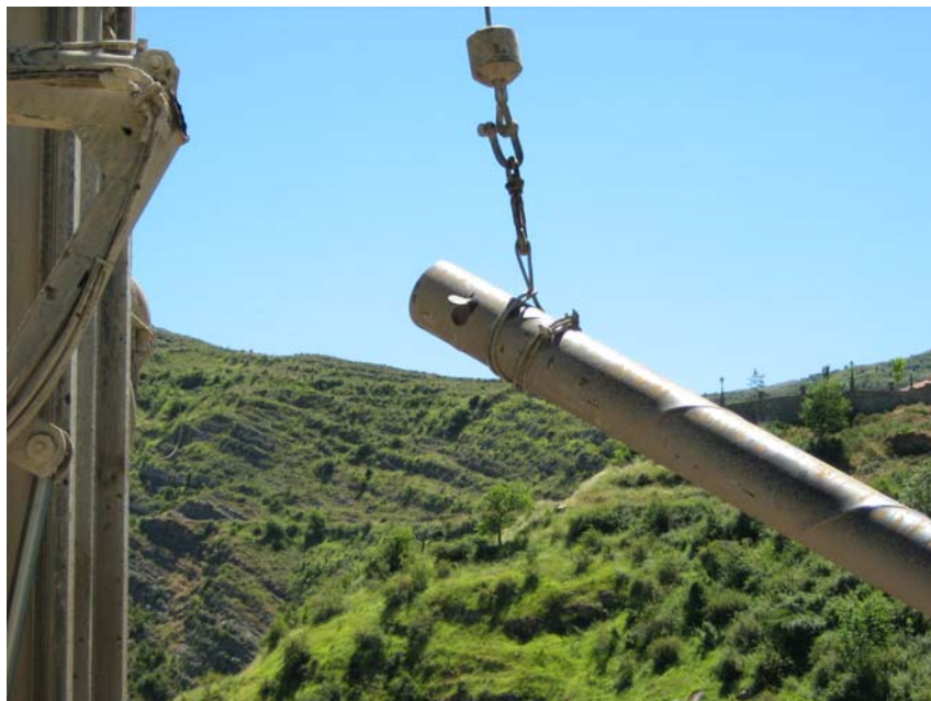
Detalle: tubería elevada con cablestante
