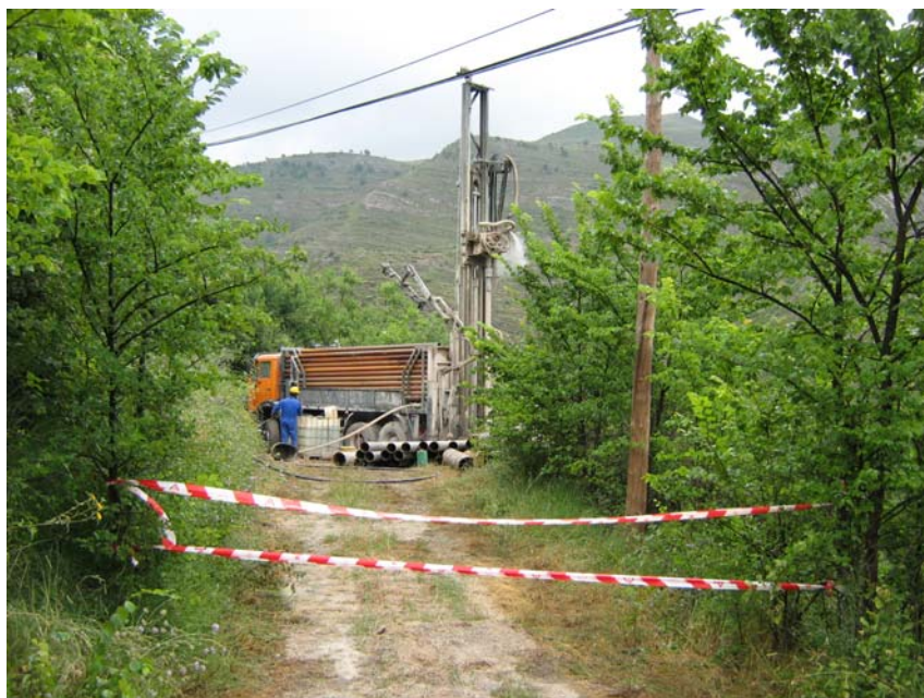
Emplazamiento con la maquinaria ya instalada
