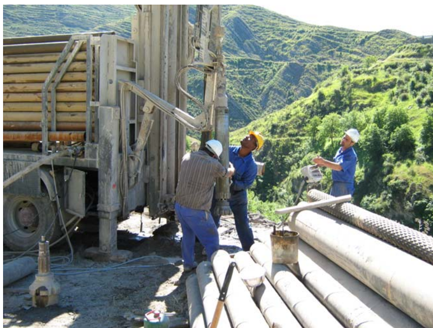
Extrayendo el martillo de 220 mm de diámetro
